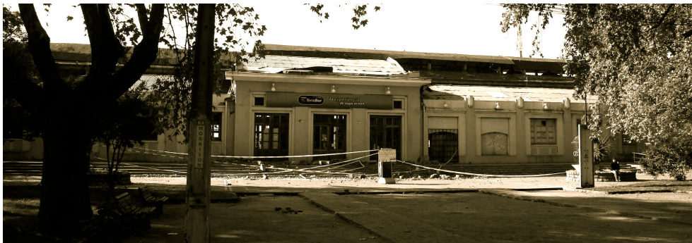
Figura 38 Estação de Talca.
