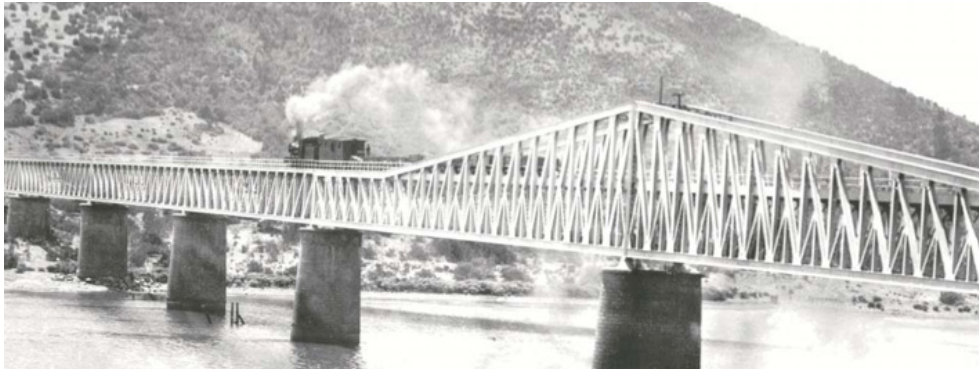
Figura 19 Ponte Banco de Arena. km.84 1925
