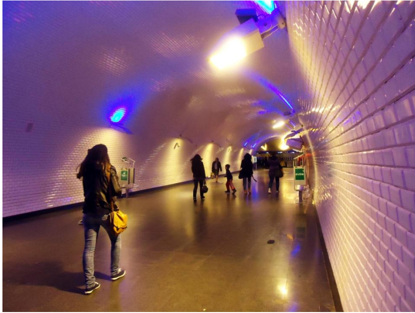
90 - Aspecto Interior da Estação de Metro do Chiado.
