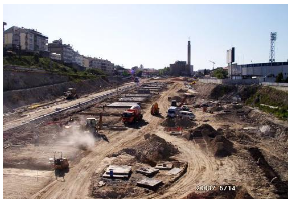
36 - Obras de abertura da Alameda 2003.
