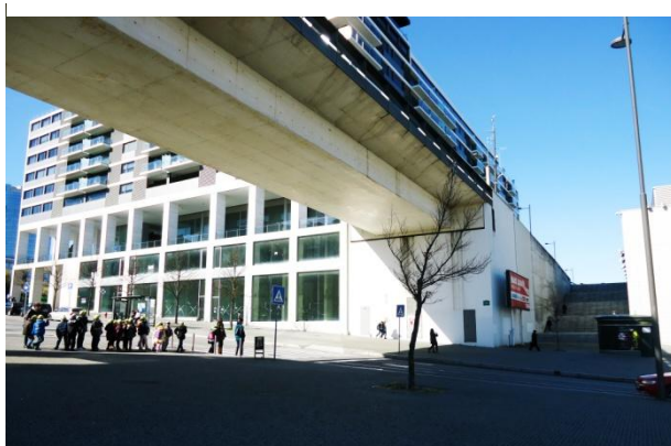
38 - Escadaria de Acesso ao Viaduto. Nascente.
