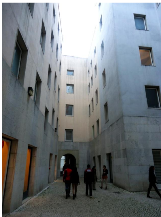
70 - Pátio Sul. Bloco B.
