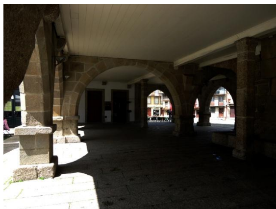
151 - Arcadas do edifício do antigo Paços do Concelho.
