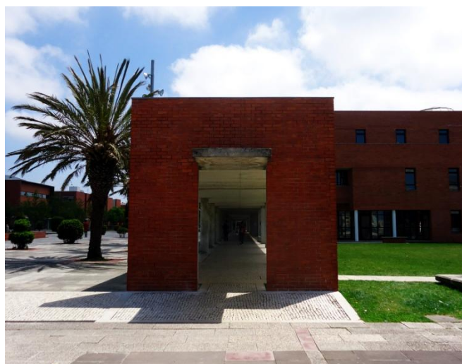
122 - Pórtico de acesso à Galeria.
