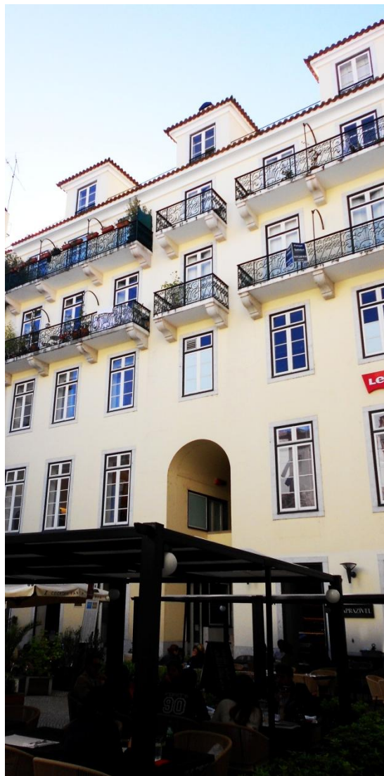
85 - Acesso Norte ao Bloco A.
