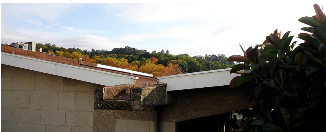
31 - Enquadramento do Castelo de Santa Maria da Feira através das coberturas.
