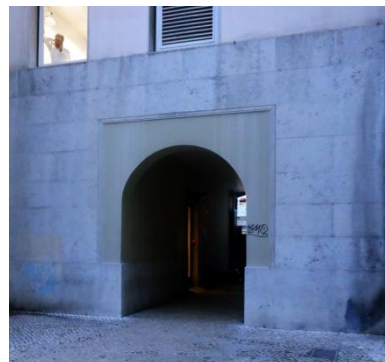
72 - Acesso Sul. Bloco B.
