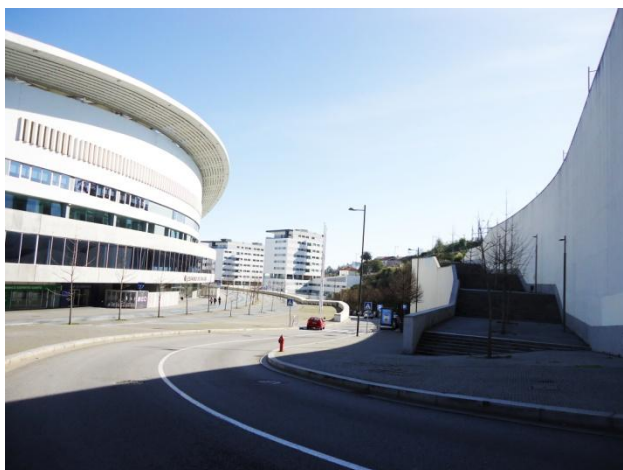
37 - Escadaria de Acesso ao Viaduto. Poente.
