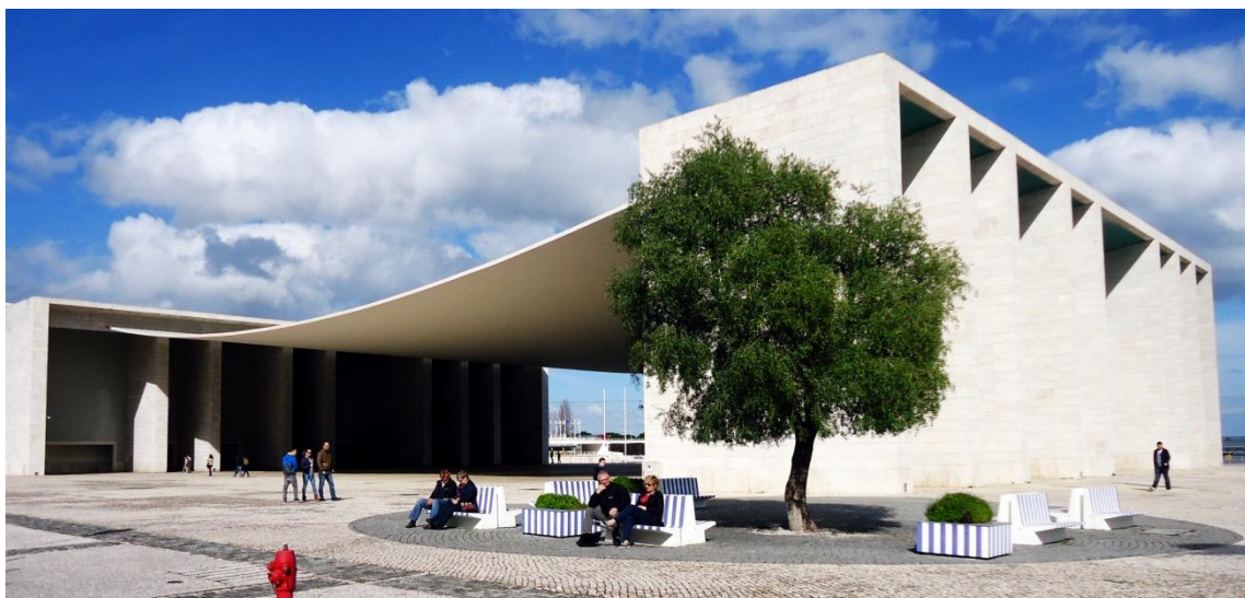
50 - Pavilhão de Portugal. Álvaro Siza, 1998.
