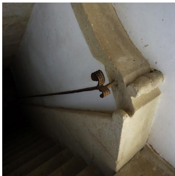
75 - Pormenor do Corrimão do Mosteiro de Tibães.
