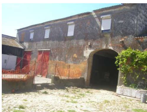
Figura 73. Dependências agrícolas. Construção que alberga o coberto da desfolhada, adega e tulha
