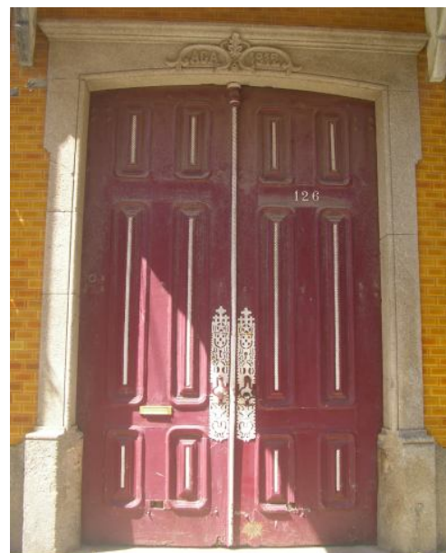
Figura 68. portal quadrangular de acesso desde a rua Fundo de Vila
