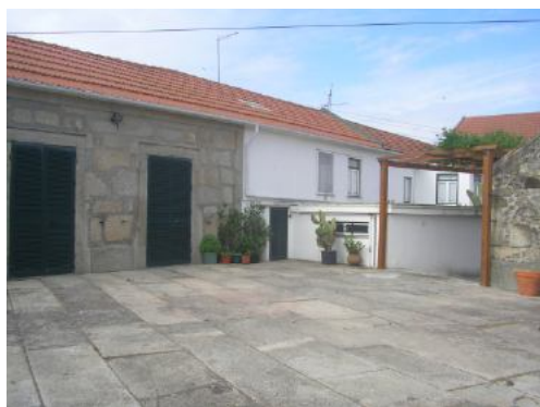
Figura 41. conjunto varanda da eira e tulha (volume contíguo)
