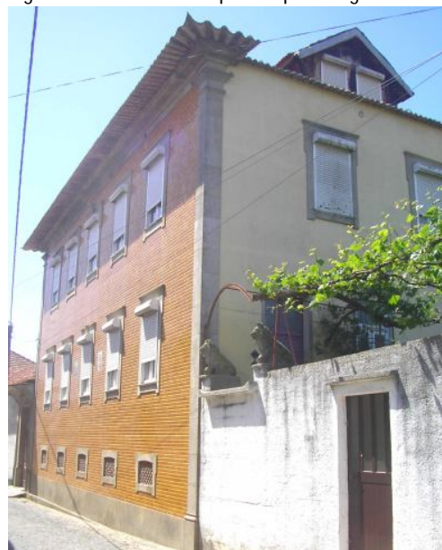
Figura 70. fachada da casa
