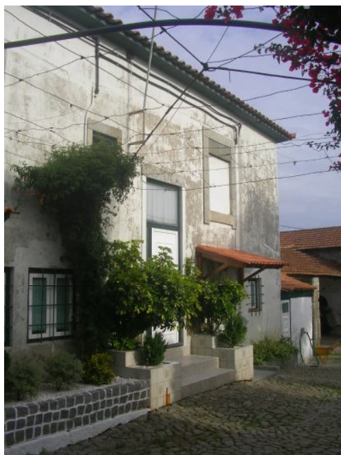
Figura 53. fachada interior da casa, datada de 1868
