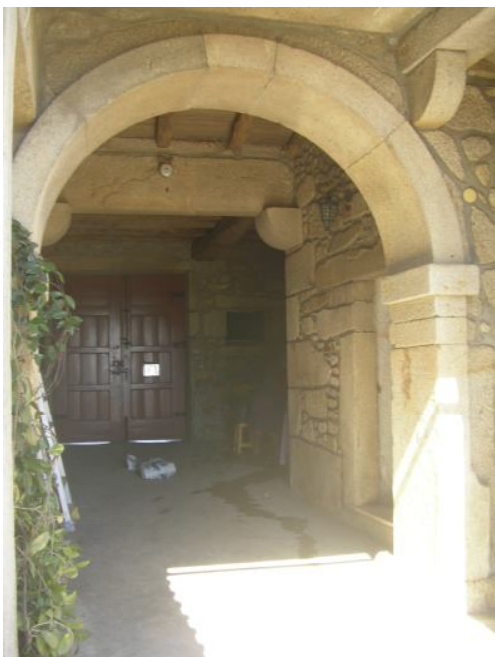
Figura 18. Portal de passagem em arco, na Casa do Grilo , em Fajozes
