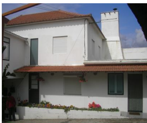
Figura 40. fachada interior, vista desde o quinteiro . Apesar das alterações realizadas, as aberturas ter-se-ão mantido semelhantes às originais
