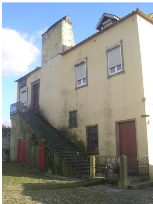
Figura 71. fachada interior norte da casa
