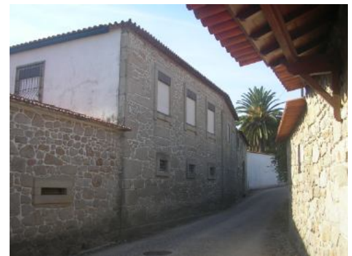
Figura 52. fachada da rua de Sarinhães. Divisões na fachada das 3 fases de construção: em primeiro plano a de 1868, contígua à de 1786, e em último plano a de 1887, com o portal em arco
