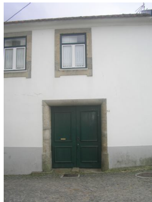
Figura 38. portal quadrangular de acesso à casa
