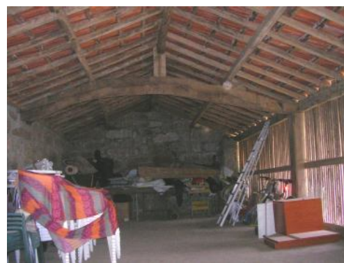
Figura 58. tulha no primeiro piso dos aidos
