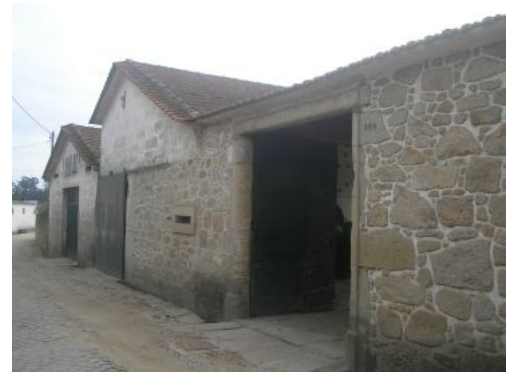
Figura 51. fachada da rua de Sarinhães e portal quadrangular de 1868
