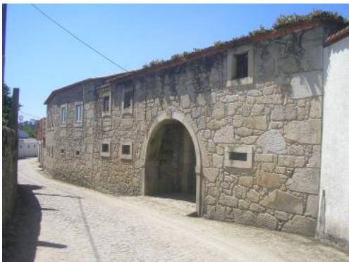
Figura 17. Portal em arco da Casa do Mendonça , em Fajozes
