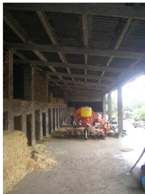
Figura 120. aidos bastante alterados, Casa do Grilo
