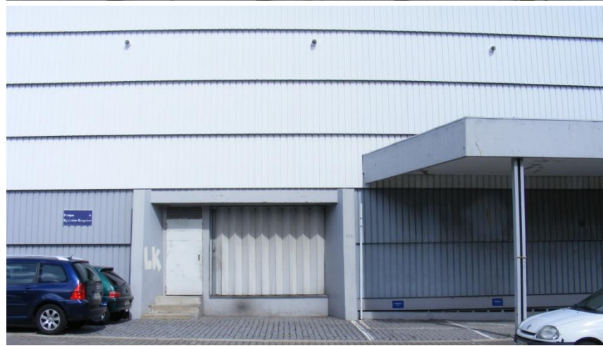
Figuras 135 e 136: revestimentos diferentes – fibrocimento e betão
