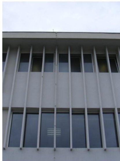
Figuras 101 a 103: fachadas poente e nascente do volume de armazéns
