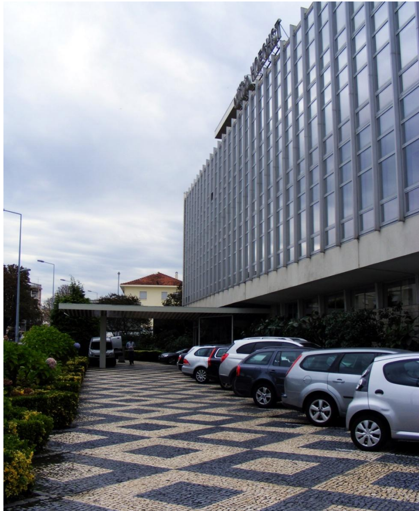
Figura 86: fachada norte – cortina de vidro
