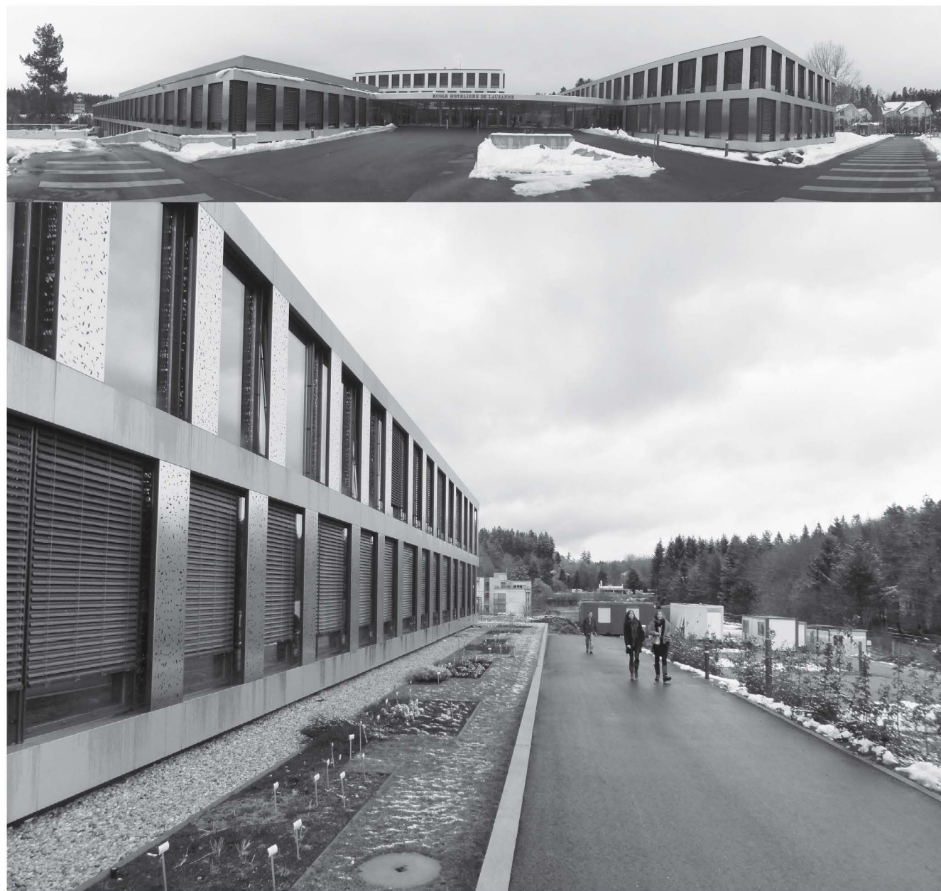
fig. 091• Fotografia panorâmica da imagem geral da fachada da Escola † †
