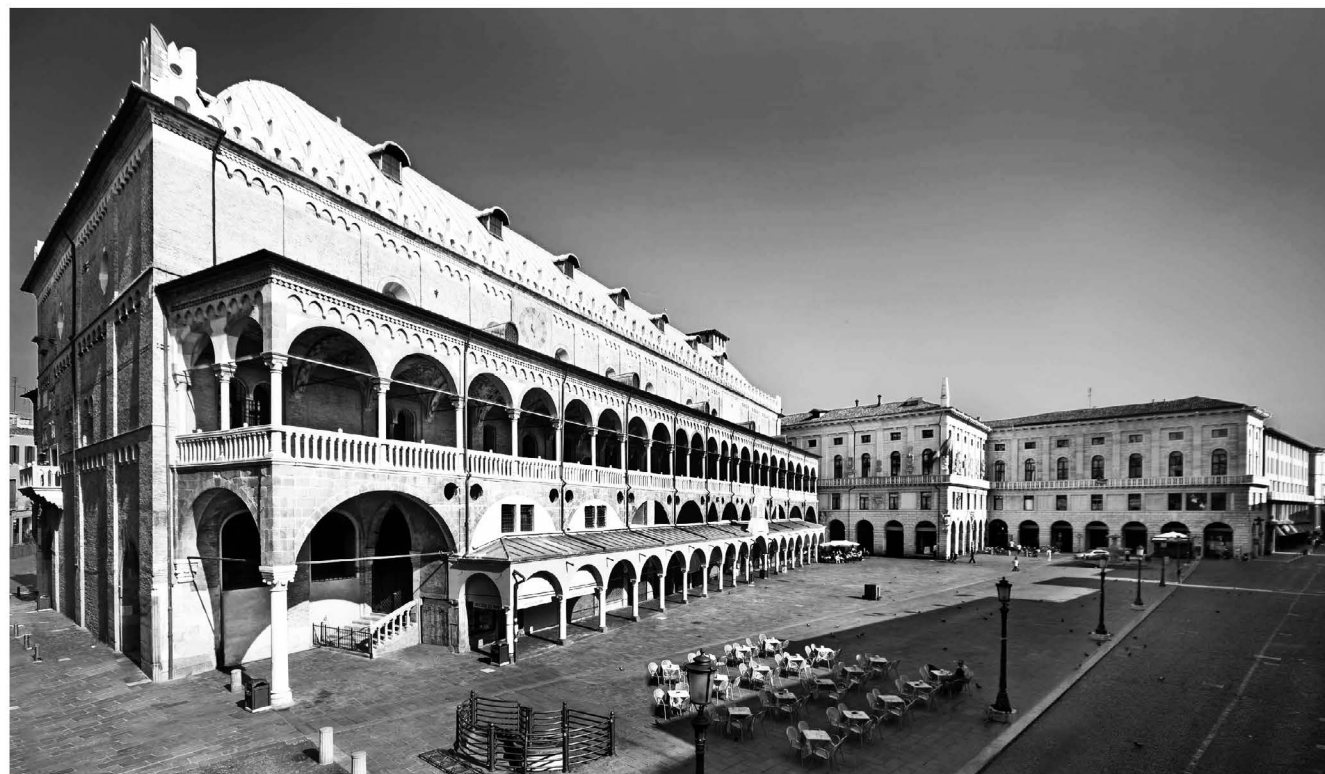
fig. 052 • Palazzo della Ragione, Pádua, construído em 1218 ↑
