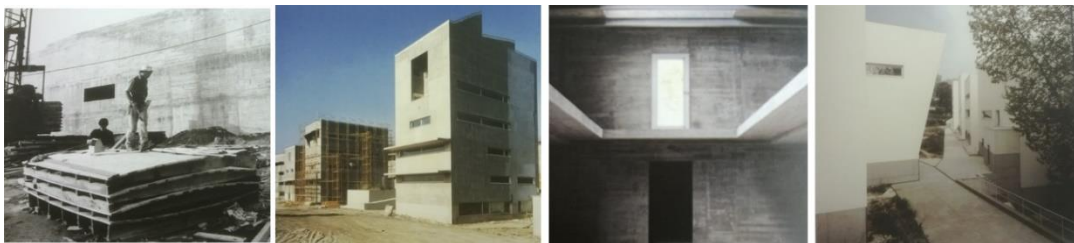
Figura 25; 26; 27; 28. Desenvolvimentos da construção da Faculdade de Arquitetura da Universidade do Porto - FAUP
