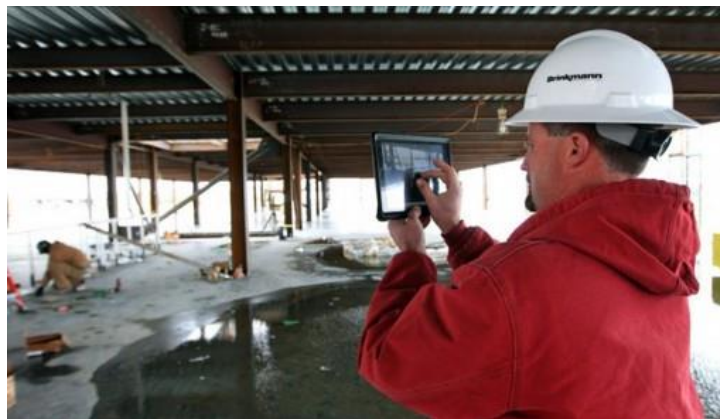
Figura 33. Utilização de uma tablet na obra
