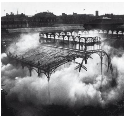
Fig.36 Paris, Les Halles, Demolição
