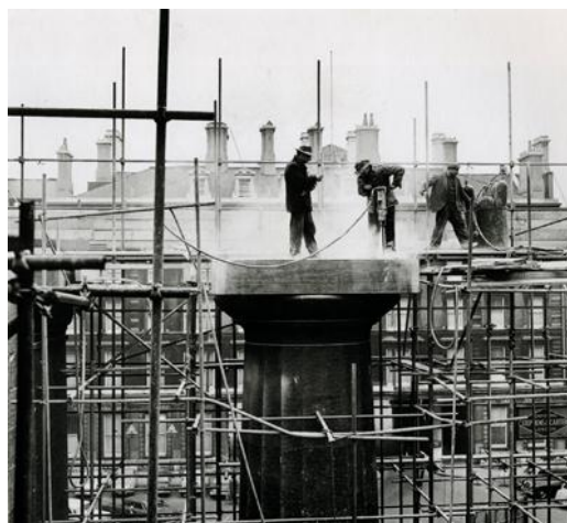
Fig.37 Londres, Estação de Euston, Demolição
