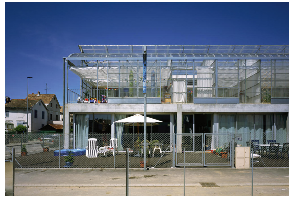
[165] Mulhouse: Vista Exterior
