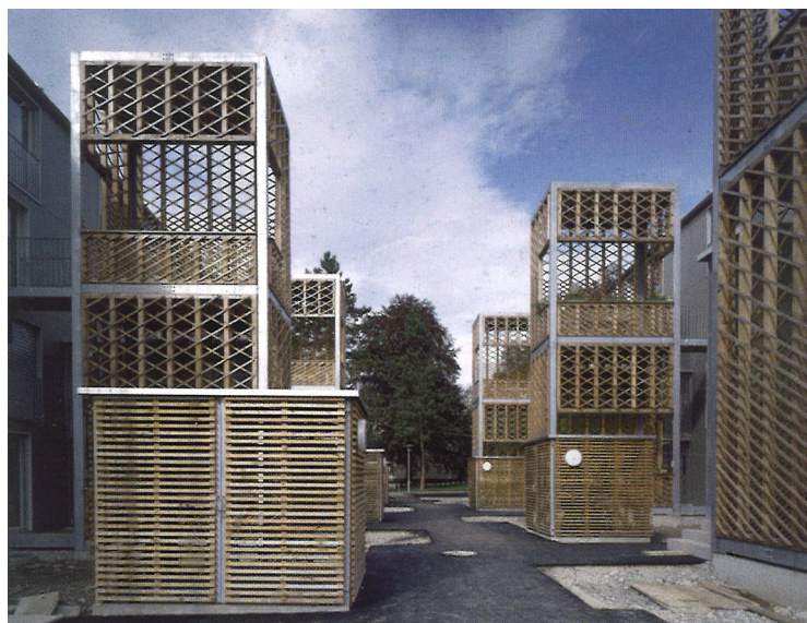
[201] Burriweg: Vista Exterior
