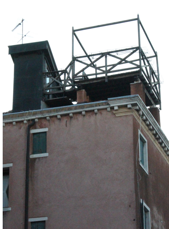
[212] Altana: Vista Exterior
