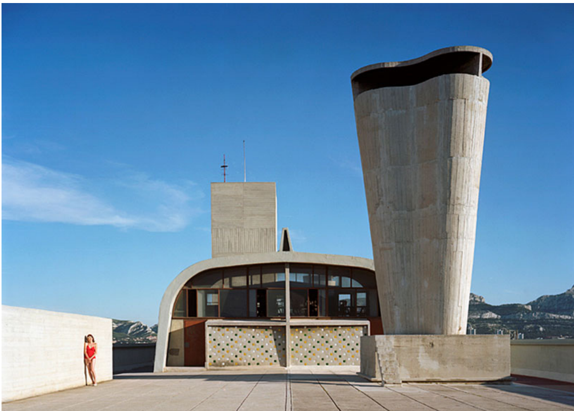
[242] Unité : Vista Cobertura
