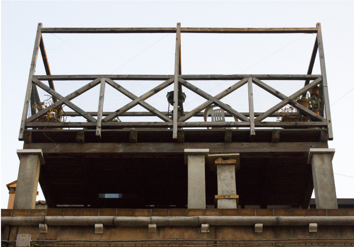
[203] Altana: Vista Exterior
