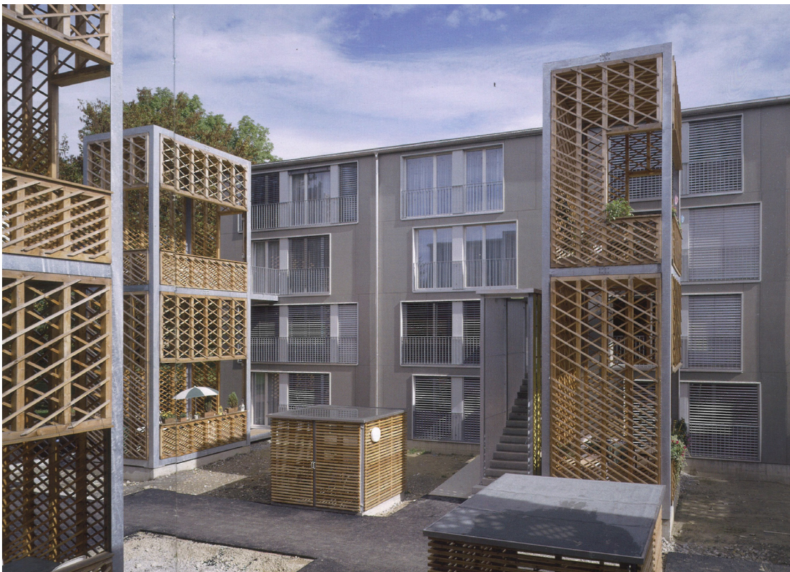
[197] Burriweg: Vista Exterior
