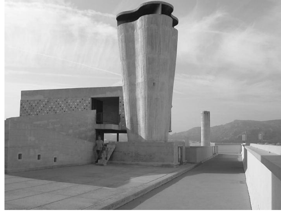
[241] Unité : Vista Cobertura
