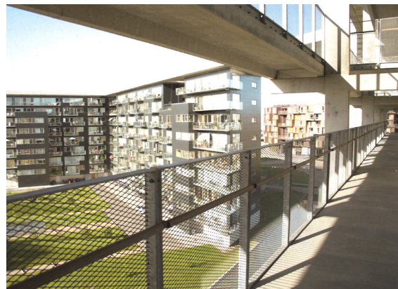
[216] Fælledhaven: Vista Galeria
