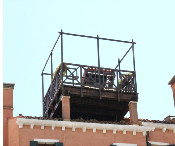
[208] Altana: Vista Exterior
