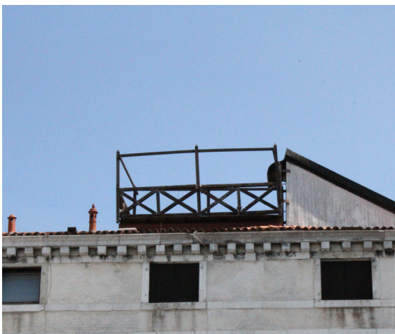
[209] Altana: Vista Exterior
