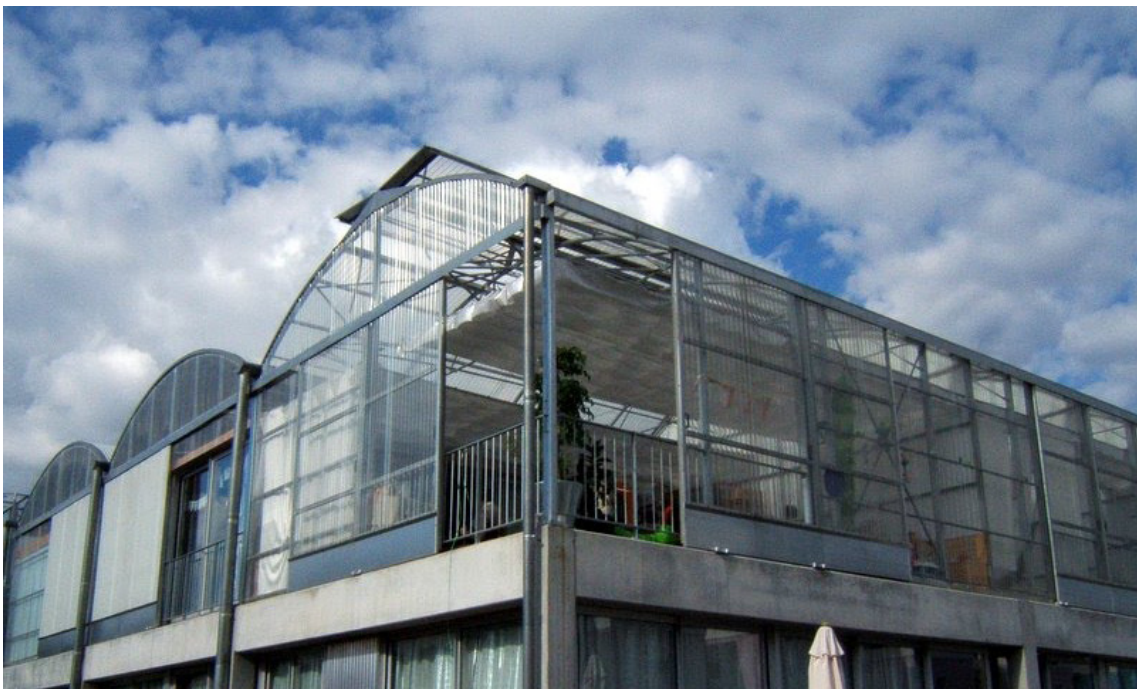
[166] Mulhouse: Vista Exterior
