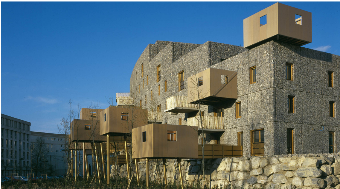
[190] Montpellier: Vista Exterior
