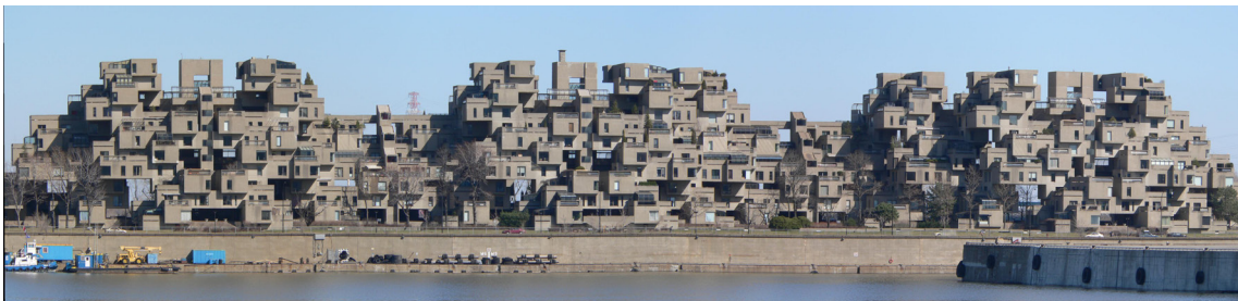
[86] Habitat 67: Vista Exterior
