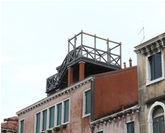
[204] Altana: Vista Exterior
