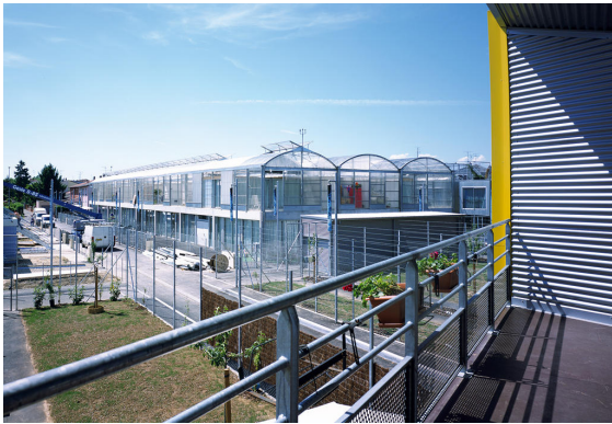
[164] Mulhouse: Vista Exterior
