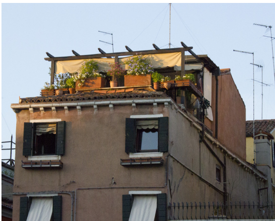
[205] Altana: Vista Exterior
