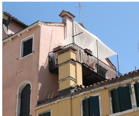
[210] Altana: Vista Exterior
