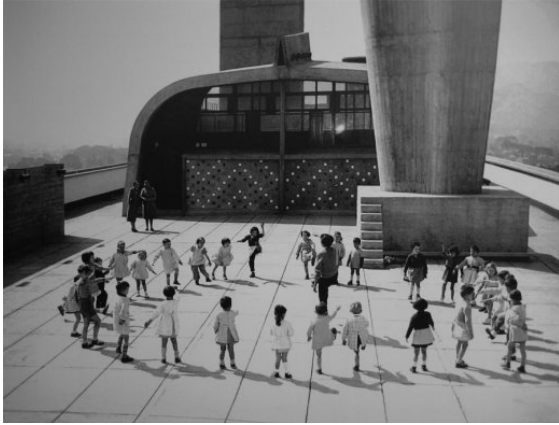
[240] Unité : Vista Cobertura
