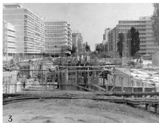
Construção da linha de metropolitano, em trincheira, na Avenida de Roma
