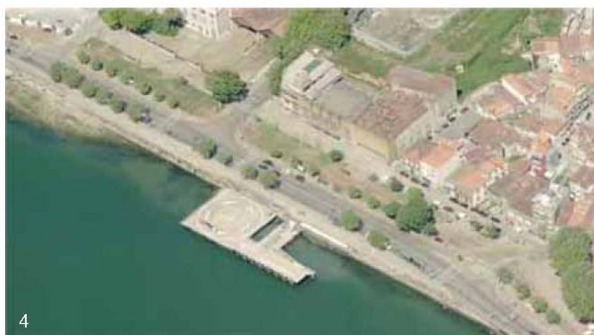
Vista aérea da Alameda Basílio Teles
