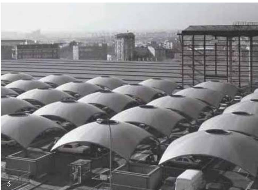
Vista da cobertura do parque de estacionamento
