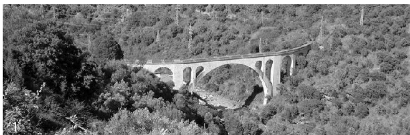
Ponte sobre o rio Varosa erigida no âmbito da construção da Linha do Varosa
