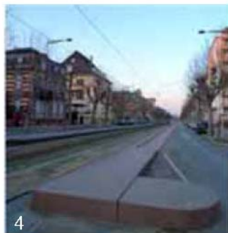
Pormenores das plataformas da Paragem de Parc du Contades
