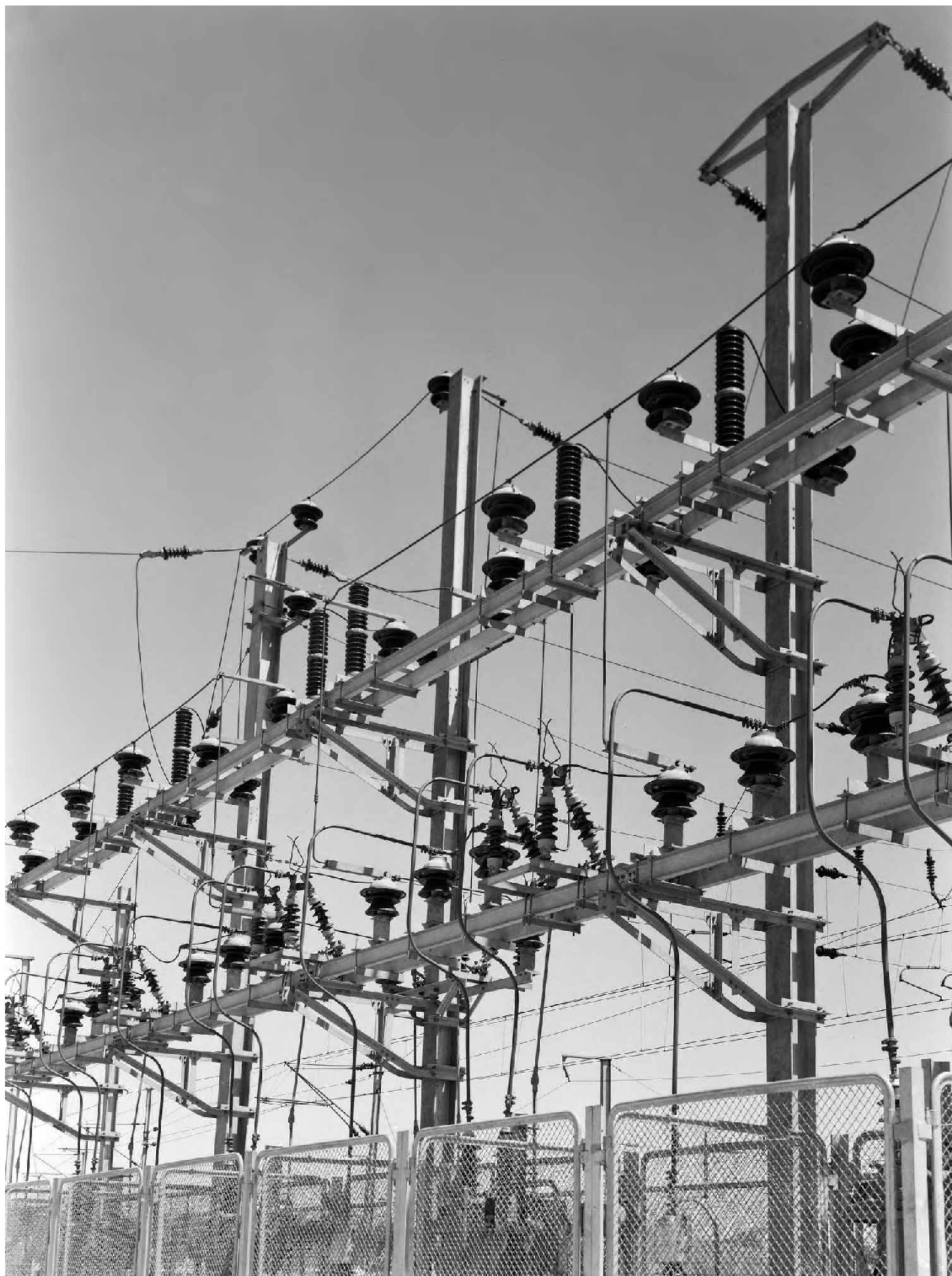
Aspecto do Sistema de electrificação da Linha do Norte. Década de 1960 Fotografia do Estúdio Mário Novais
