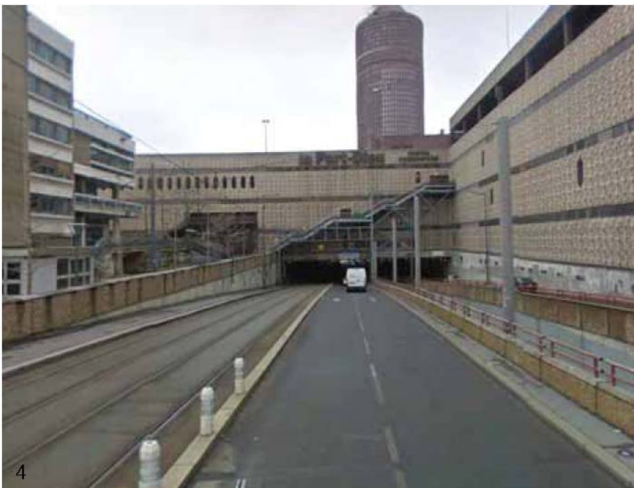
Vista do atravessamento da linha de eléctrico sob o edifício do Centro Comercial de Part-Dieu
