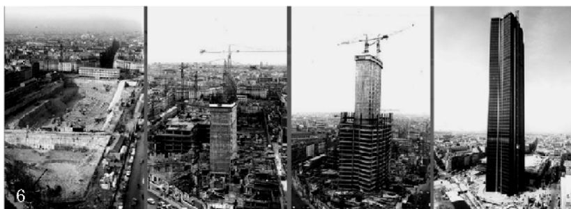
Construção da Torre de Montparnasse, Paris
