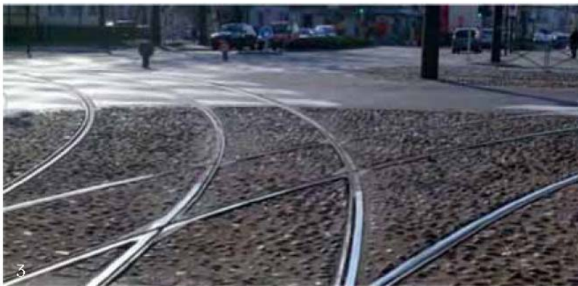
Detalhe do pavimento no cruzamento da via férrea com o canal de tráfego rodoviário na Avenue Jean Jaurès
