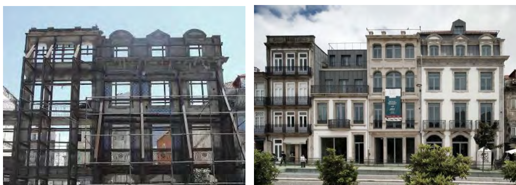
29. Durante a intervenção no quarteirão de Carlos Alberto 30. Fachada recuperada
