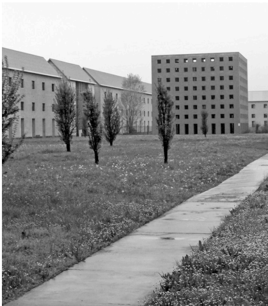
Fig.2 – Intervenções sobre pré-existências.
