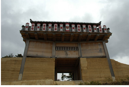
figura 143 Reconstrução de Portão do Castelo Ki, 2004
