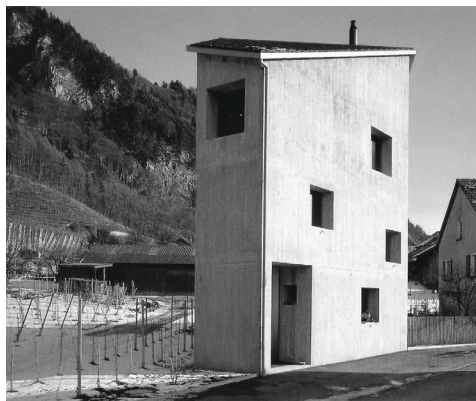
26. Casa Meuli, Fläsch, Graubünden, Suíça. Corte e fotografia. Bearth + Deplazes.
