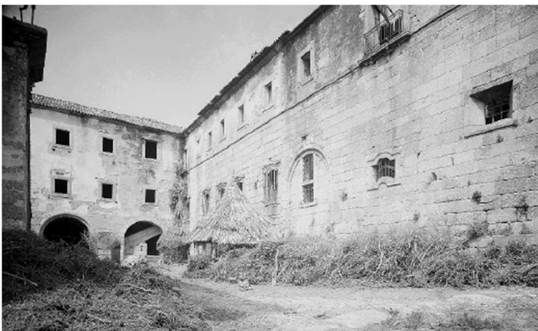
Pátio do Laranjal Antes da Intervenção [45]
