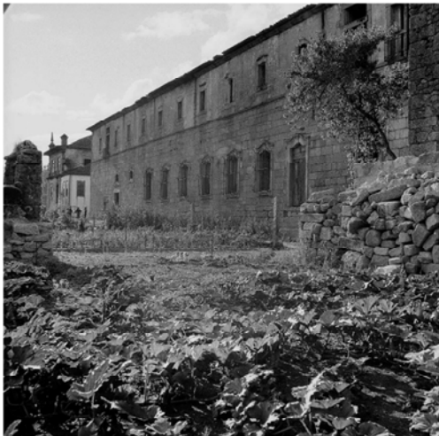
Fachada Sul Antes da Intervenção [43]
