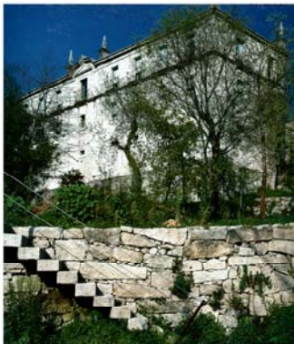
Vista Poente, Depois da Intervenção [52]
