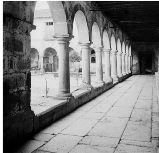
Claustro Antes da Intervenção [44]
