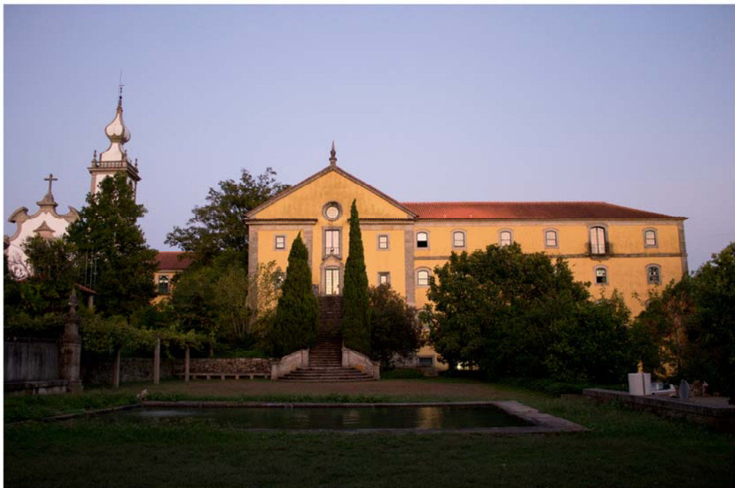
Vista da Fachada Nascente [22]
