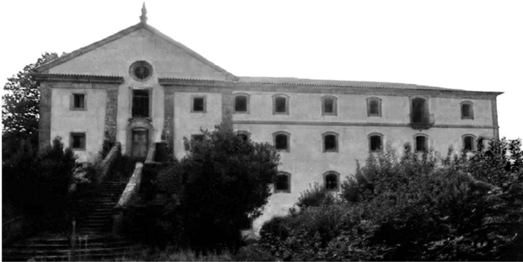
Vista da Fachada Principal Antes da Intervenção |13|
