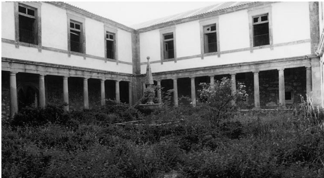
Vista do Claustro Antes da Intervenção |14|
