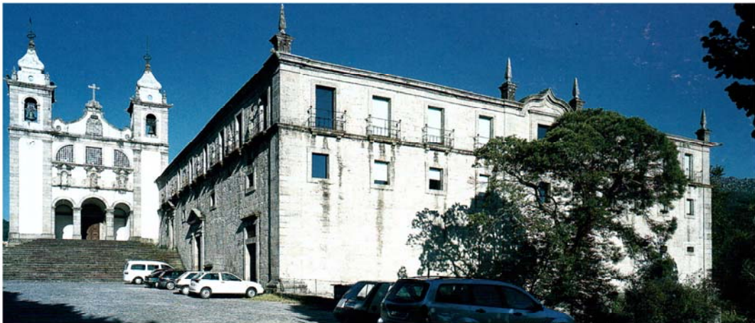
Vista Poente, Depois da Intervenção [51]
