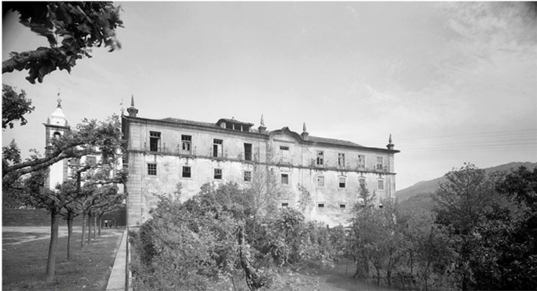
Fachada Poente Antes da Intervenção [42]
