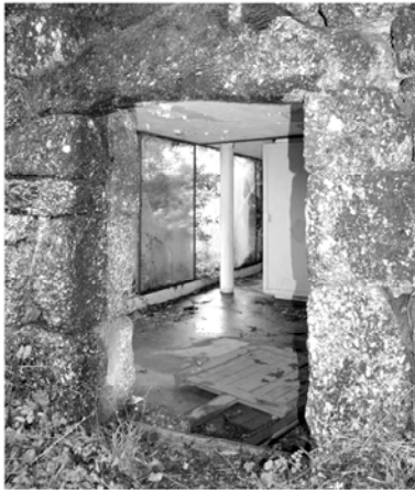
Vista do Interior [82]
