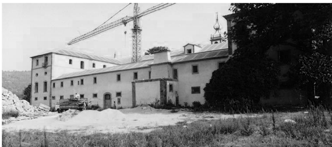
Vista da Fachada Sul Durante a Intervenção |15|
