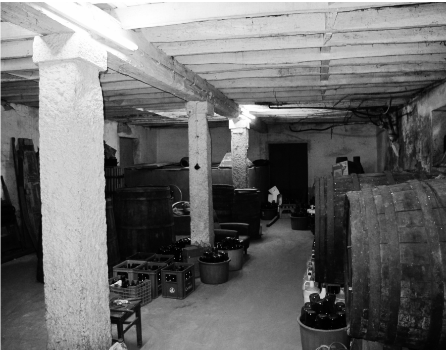
Fig. 36 Estrutura do piso superior.
