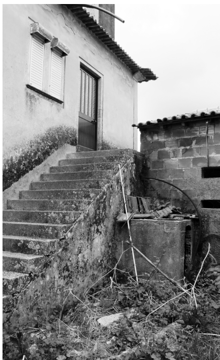
Fig. 11 Vista interior do anexo.
