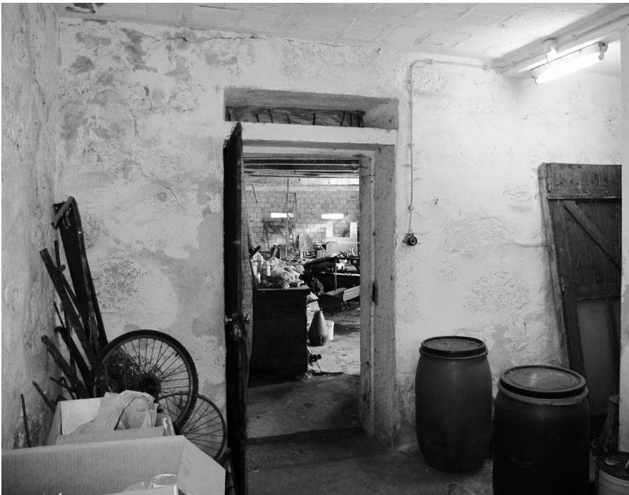
Fig. 27 Acesso ao anexo pela garagem Norte.
