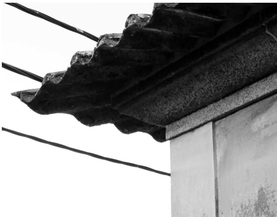
Fig. 39 Pormenor do beirado do telhado.
