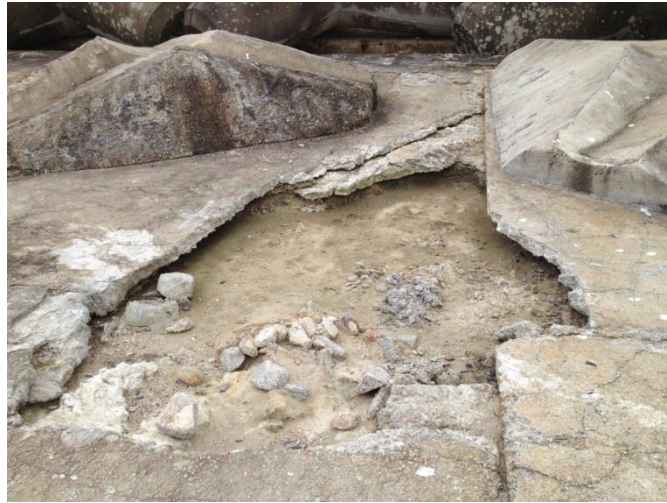
Figura 4-13 – Camas de cofragens e a envolvente (2015).
