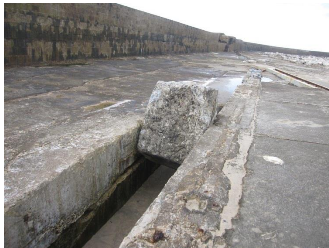
Figura 4-14 – Vala de escoamento (2015).
