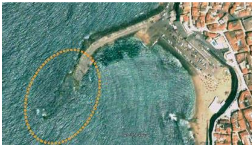
Figura 3-7 – Fotografia aérea do molhe da Ericeira. Zona a tracejado em ruínas (Costa et al. , 2011).
