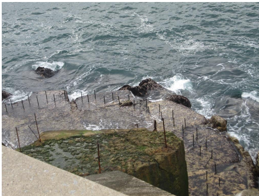
Figura J – Ferrolhos na extremidade da superestrutura (2015)
