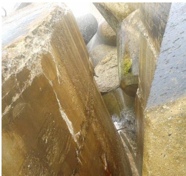
Figura G – Destacamento do patamar mais elevado relativamente às outras peças da cabeça do quebramar (APDL, 2013).
