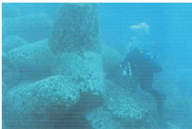
Figura 2-24 – Inspeção da parte imersa por um mergulhador (Sousa, 2011).
