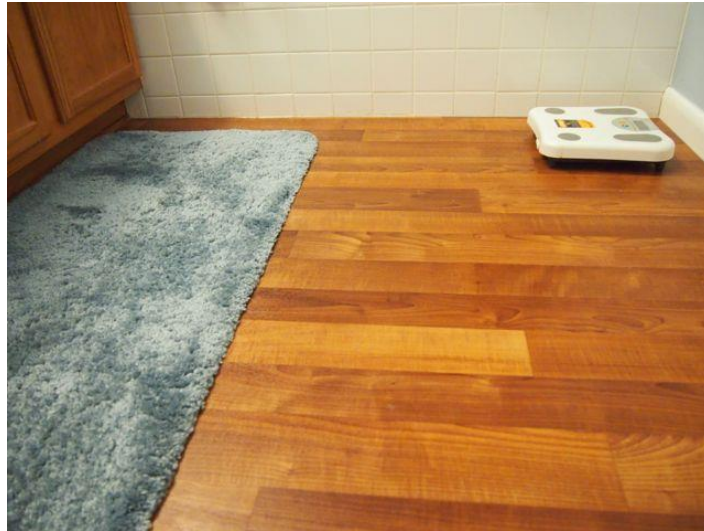
Figura 2.17 - Pavimento em linóleo [29].
