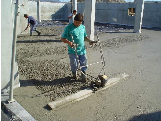
Fig. 4.3 - Espalhamento e nivelamento do betão (régua vibratória) [70].
