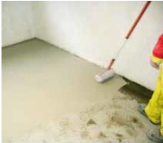
Fig. 5.7 - Exemplo de pavimento autonivelante de base cimentícia [19].
