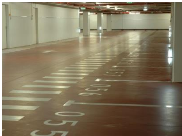
Fig. 5.4 - Exemplo de pavimento com aplicação de pintura simples epóxi [47].
