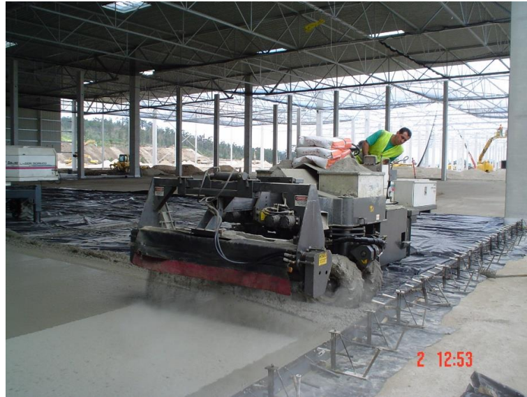
Fig. 4.6 – Aplicação de endurecedor de superfície (equipamento Topping Spreader ) [70].
