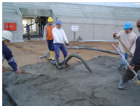
Fig. 4.2 – Aplicação do betão (bombagem) [70].
