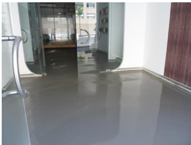
Fig. 4.12 – Camada de selagem em poliuretano [60].
