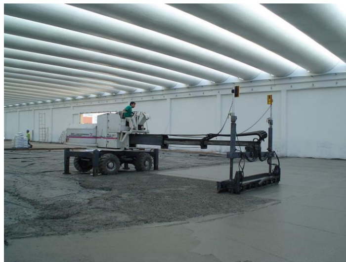
Fig. 4.4 – Espalhamento e nivelamento do betão (equipamento Laser Screed ) [70].
