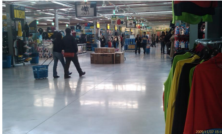
Fig. 5.2 – Exemplo de pavimento com aplicação de endurecedor de corindo.
