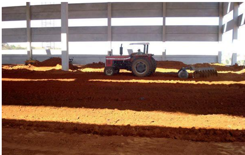
Fig. 2.2 – Preparação do subleito de fundação.
