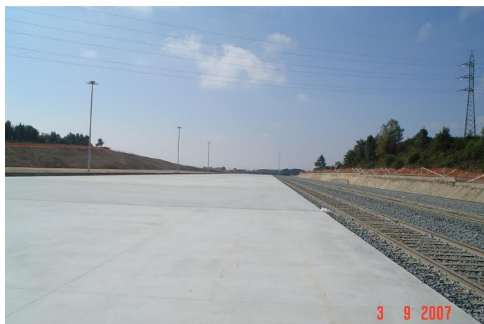
Fig. 5.1 – Exemplo de pavimento com aplicação de endurecedor de quartzo.
