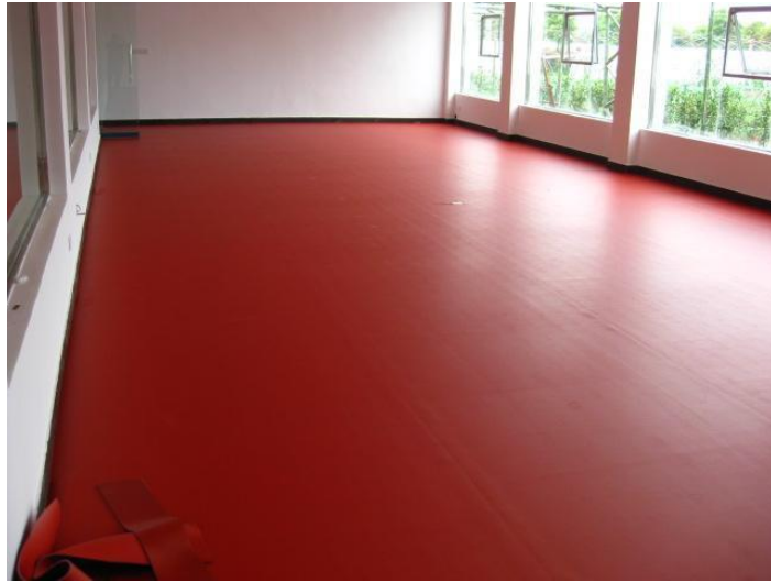
Figura 2.16 - Pavimento em PVC [30].
