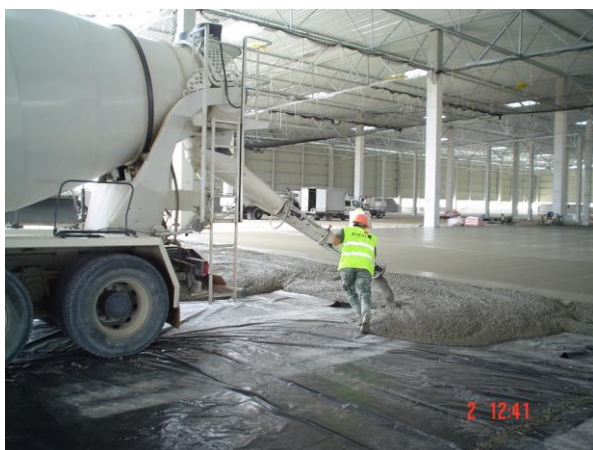
Fig. 4.1 – Aplicação do betão (descarga direta) [70].
