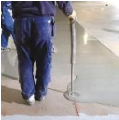
Fig. 4.10 – Aplicação da camada autonivelante de base cimentícia [61].
