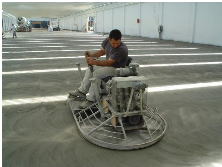
Fig. 4.7 – Atalochamento da superfície [70].
