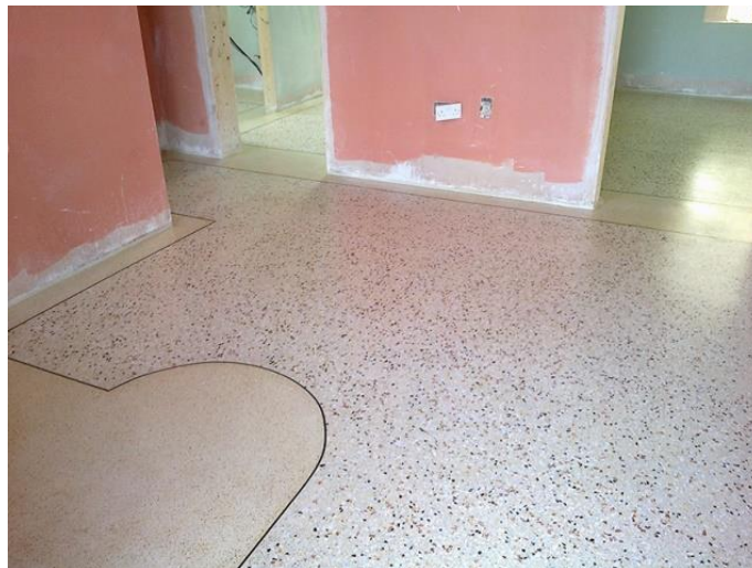
Figura 2.13 – Terrazzo aplicado in situ [26].
