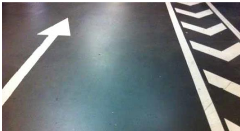
Figura 2.14 - Pavimento à base de resinas [3].
