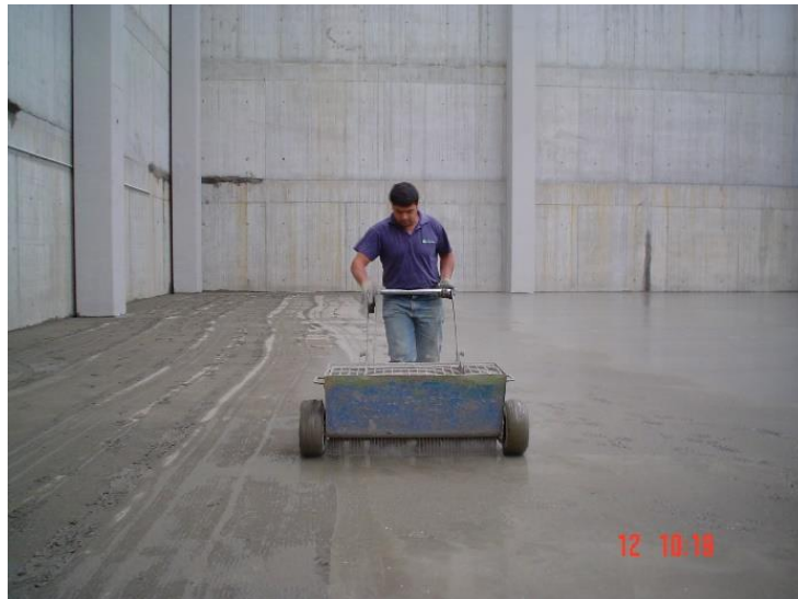
Fig. 4.5 – Aplicação de endurecedor de superfície [70].
