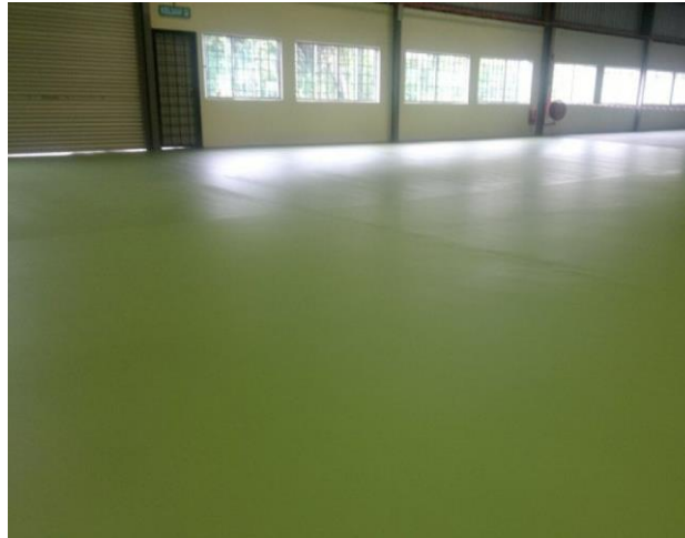
Fig. 5.5 - Exemplo de pavimento com aplicação de pintura simples epóxi [48].
