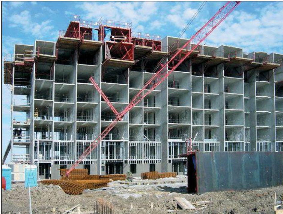
Fig.35 – Remoção de túnel de cofragem para habitação da Outinord
