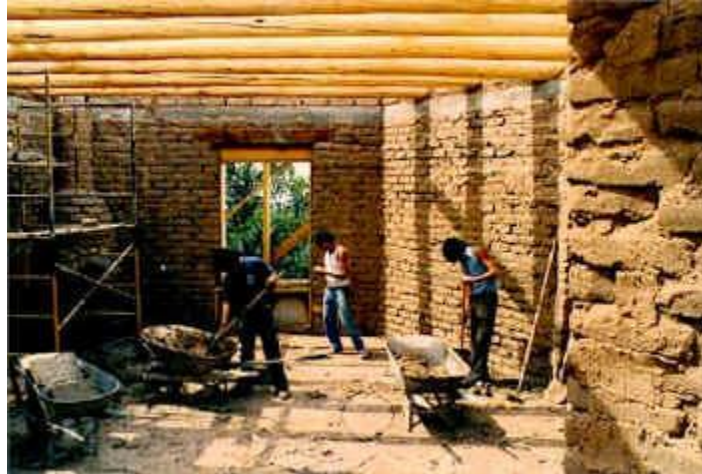
Fig.4 – Construção de habitação com recurso a adobe
