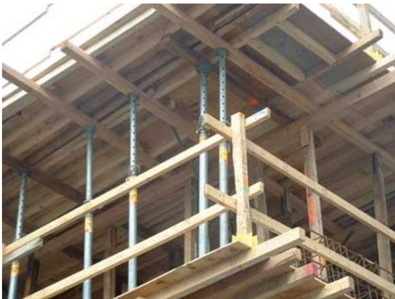
Fig.19 – Exemplo de cofragem tradicional
