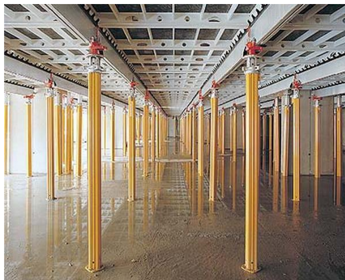
Fig.28 – Sistema em painéis para lajes
