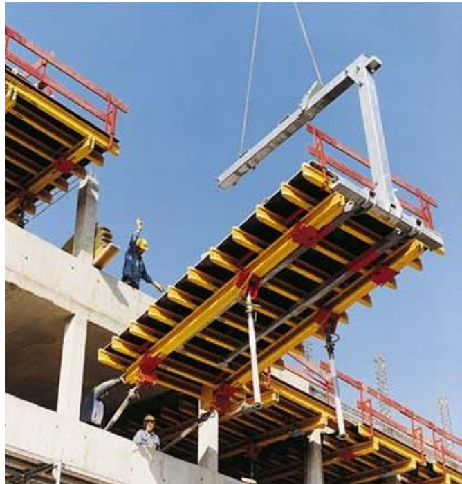
Fig.31 – Remoção de uma mesa de cofragem GT 24 da Peri através de grua
