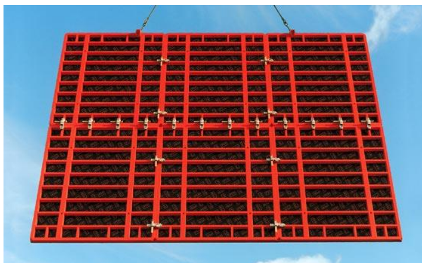
Fig.33 – Movimentação de paineis parede TRIO da Peri através de grua e recurso a correntes
