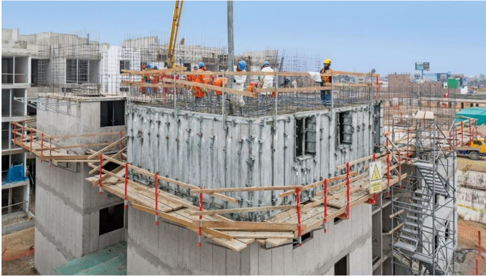
Fig.17 – Estrutura parede em betão armado cofrada por sistema UNO da Peri .
