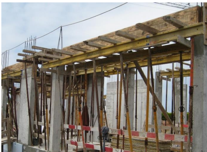
Fig.20 – Utilização de elementos semi-racionalizados (viga principal de cofragem)
