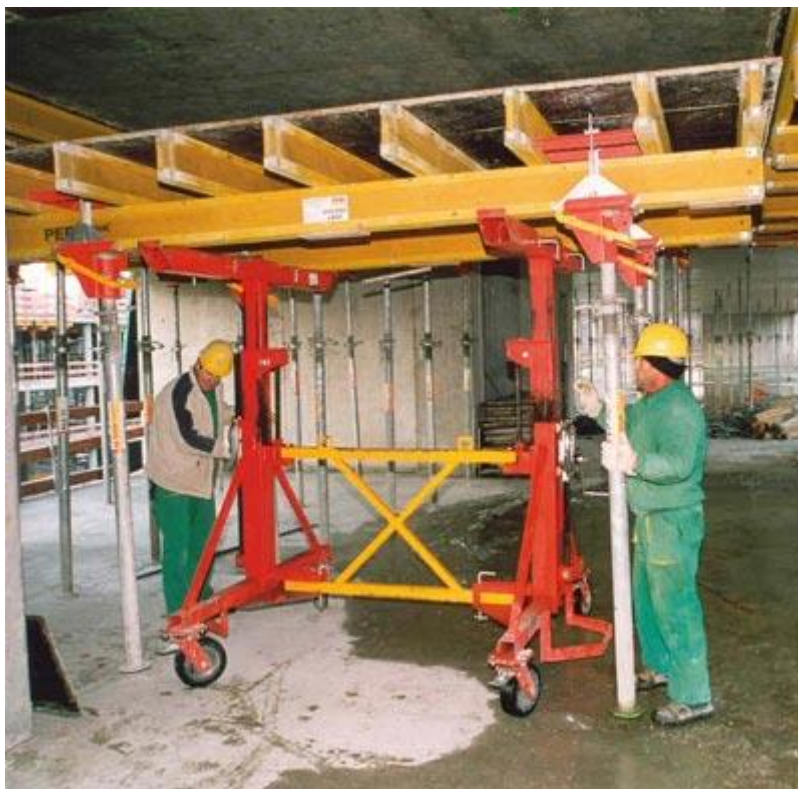
Fig.32 – Carro para translação de mesa de cofragem Peri
