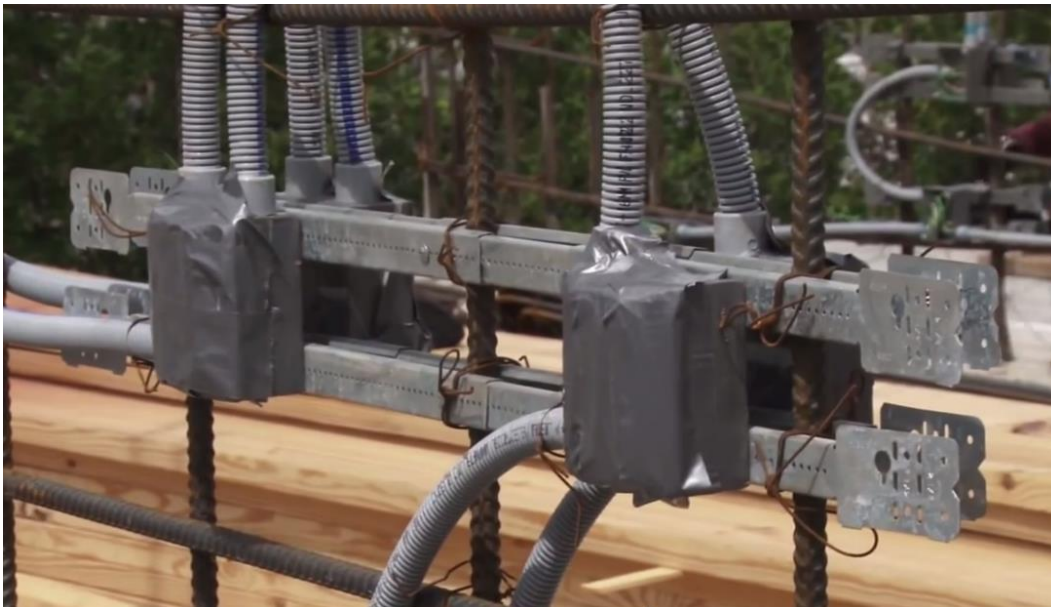
Fig.47 – Colocação das instalações elétricas amarradas às armaduras
