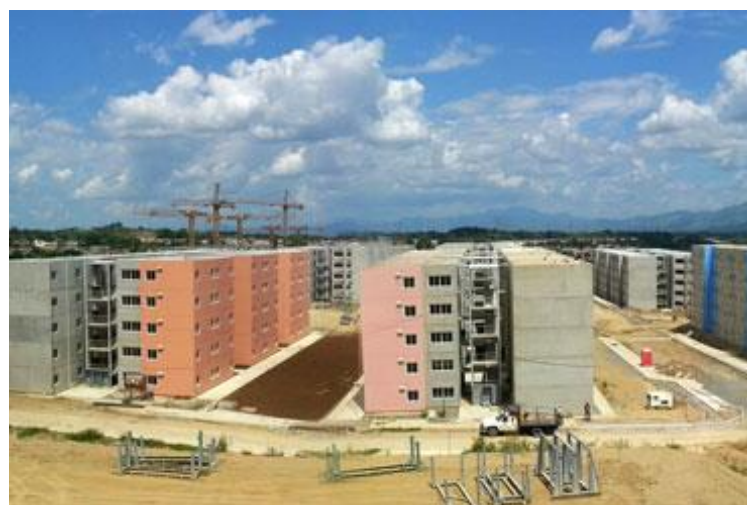
Fig.9 – Construção de baixo custo na Venezuela pelo Grupo Lena
