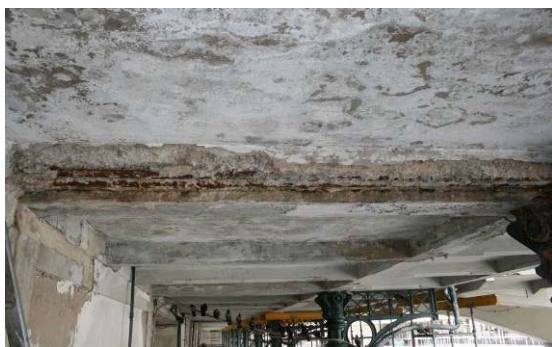
Figura 4.21 – Destacamento do betão de recobrimento e corrosão de elementos metálicos numa viga V1 da galeria.
