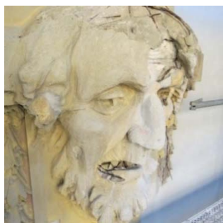
Figura 5.37 – Sondagem que mostra o empastelamento de argamassa sobre a testa.
