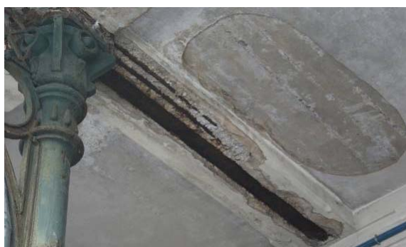
Figura 4.21 – Destacamento do betão de recobrimento e corrosão de elementos metálicos numa viga V1 da galeria.
