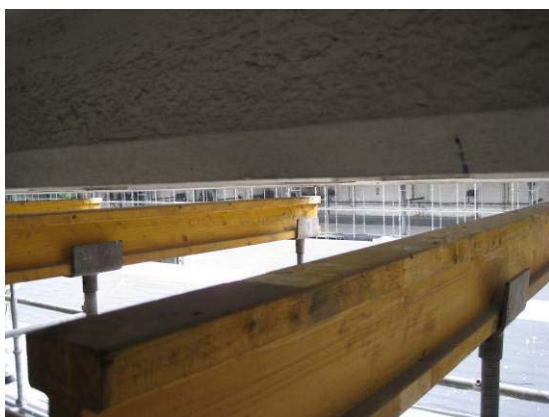
Figura 4.53 – Escoramento de espera.
