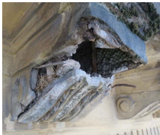
Figura 5.17 – Elemento decorativo 14 (mísulas fingidas com interior oco).
