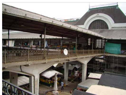
b) Passagem central ao nível da galeria.
