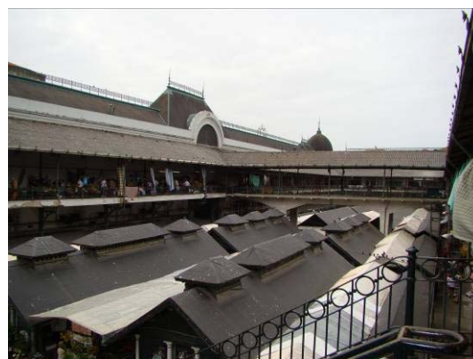
d) Galeria do piso 1.
