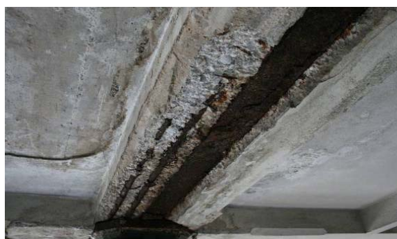
Figura 4.21 – Destacamento do betão de recobrimento e corrosão de elementos metálicos numa viga V1 da galeria.
