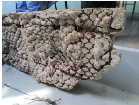
Figura 5.45 – Pormenor da “gaveta” de uma mísula e do arame esticador.
