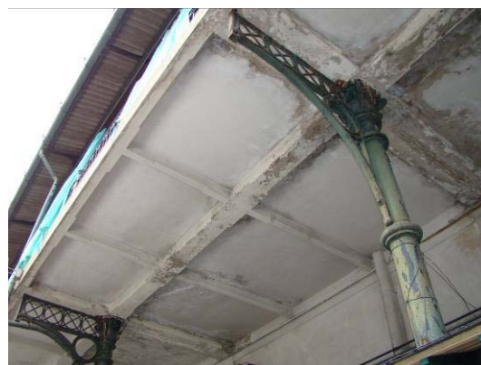
b) Vigas e laje da galeria interior do mercado.
