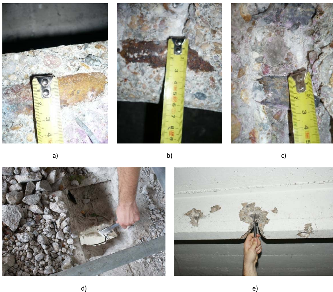
Figura 4.43 – Medição de armaduras após execução de sondagens.
