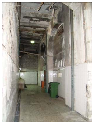
e) Zona do matadouro.
