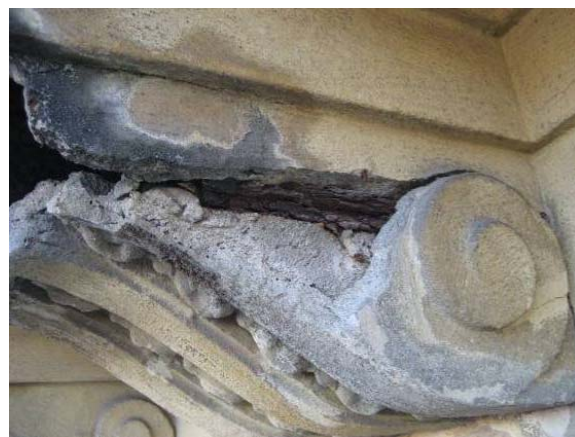
Figura 5.26 – Corrosão de armaduras e desprendimento da camada de recobrimento.
