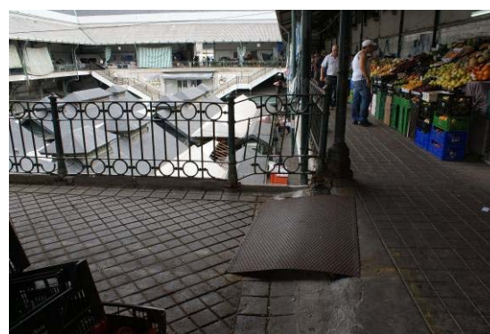
Figura 4.33 – Deslocamento relativo na ligação do passadiço central à galeria.
