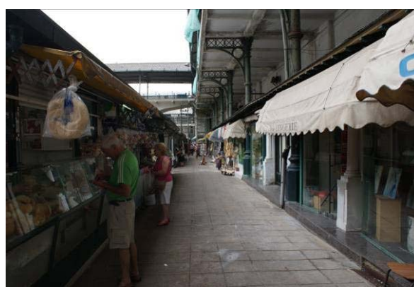
d) Vista inferior da galeria e rua lateral interior.
