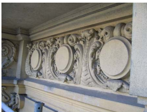
Figura 5.23 – Banda de elementos decorativos em zona menos exposta e com aparente bom estado de conservação.
