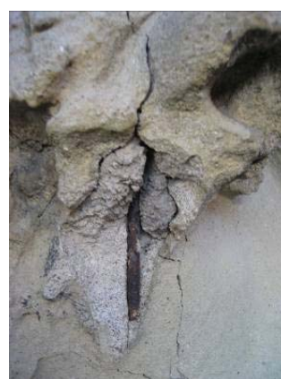
Figura 5.32 – Fissuração e destacamento de argamassas por corrosão de armaduras.
