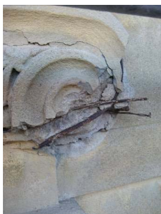
Figura 5.20 – Varões metálicos em elementos decorativos.
