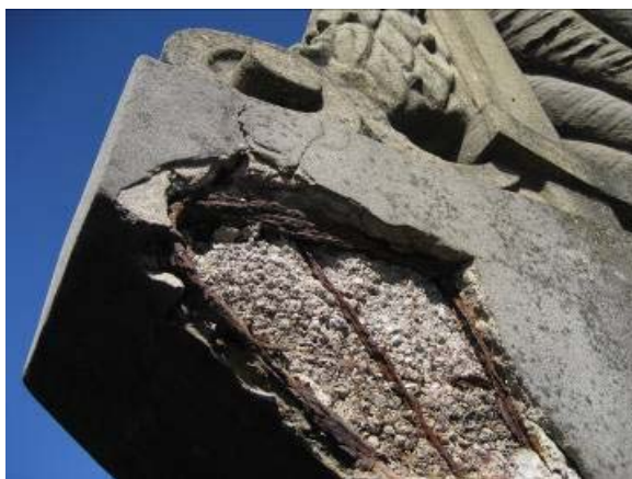
Figura 5.26 – Corrosão de armaduras e desprendimento da camada de recobrimento.
