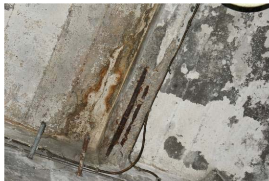
Figura 4.27 – Destacamento do betão de recobrimento e corrosão de armaduras numa viga da zona do antigo matadouro.
