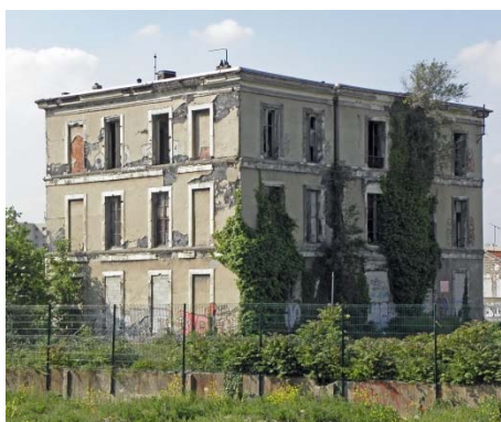
Figura 3.7 – Vista de 2010 da casa de betão reforçado com ferro construída por Francois Coignet, adaptado de (Wikipedia, 2015d).
