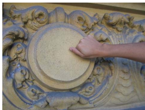
Figura 5.24 – Toque para primeira análise do estado das argamassas.
