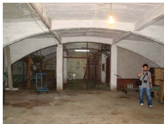
f) Criptopórticos em betão sob a Rua de Sá da Bandeira.
