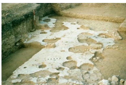
Figura 3.1 – Pavimento em betão datado de 7000 AC em Yiftah'el, sul da Galileia, adaptado de (Wikipedia, 2015a).
