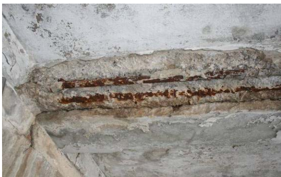
Figura 4.22 – Destacamento do betão de recobrimento e corrosão de armaduras em vigas.
