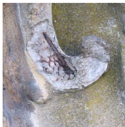
Figura 5.19 – Varão metálico e rede de galinheiro.
