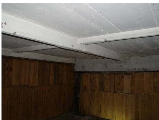
a) Vigas e laje no piso das lojas exteriores.
