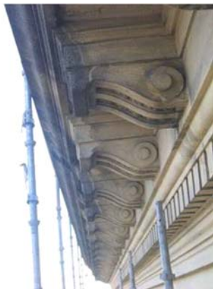
Figura 5.44 – Mísulas e cornija fingidas.
