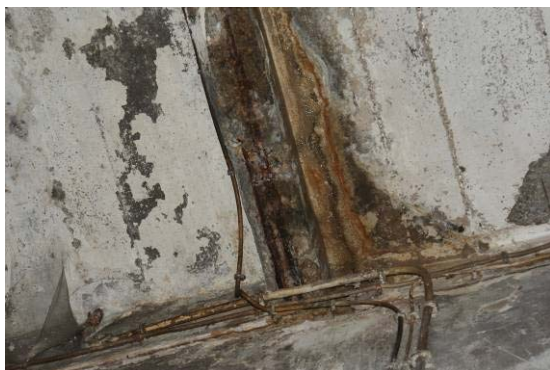
Figura 4.27 – Destacamento do betão de recobrimento e corrosão de armaduras numa viga da zona do antigo matadouro.
