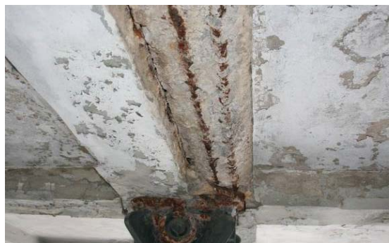
Figura 4.22 – Destacamento do betão de recobrimento e corrosão de armaduras em vigas.
