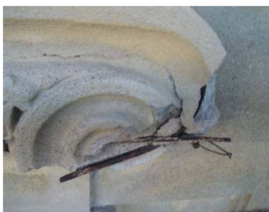
Figura 5.32 – Fissuração e destacamento de argamassas por corrosão de armaduras.
