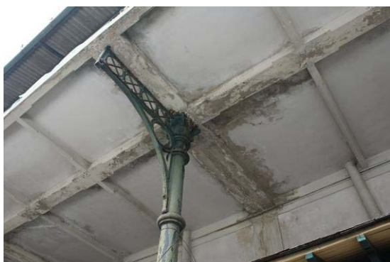
Figura 4.34 – Presença de humidade na parte inferior da galeria.
