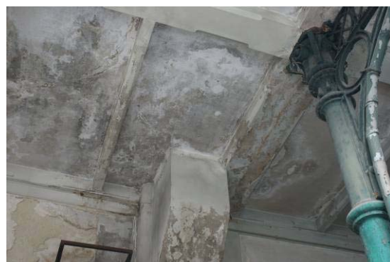
Figura 4.34 – Presença de humidade na parte inferior da galeria.
