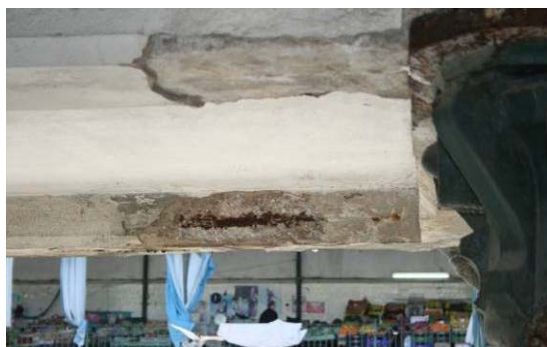
Figura 4.21 – Destacamento do betão de recobrimento e corrosão de elementos metálicos numa viga V1 da galeria.
