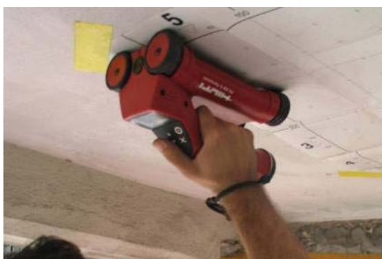
Figura 4.39 – Detecção de armaduras com o Ferroskan PS 200.
