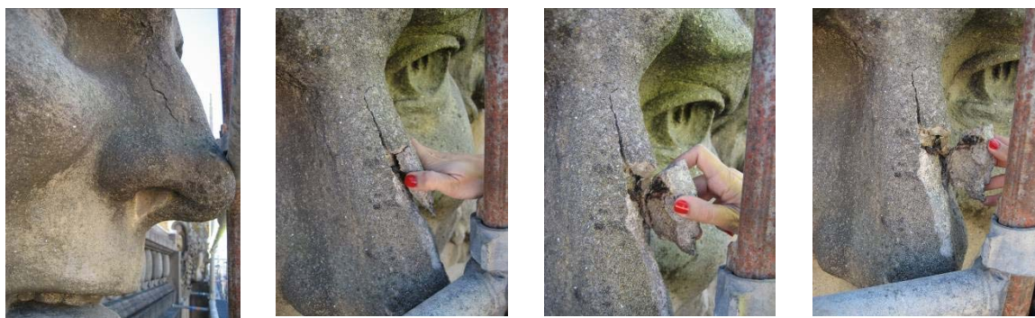
Figura 5.35 – Delaminação de argamassas por corrosão de armaduras.
