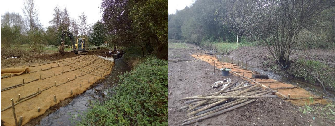
Figura 22. Manta de Fibra de Coco no Rio Uíma.
