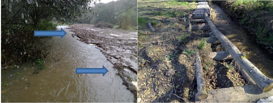
Figura 19 Muro Vivo submerso e erodido.
