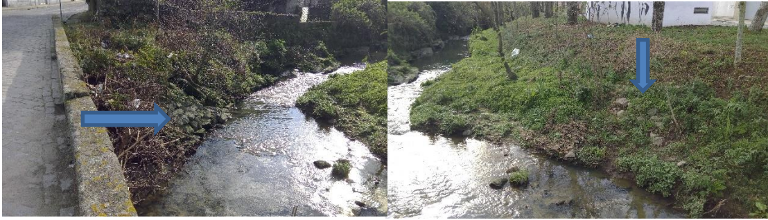
Figura 30- Enrocamento vivo.
