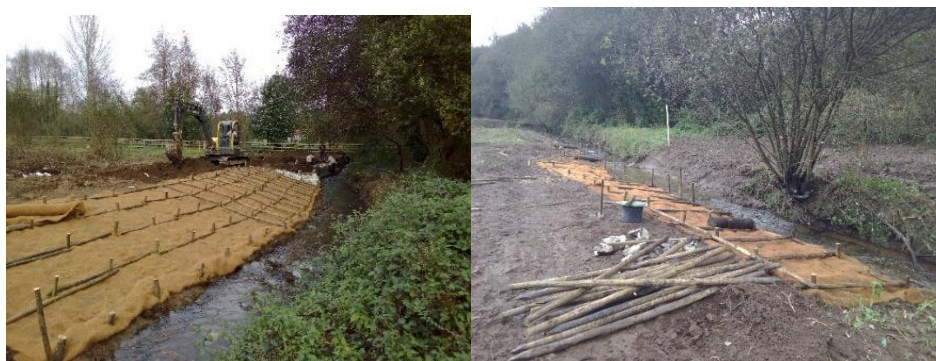
Figura 46. Manto de Fibra de Coco no Rio Uíma.
