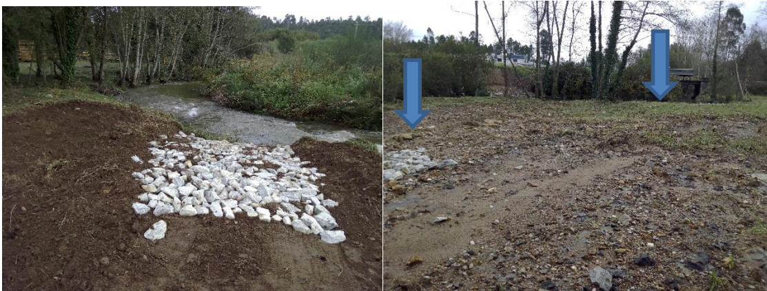
Figura 25. Enrocamento Rio Uíma.
