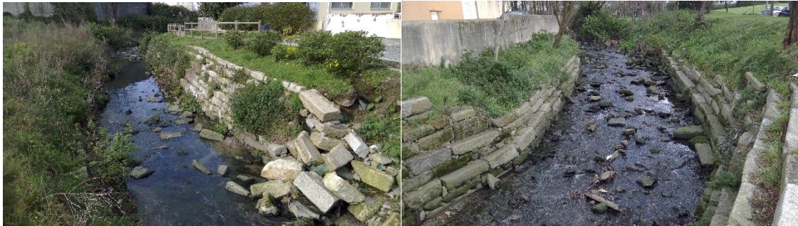
Figura 38 Enrocamento 3ª fase.
