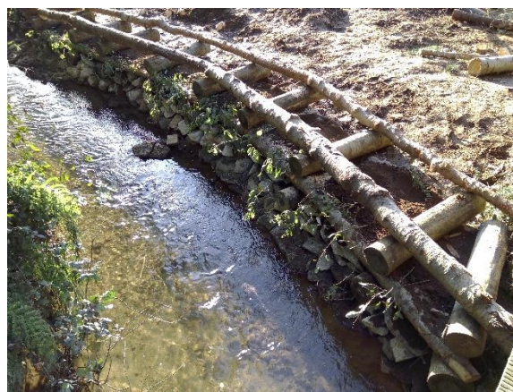
Figura 20. Muro Vivo em construção no Rio Uíma.
