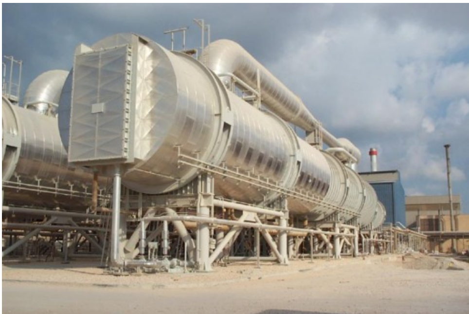
Figura 3.1: Central de dessalinização usando a tecnologia de compressão térmica de vapor em Tobruk na Líbia de produção diária de 40\,000\text{ m}^3 diários [20].
