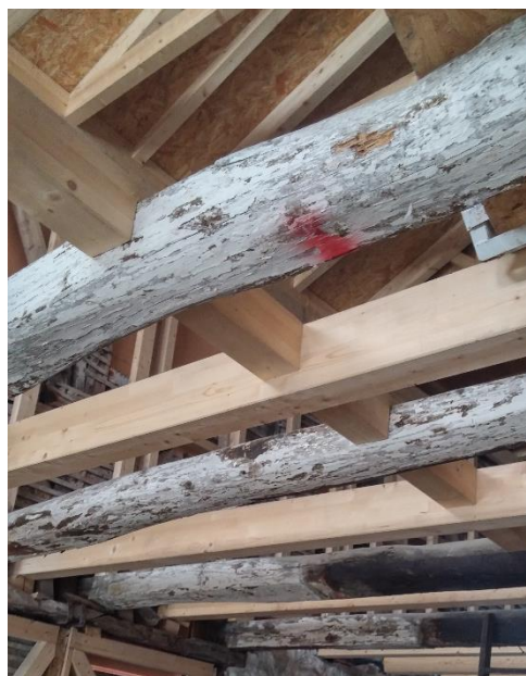
Figura 2.9 – Vigas de um edifício na Rua dos Caldeireiros, Porto
