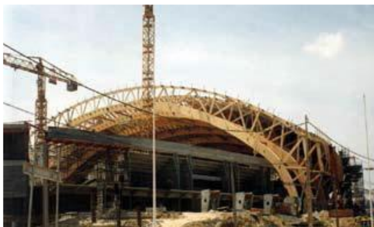
Figura 2.3 – Cobertura em madeira lamelada-colada do Pavilhão Atlântico, Lisboa [7]
