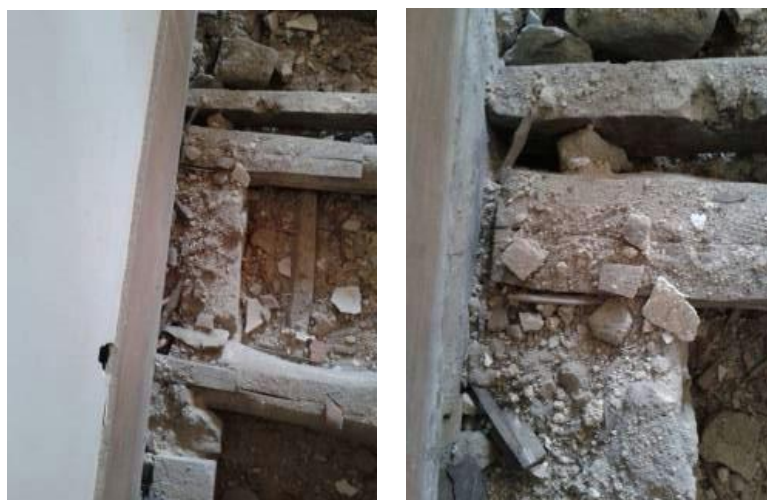
Figura 3.9 – Fotografias do pormenor dos apoios das vigas na parede exterior
