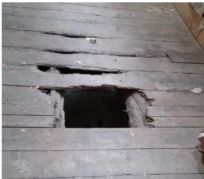
Figura 2.13 – Soalho de um pavimento na Rua Alexandre Braga, Porto
