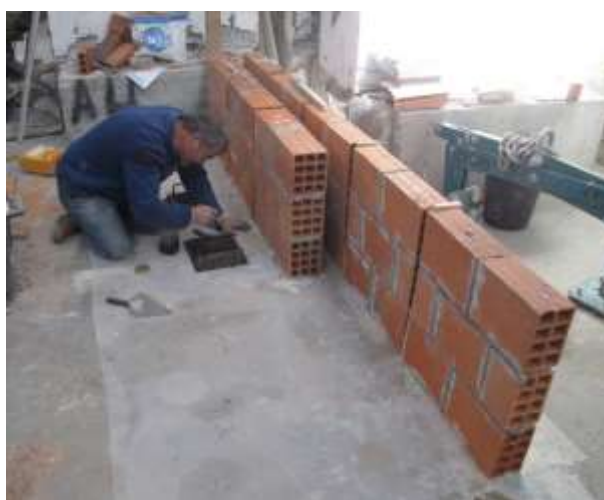
Figura 4.4 – Construção dos provetes tipo murete de alvenaria.
