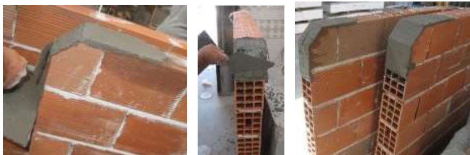
Figura 4.15 – Enchimento dos tijolos de extremidade com argamassa.
