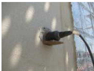
Figura 5.15 – Ligação entre os acelerómetros e a parede.
