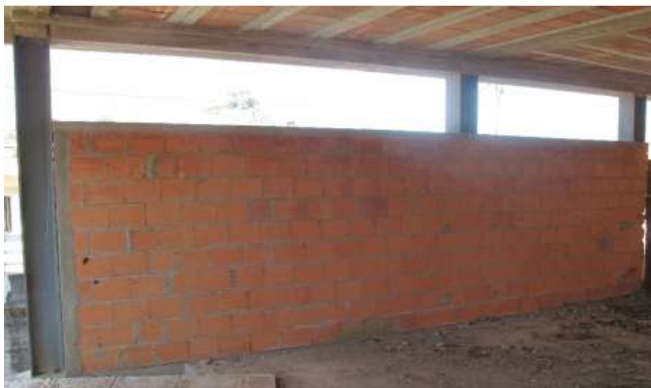
Figura 5.5 – Envoltório interior da parede onde foi realizado o teste dinâmico.
