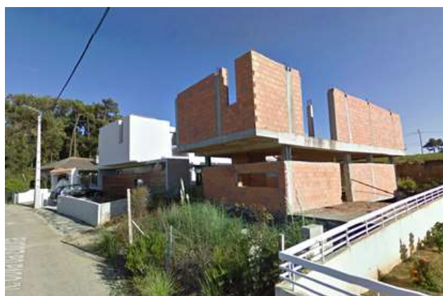
Figura 5.2 – Edifício ainda em fase de construção no qual foi realizado o ensaio.
