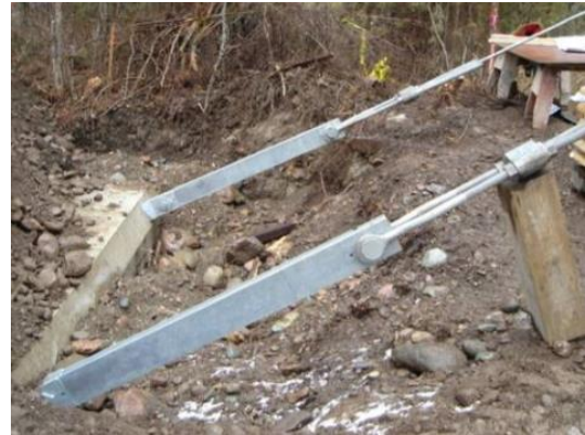
Figura 2.13 - Bloco de ancoragem nos encontros da ponte após ligação dos cabos superiores (Miller, 2010).
