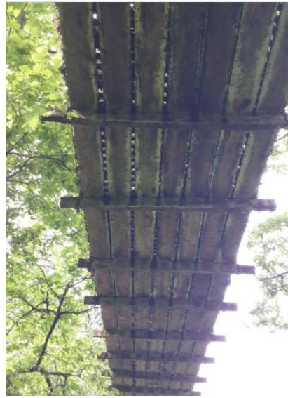
Figura 2.5 - Parte inferior do tabuleiro.
