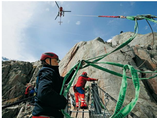
Figura 2.21 - Lançamento dos cabos realizado pelo helicóptero, extraído de http://www.detail-online.com .
