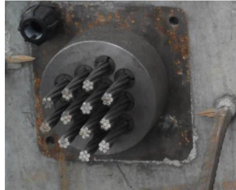
Figura 2.23 – Utilização dos cabos seven-wire strand em sistemas de pré-esforço.
