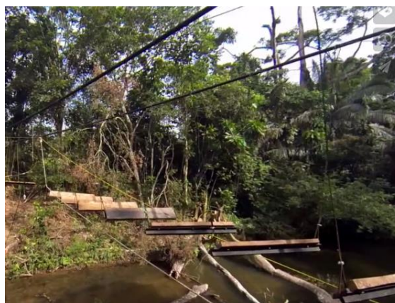
Figura 2.14 - Cabos principais fixos, com pendurais e travessas, extraído de https://vimeo.com/106953939 .
