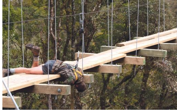
Figura 2.16 – Colocação do pavimento sobre travessas, extraído de http://architectureau.com .
