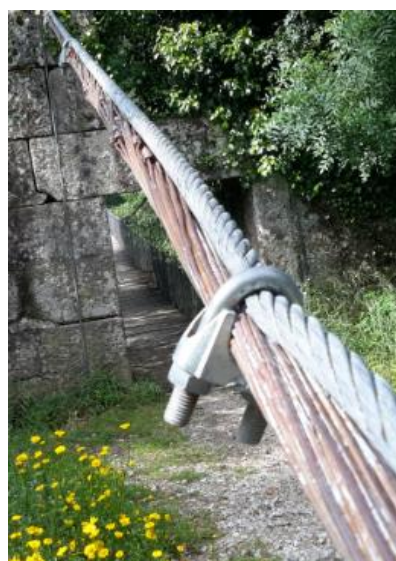
Figura 2.3 - Pormenor dos cabos principais da ponte.
