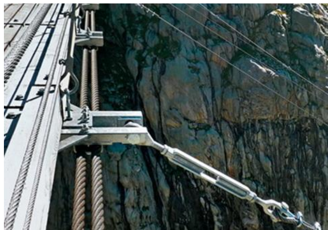
Figura 2.40 - Pormenor da ligação espia/ponte através de um Esticador Olhal/Manilha , extraído de http://www.detail-online.com .
