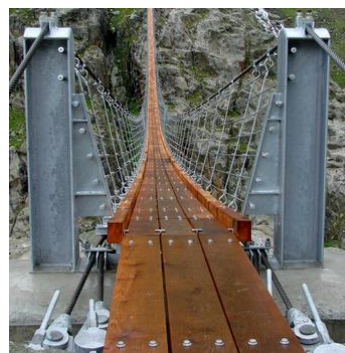
Figura 2.10 - Pormenor dos encontros da ponte, extraído de http://www.tripomatic.com .
