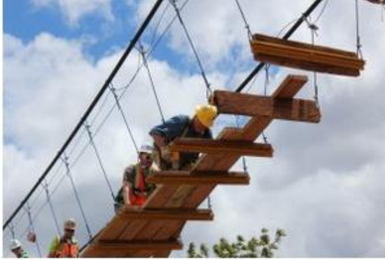
Figura 2.15 – Colocação do pavimento sobre travessas, extraído de http://www.canadianconsultingengineer.com .
