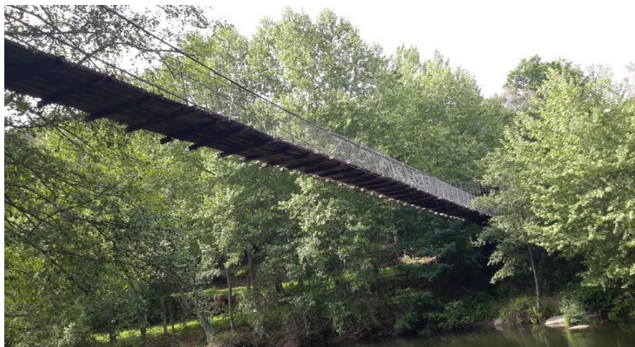
Figura 2.1 – Vista geral da Ponte de Santo Aleixo e Além-Tâmega.
