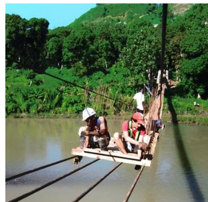
Figura 2.20 – Colocação das travessas e respetivo pavimento (The Bridge Builder, 2014).
