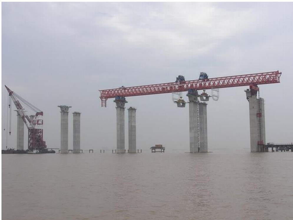
Figura 2.6 – Construção com aduelas pré-fabricadas tramo-a-tramo [13]
