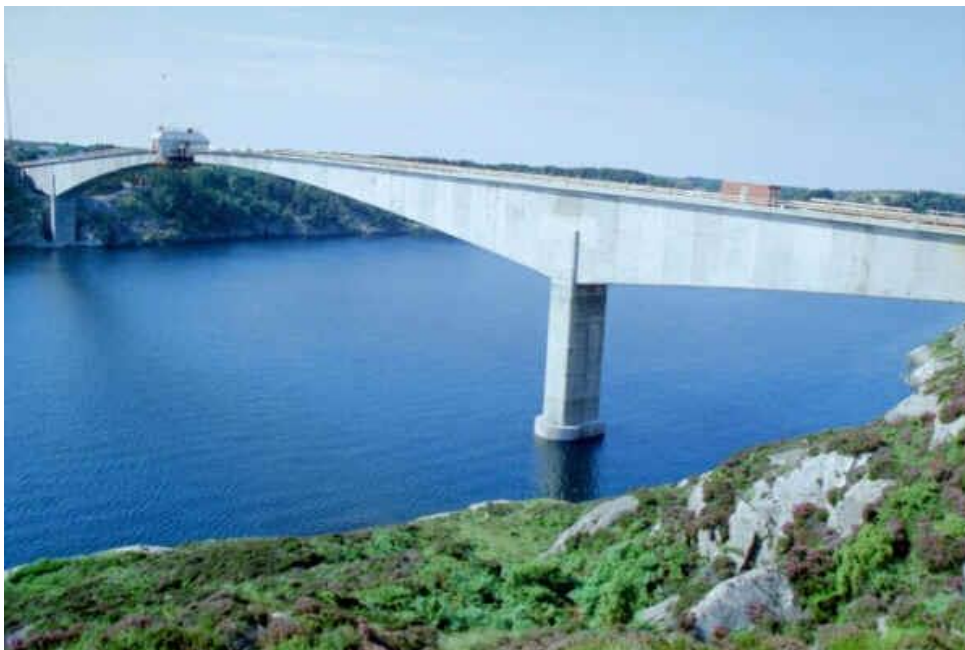
Figura 2.9 – Maior vão do mundo construído por avanços sucessivos, Stolma Bridge [18]
