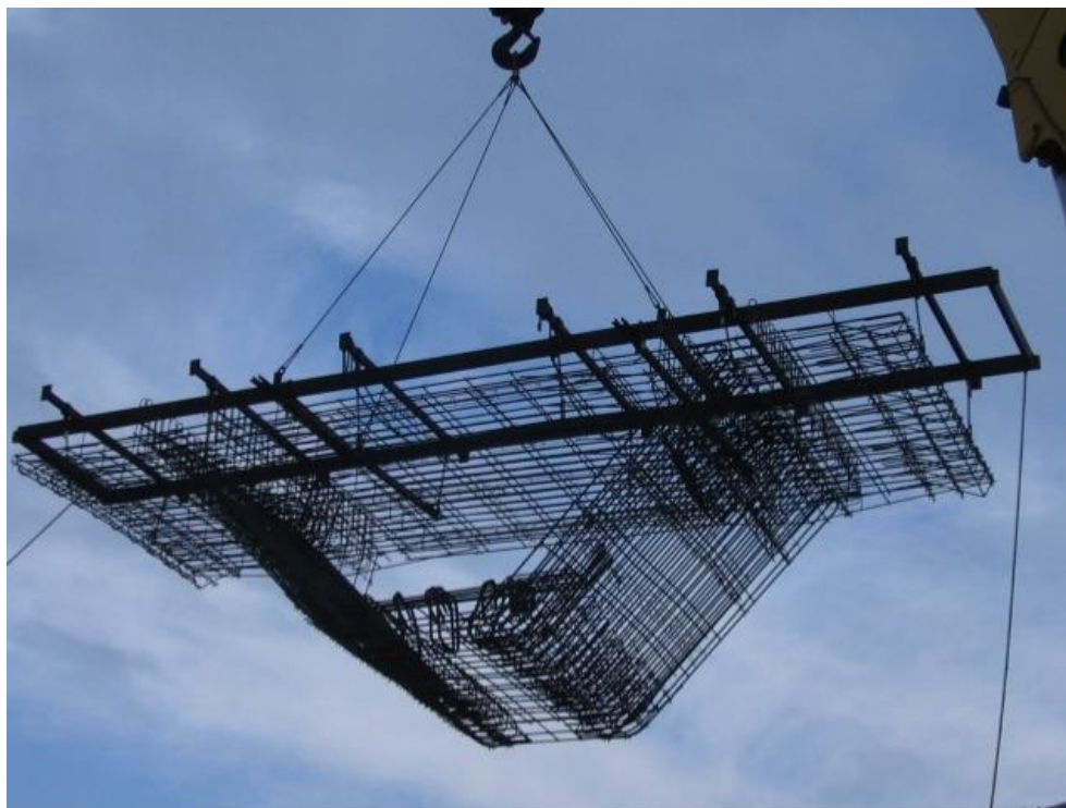
Figura 2.8 – Segmento vazio de armadura utilizado na construção de aduelas pré-fabricadas [17]
