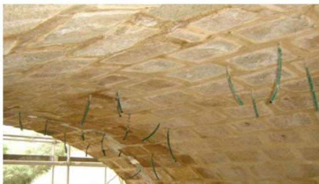
Fig. 82 – Injecção de calda no intradorso do arco, Ponte de Segura [9]
