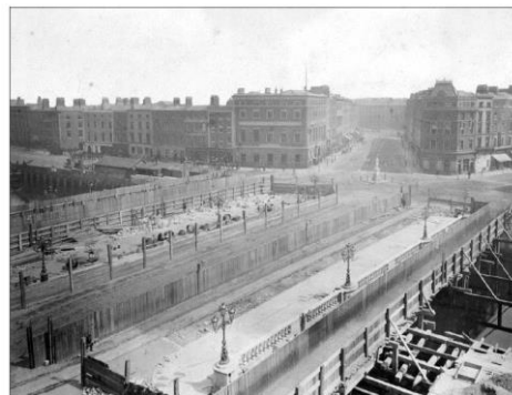
Fig. 99 – Ponte O'Connell durante as obras em 1879 [38]
