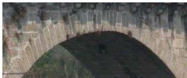
Fig. 28 – Pormenor das aduelas na Ponte da Barca [9]
