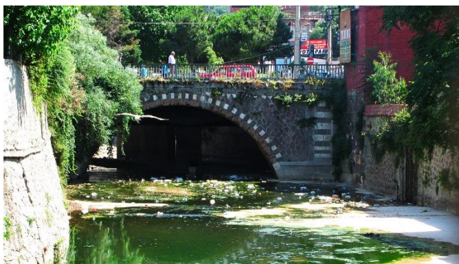
Fig. 18 – Ponte de Caravana, Turquia
