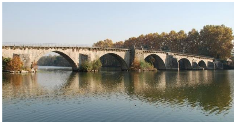
Fig. 30 – Ponte do Prado [29]
