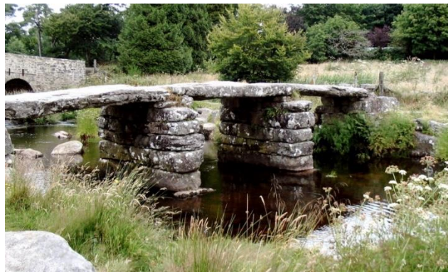
Fig. 15 – Exemplo de uma Clapper Bridge, a Postbridge em Inglaterra [18]
