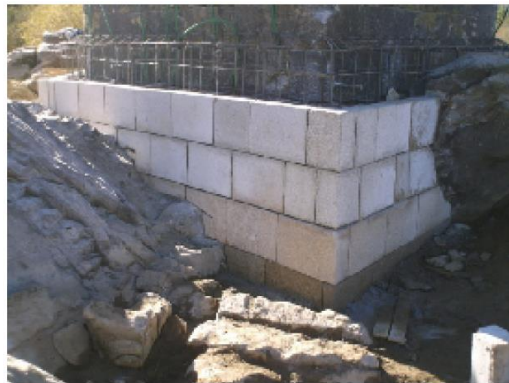
Fig. 84 – Encamisamento geral com blocos de granito, Ponte do Sabor [4]
