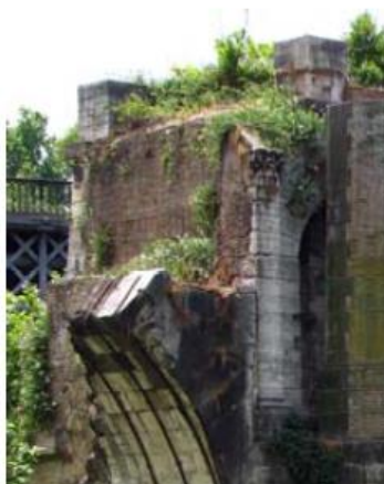
Fig. 6 – Pormenor do material de enchimento da Ponte Aemilius [9]
