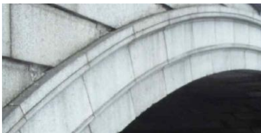
Fig. 101 – Detalhe do anel do arco [40]
