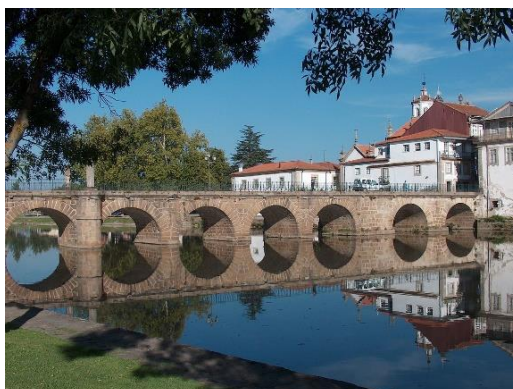
Fig. 21 – Ponte de Trajano [24]
