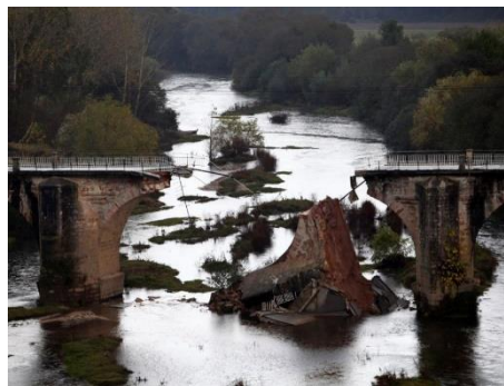
Fig. 68 – Ruína do arco, Ponte Velha do Vouga [v]
