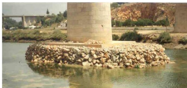
Fig. 76 – Enrocamento na base do pilar [17]
