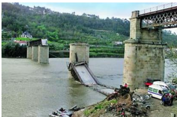
Fig. 74 – Ruína da ponte causada pela cheia e erosão, Ponte Hintze Ribeiro [36]
