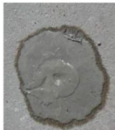
Fig. 81 – Fecho dos furos de injeção [9]
