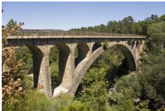
Fig. 8 – Arcos secundários na Ponte de Drizes [12]
