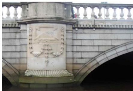
Fig. 110 – Pormenor muro de tímpano [40]
