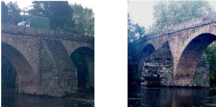
Fig. 11 – Pormenores do quebrante e do talhante, respetivamente, da Ponte da Lagoncinha [9]
