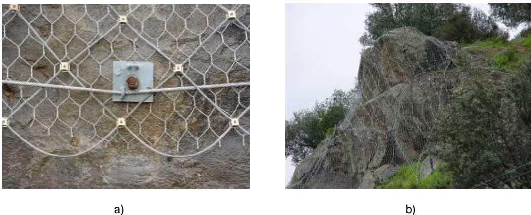
Fig 3.13 –a) Detalhe das redes em cabos e b) enquadramento paisagístico (GEG, 2015)
