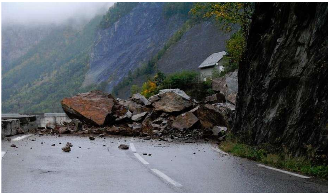
Fig 3.9 – Queda de blocos leva a encerramento de estrada em França (2alpesnet.com, 2015)
