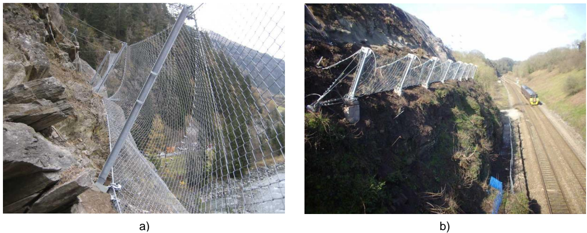
Fig 3.20 – Barreira dinâmica: enquadramento paisagístico: a) (agg-net.com, 2009) e b) (maccaferribalkans.com, 2015)
