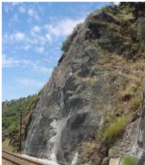
Fig 3.15 – Linha da Beira Baixa – Redes pregadas (GEG, 2015)
