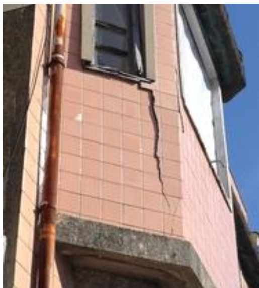
Figura 3.15 – Fendilhação com direção definida
