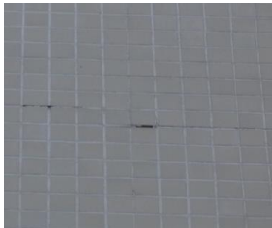
Figura 3.13 – Alteração da cor/enodoamento da junta Figura 3.14 – Desprendimento do produto de junta
