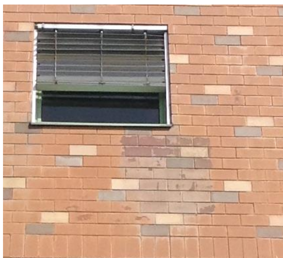
Figura 3.9 – Alteração da cor e brilho
