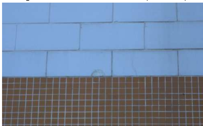
Figura 6 – Lascagem dos bordos (Edifício 7)
