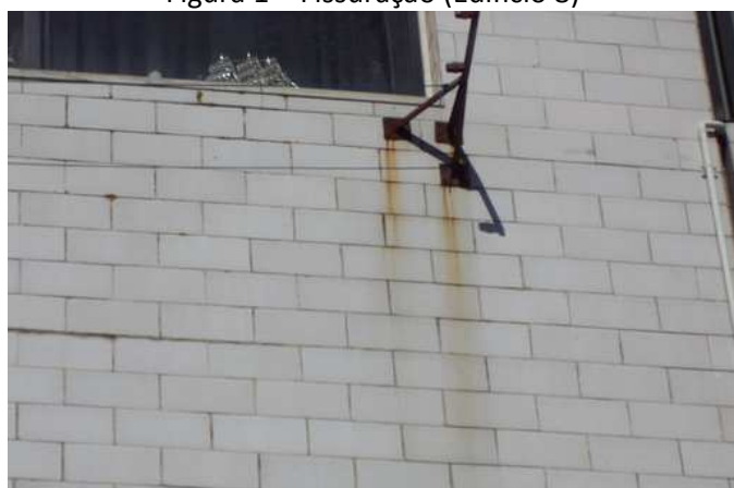
Figura 3 – Enodoamento (Edifício 6)
