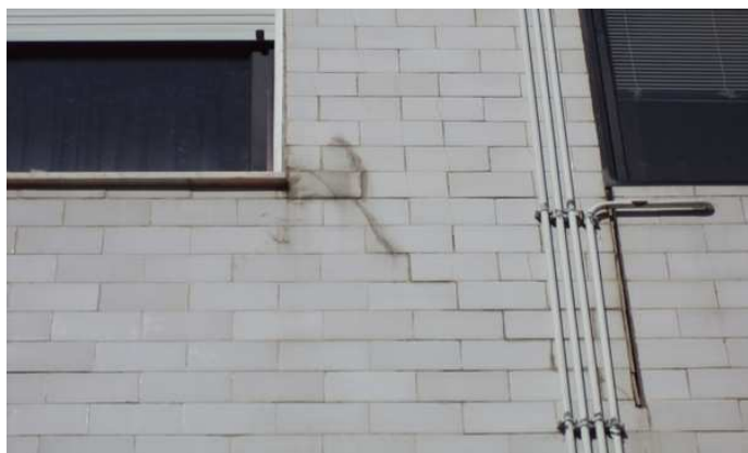
Figura 1 – Fissuração (Edifício 8)
