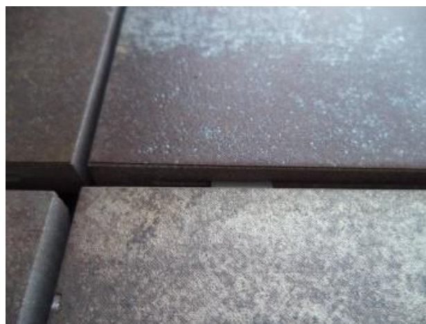
Figura 3.4 – Solução de fixação mecânica oculta
