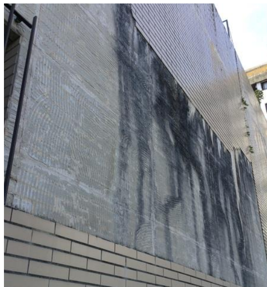
Figura 3.18 – Descolamento generalizado
