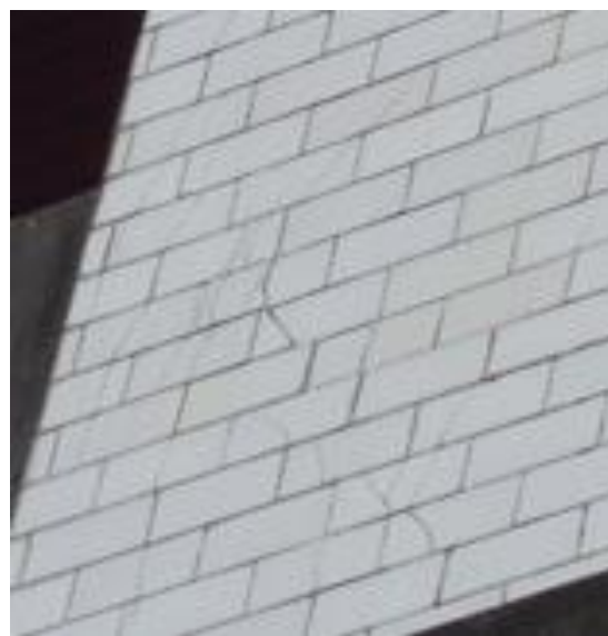
Figura 3.16 – Fendilhação sem direção preponderante
