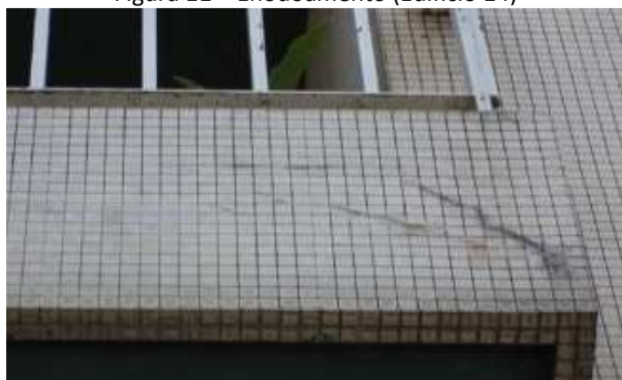
Figura 13 – Eflorescência (Edifício 20)
