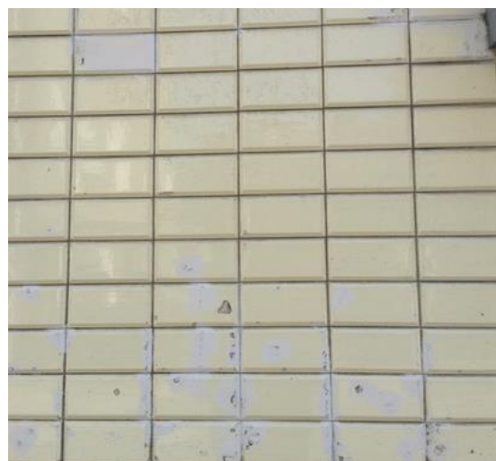
Figura 3.10 – Riscagem e desgaste
