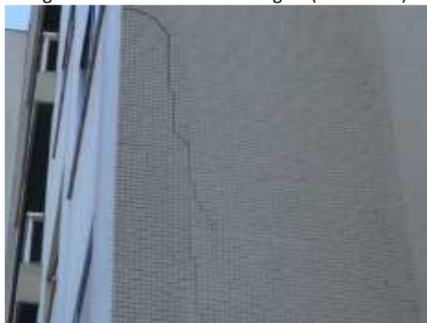
Figura 12 – Fendilhação (Edifício 19)
