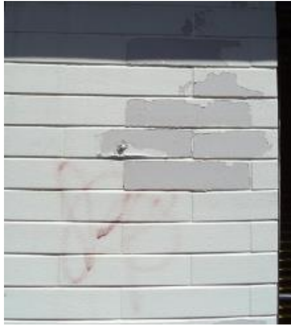
Figura 4.17 – Pormenor da fachada lateral (Edifício 5)
