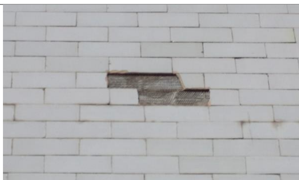
Figura 4.42 – Descolamento (Edifício 8)
