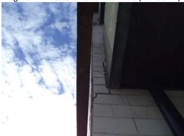
Figura 16 – Fissuração (Edifício 1)
