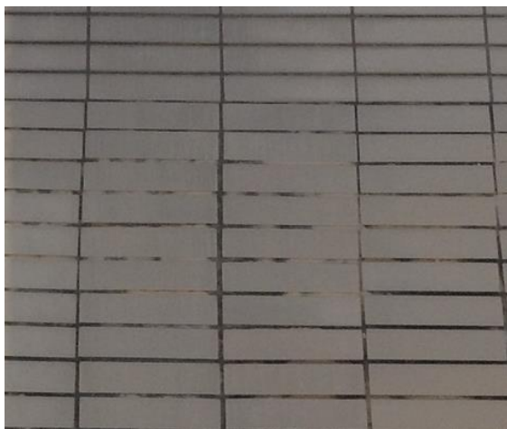
Figura 3.13 – Alteração da cor/enodoamento da junta Figura 3.14 – Desprendimento do produto de junta
