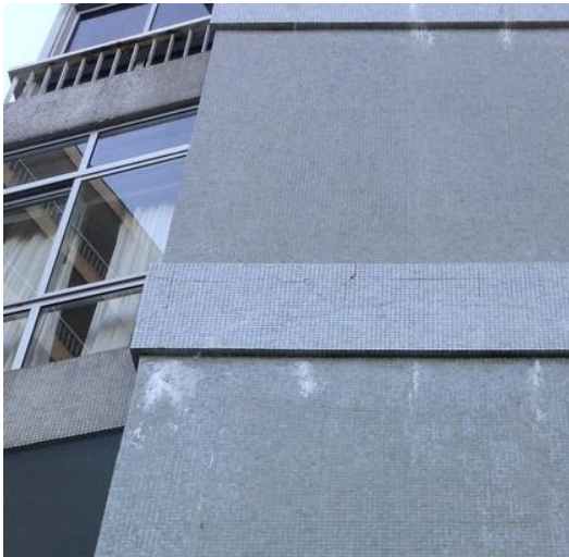
Figura 3.5 - Efflorescências
