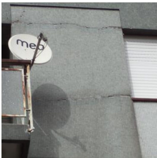
Figura 5.8 – Fissuração (Edifício 13)
