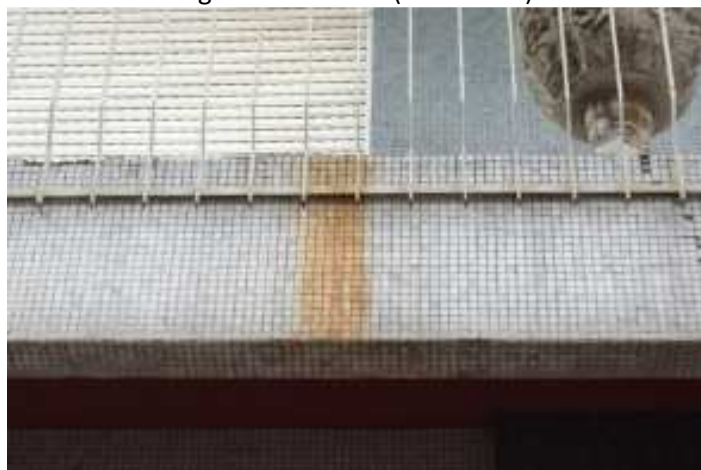
Figura 11 – Enodoamento (Edifício 14)
