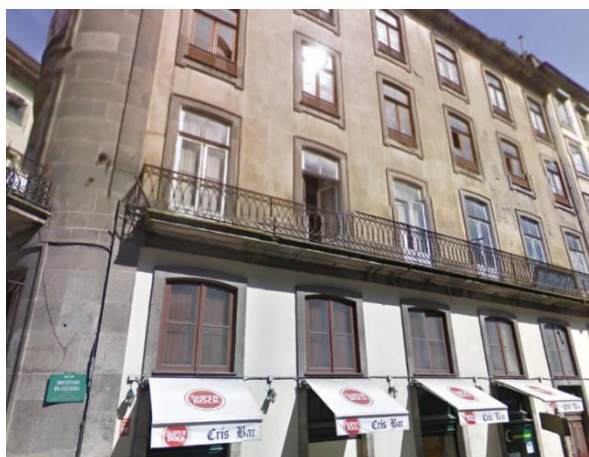
Figura 5.7 – Edifício Rua Mouzinho da Silveira
