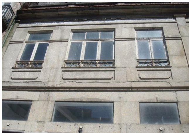
Figura 5.23 – Edifício Rua Mouzinho da Silveira 2
