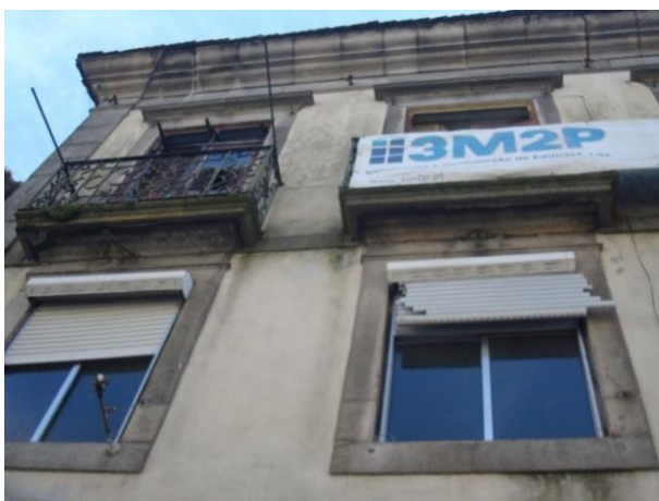
Figura 5.2 – Edifício Rua das Taipas
