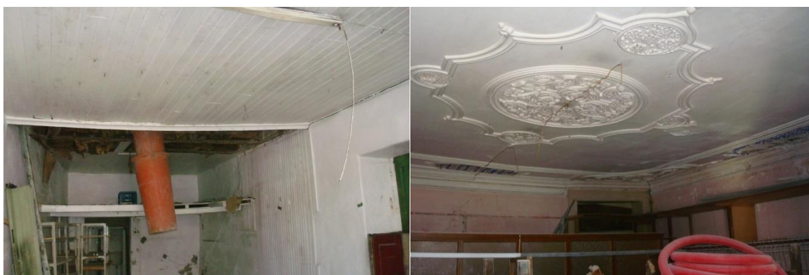
Figura 4.14 – Teto em tabuado de madeira (esquerda) e teto em estuque (direita)
