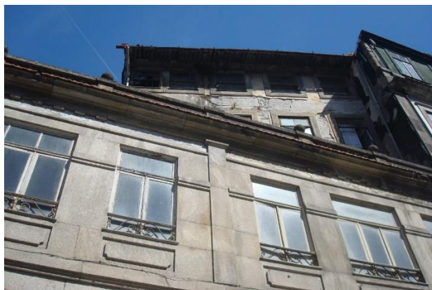
Figura 4.4 – Parede de fachada em alvenaria de pedra
