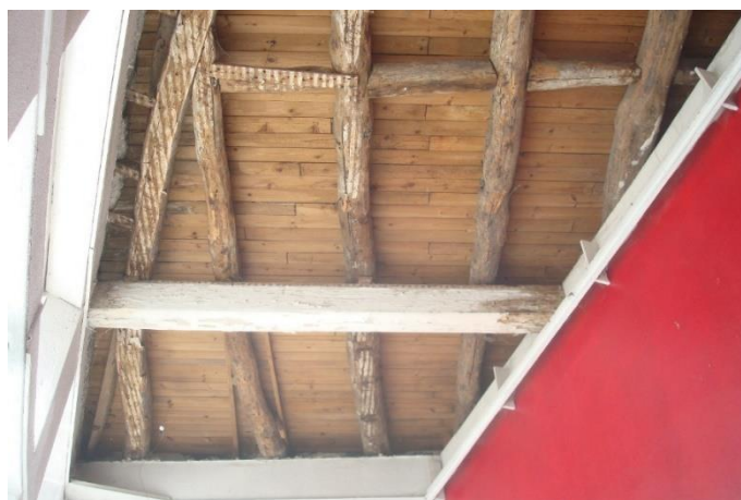
Figura 4.13 – Estrutura do pavimento com soalho visível
