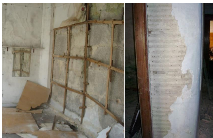
Figura 4.5 – Parede de meação em alvenaria de pedra (esquerda) e parede de tabique (direita)
