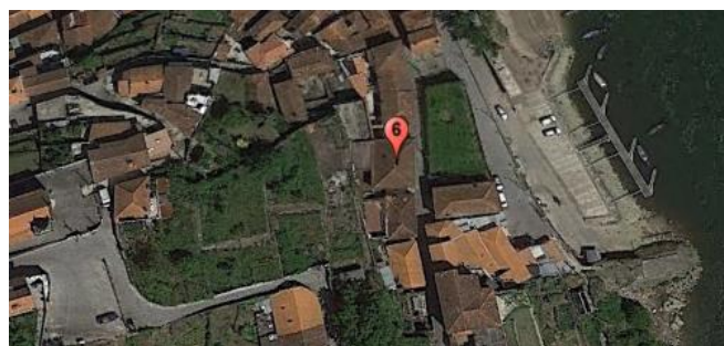
Localização do edifício
