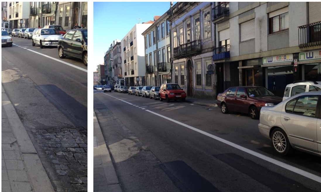
Figura 37 - Pormenor do pavimento na Rua Dom João IV
