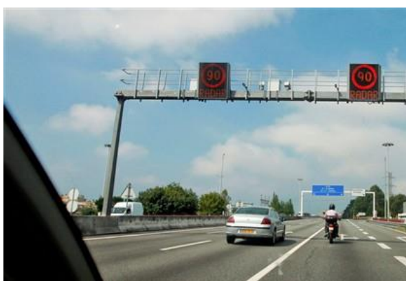
Figura 67 - Sistema controlo de velocidade sugerido
