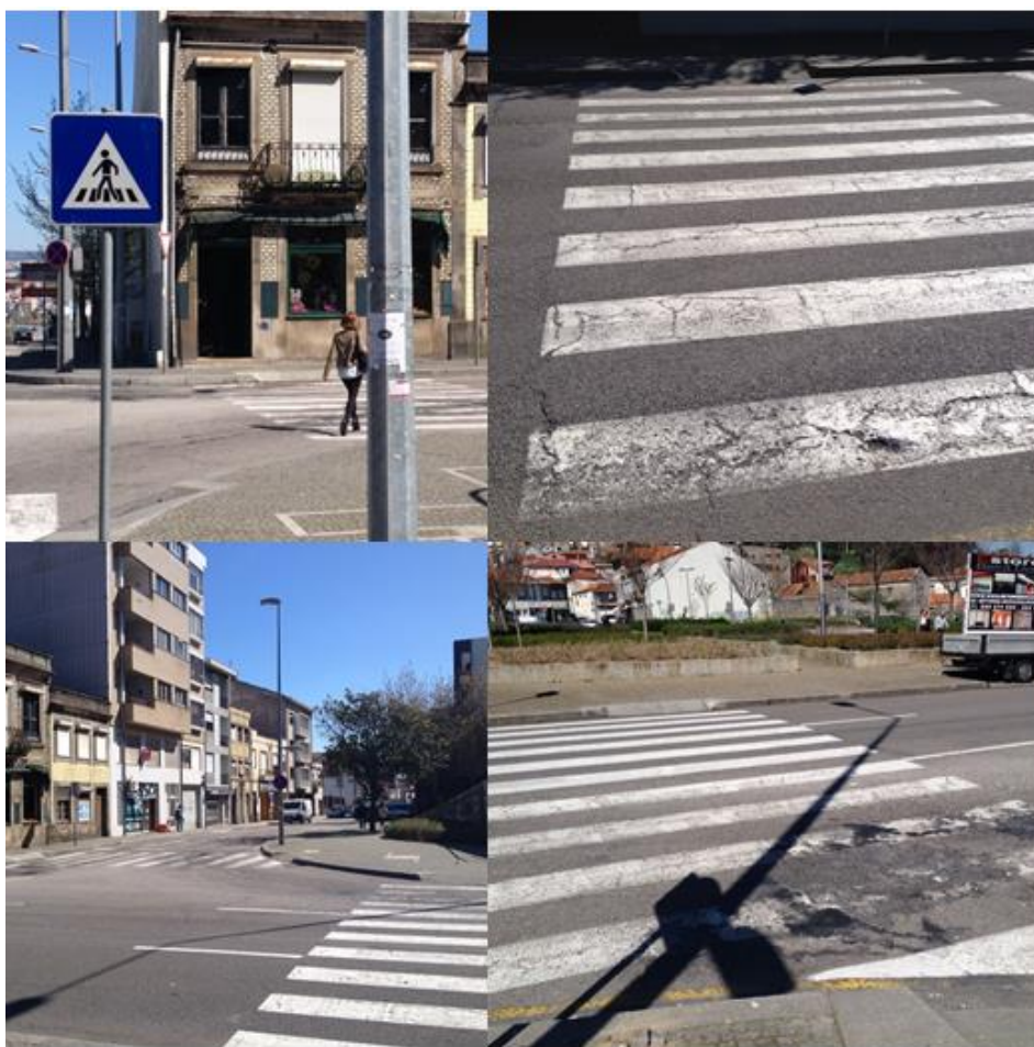
Figura 19 - Pormenor das passadeiras
