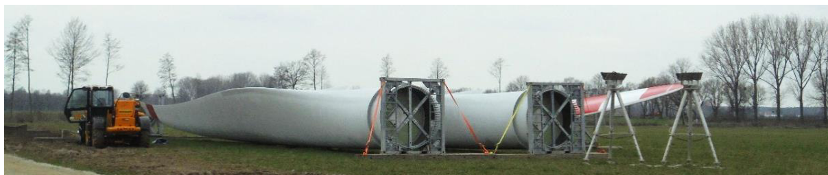
Fig. 24 – Conjunto de Pás de um aerogerador Senvion MM92
