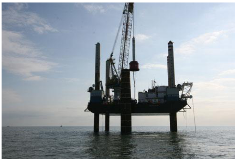
Fig. 38 – Instalação da fundação por estaca (London Array Limited 2013)
