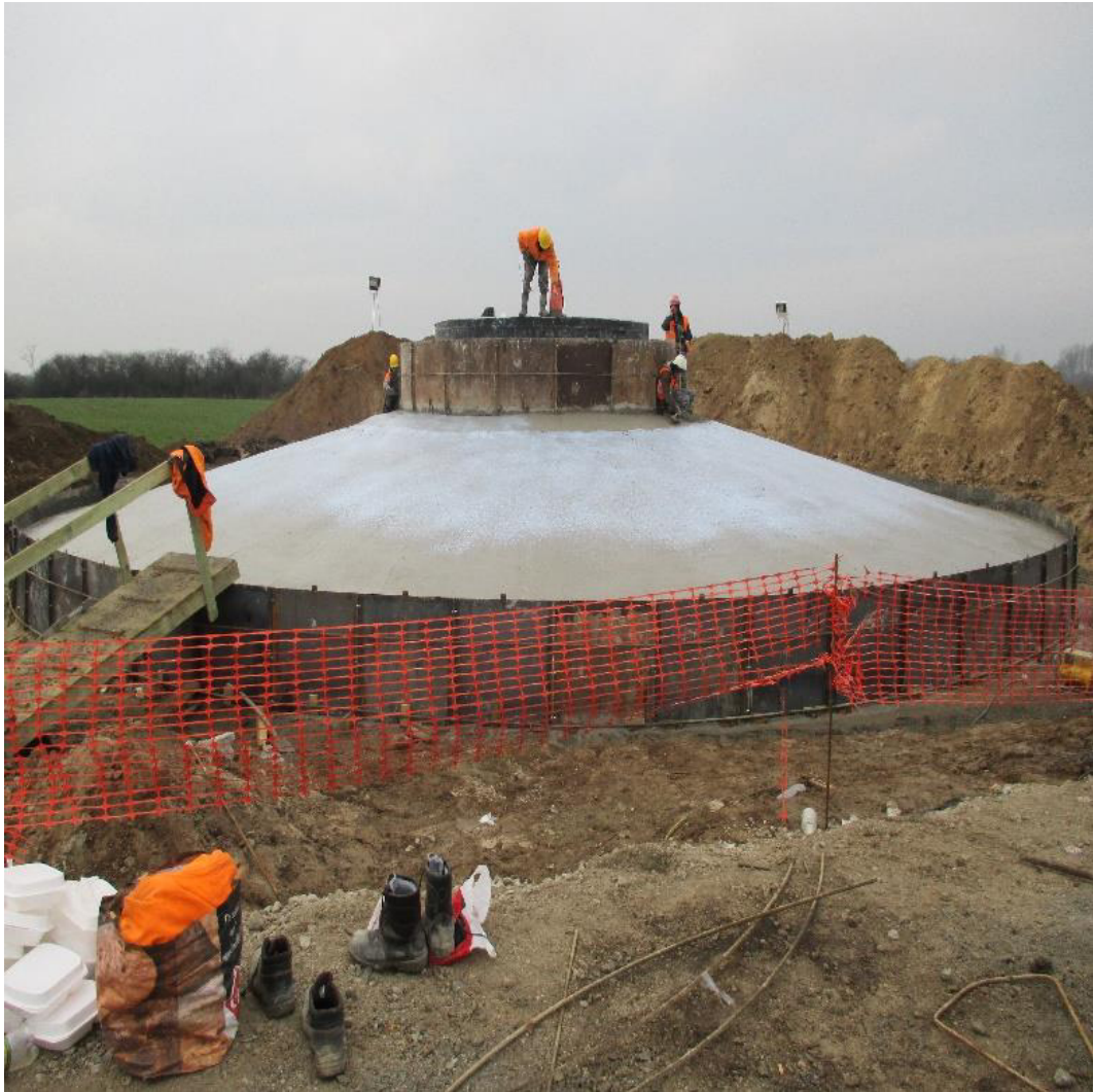
Fig. 16 – Fundação direta de um aerogerador
