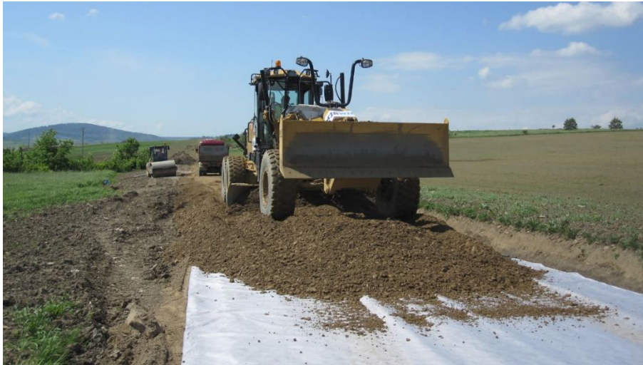
Fig. 26 – Construção de acessos (CJRWind 2014a)
