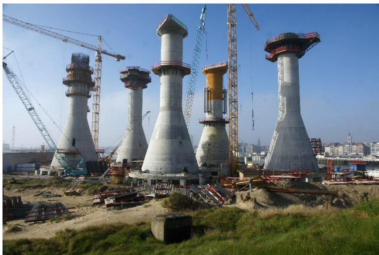
Fig. 35 – Fundações por gravidade em construção (C-POWER NV 2013)
