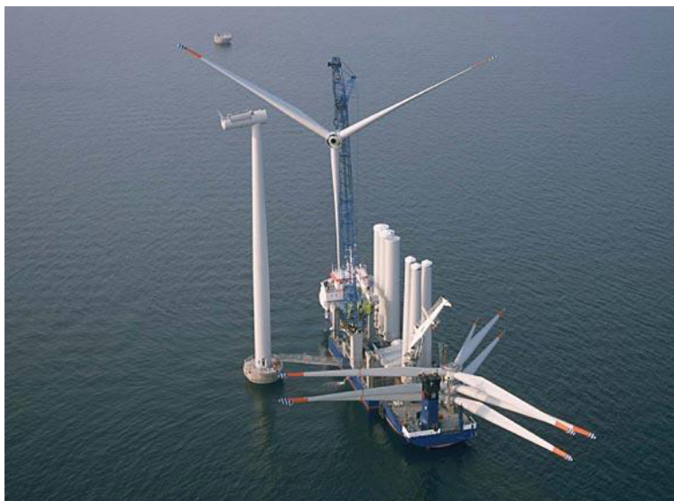
Fig. 45 – Montagem de um aerogerador no mar – altura do cubo 69 m (Nysted Offshore Wind Farm 2006)
