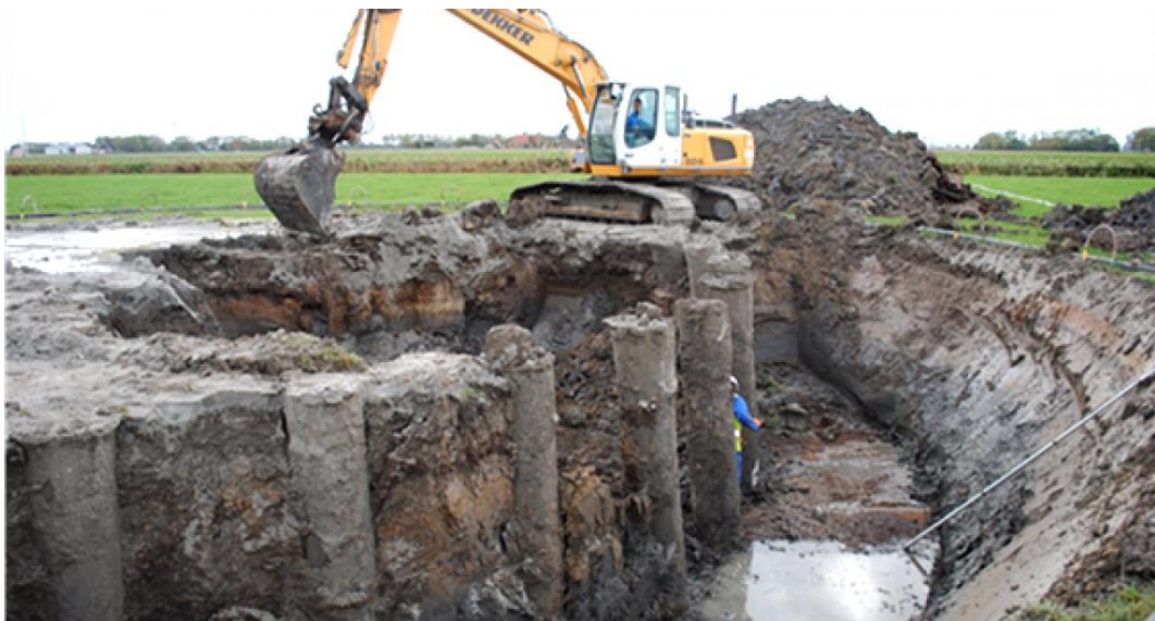
Fig. 17 – Construção de fundação indireta (BLIX 2012)
