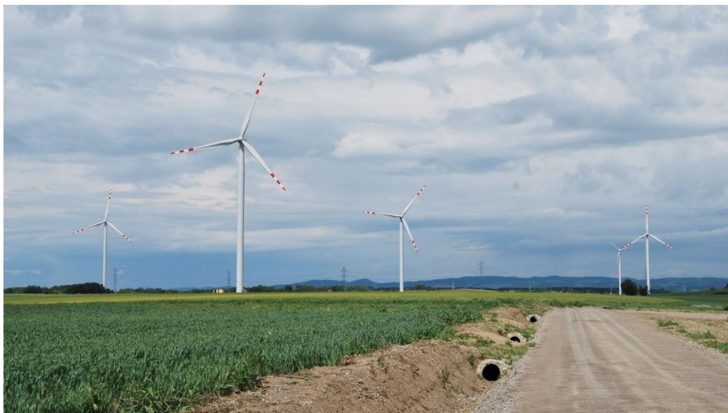
Fig. 31 - Parque Eólico em Rymanów (CJRWind 2014c)
