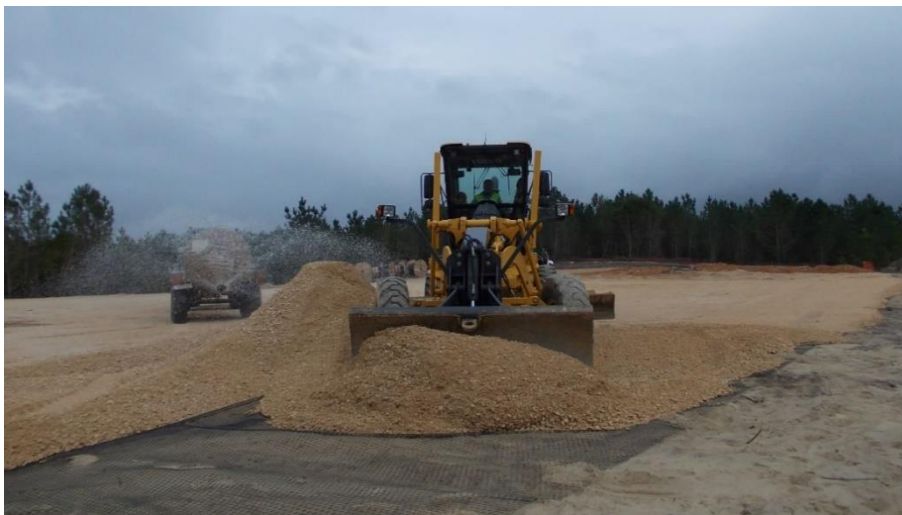
Fig. 27 - Construção da Plataforma de Trabalho (CJRWind 2014b)
