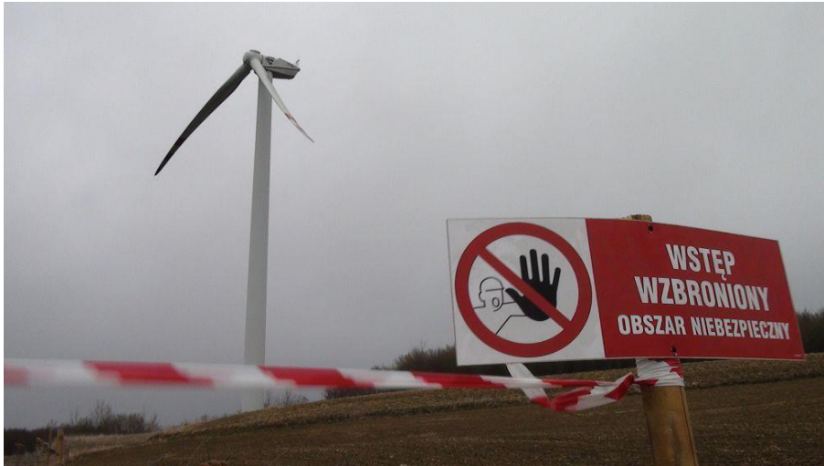
Fig. 14 – Avaria de um aerogerador (Esanok 2015)
