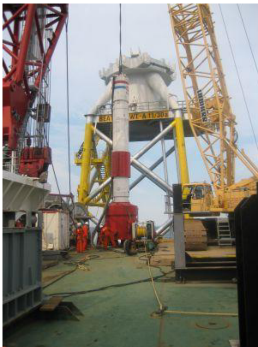
Fig. 42 – Instalação das estacas de fixação (Volker Stevin International 2006)
