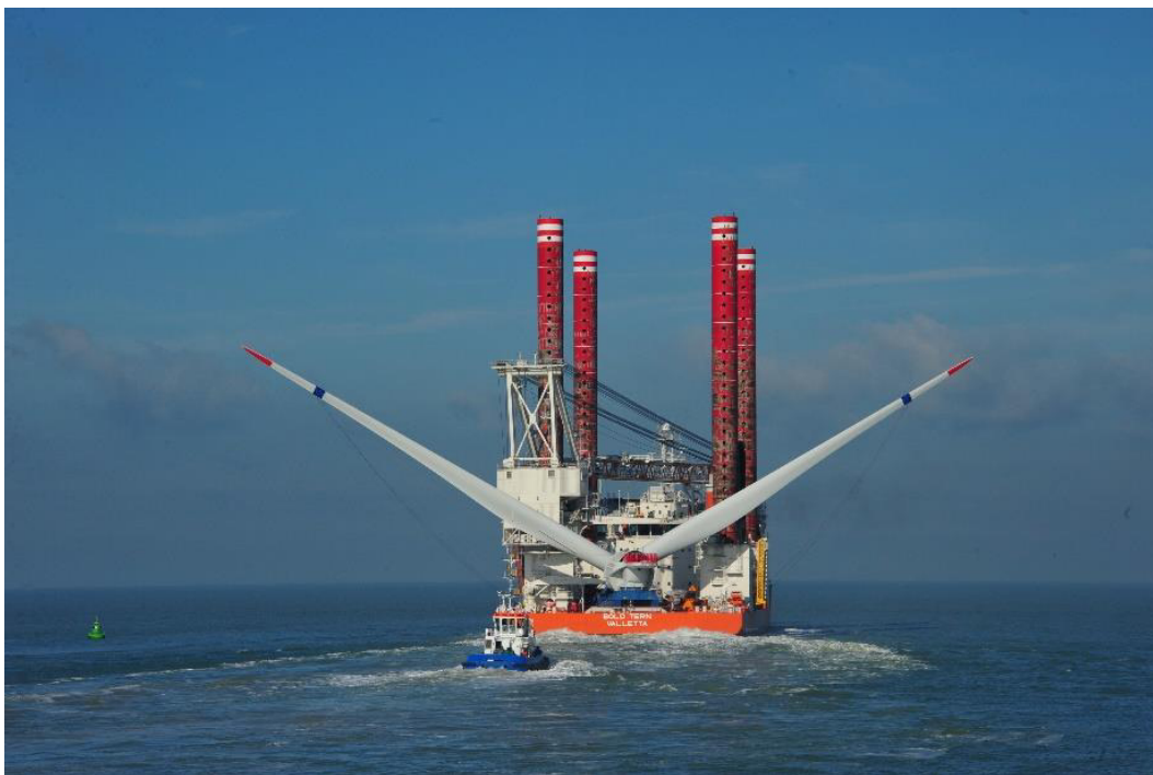
Fig. 51 – Transporte de rotor parcialmente montado e cabine do aerogerador Alstom Haliade 150 (Job 2013)
