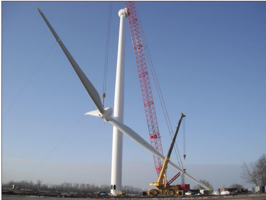
Fig. 22 – Elevação do Rotor (Linkhorn 2012)
