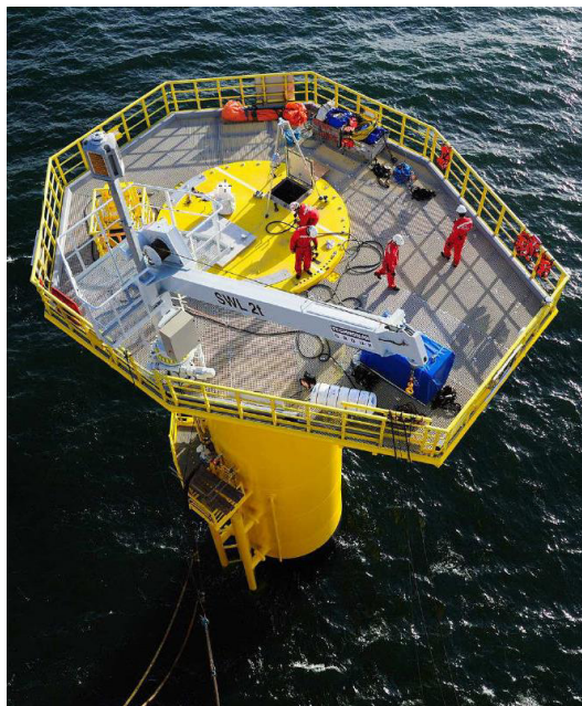
Fig. 48 – Plataforma de trabalho numa peça de transição (EWE AG 2012)
