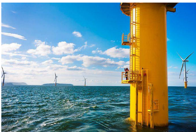
Fig. 46 – Peça de Transição (RWE Innogy 2012)
