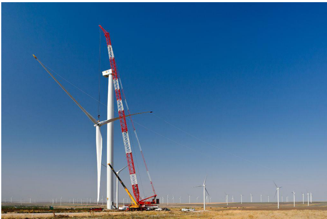
Fig. 32 - Elevação do Rotor, com um diâmetro aproximado de 99 m (ČEZ Group 2015)
