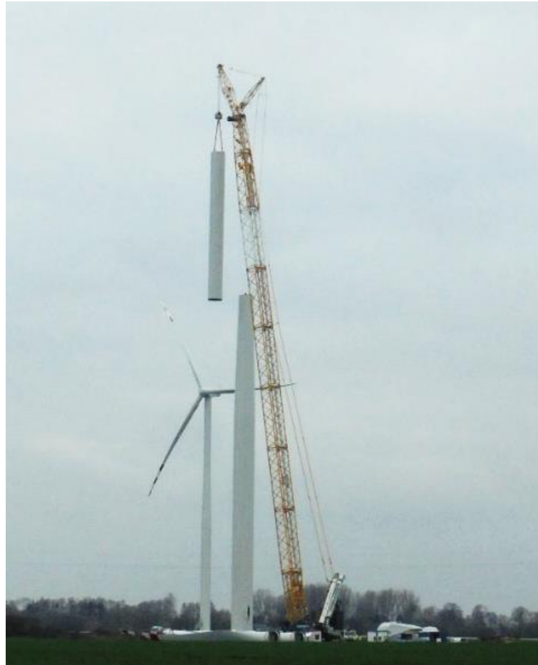
Fig. 19 – Processo de Montagem da Torre de um aerogerador Senvion MM92
