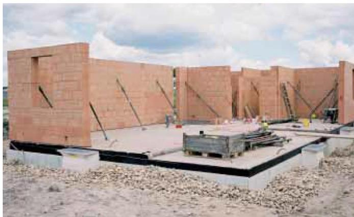
Figura 43: Princípio de construção em painéis de alvenaria resistente [56].
