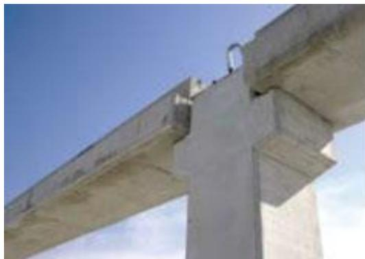
Figura 10: Prefabricação pesada: Viga de betão [64].
