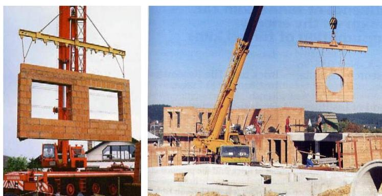
Figura 2: Instalação em obra de paredes em alvenaria prefabricadas [42].
