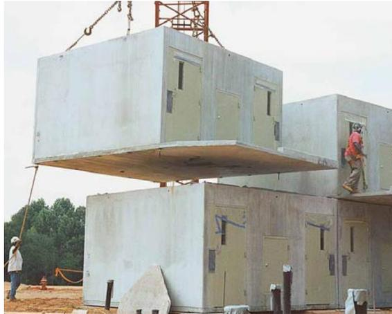
Figura 8: Princípio de montagem de módulos prefabricados [49].
