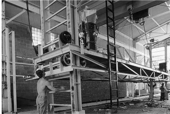
Figura 39: Construção de parede de alvenaria com andaime ajustável [55].
