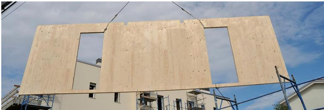
Figura 9: Prefabricação leve: Parede de compartimentação [63].
