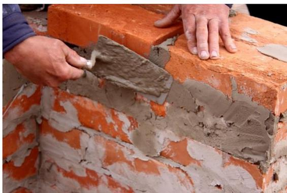
Figura 1: Execução de parede em alvenaria pelo método tradicional [41].
