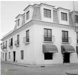
FIG. 16 Foto antiga dos Torrões que "encerram" à Praça Marquês de Pombal
