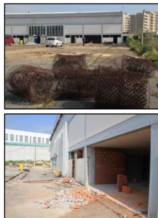
Figura 2 - Obras no Pavilhão Desportivo
