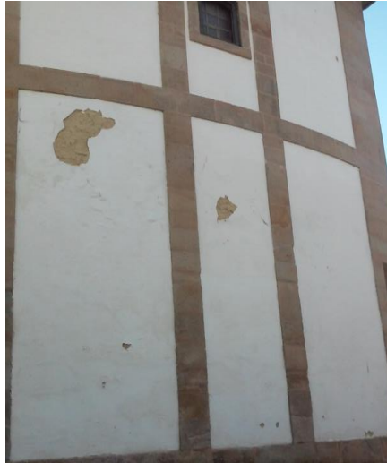
Fig.3.29 - Destacamento do acabamento.
