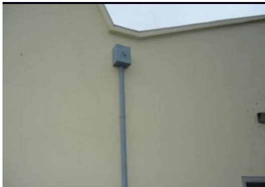
Fig.5.53 - Fachada Norte, não fissurada.
