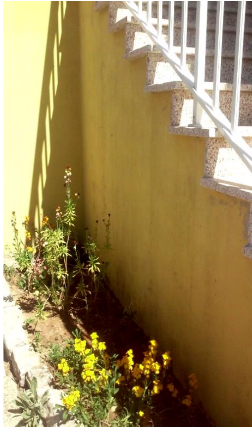
Fig.3.34 - Tinta com sujidade depositada.
