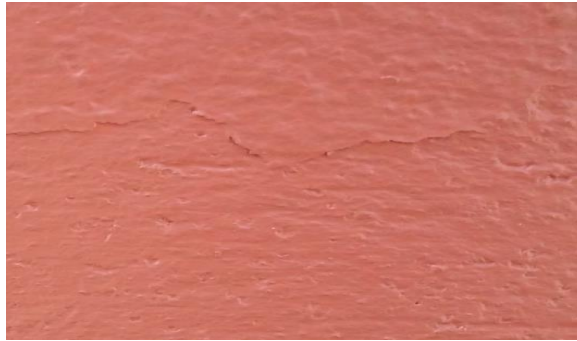
Fig.3.4 - Zona onde é visível onde teve duas demãos ou só uma.
