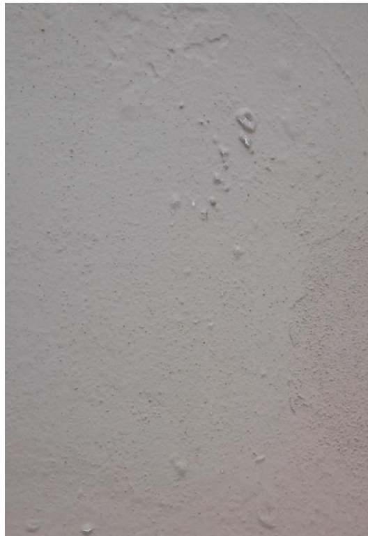
Fig.3.44 - Empolamento da película de tinta.
