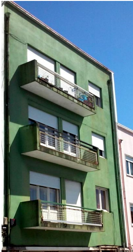
Fig.3.16 - Fachada com descoloração da película de tinta.
