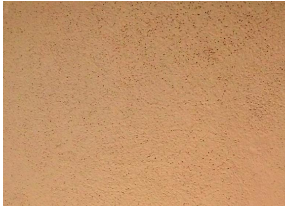
Fig.3.2 - Fachada com película de tinta com aspeto de bicos de alfinete.
