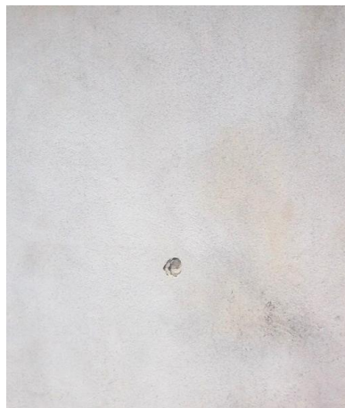
Fig.3.56 - Perfuração no sistema ETICS.
