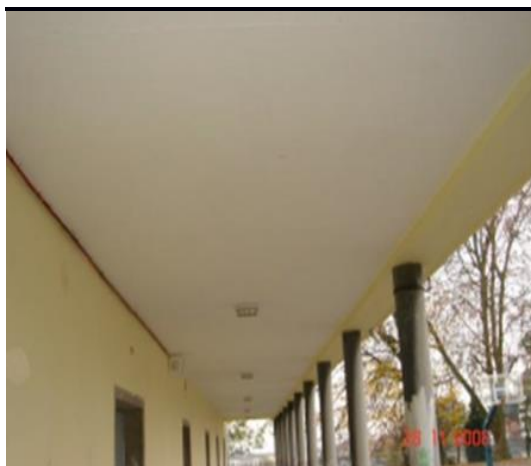
Fig.5.50 - Fachada Este sem eflorescências com manchas.
