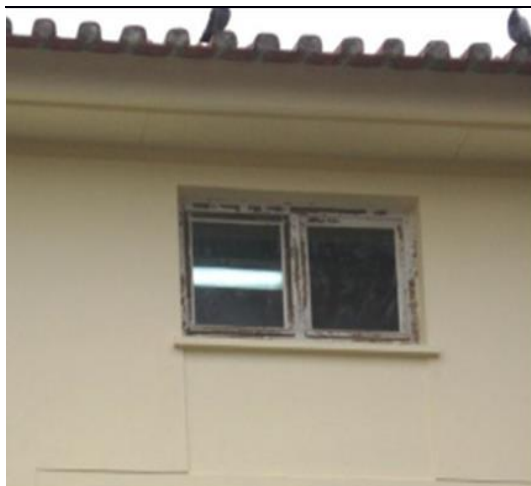
Fig.5.49 - Fachada sem fissuração ou destacamento do revestimento com perda de cobertura.
