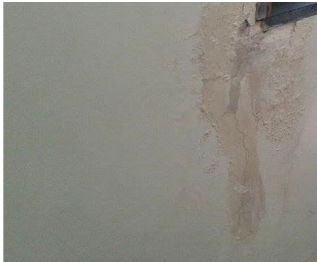
Fig.3.13 - Saponificação da pintura.
