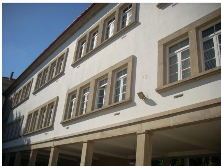
Fig.4.12 - Fachada da Escola Básica do Sol.
