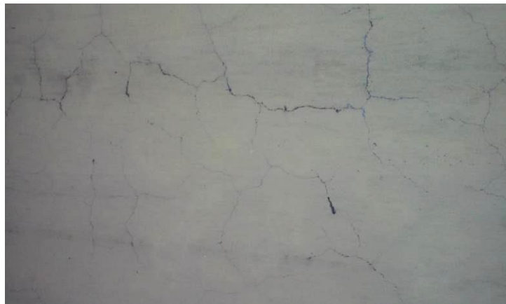
Fig.3.39 - Fissuração generalizada.
