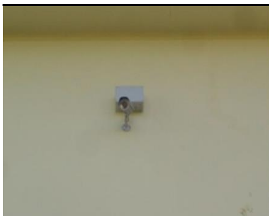
Fig.5.51 - Parte da fachada Este, sem destacamento de revestimento com manchas.
