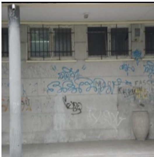
Fig.5.47 - Fachada com grafites e sujeidade.
