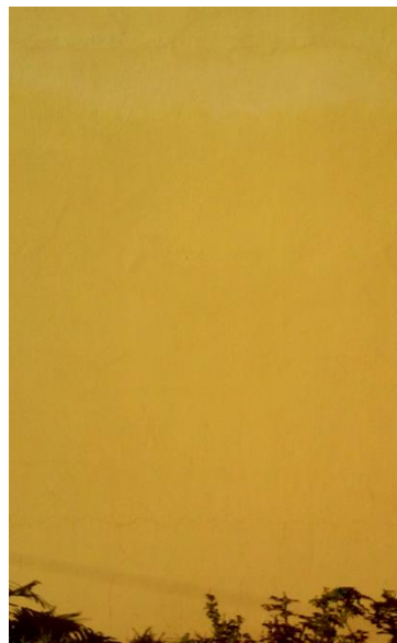
Fig.3.33 - Fachada com descoloração de tinta.
