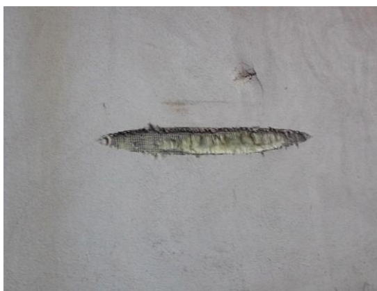
Fig.3.57 - Dano causado por choque com o sistema ETICS.
