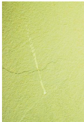
Fig.3.6 - Escorrimento de tinta.
