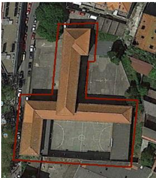
Fig.4.11 - Vista aérea da Escola Básica do Sol.
