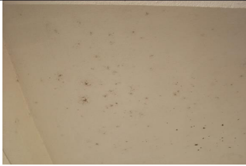
Fig.5.60 - Sujidade na fachada N2.
