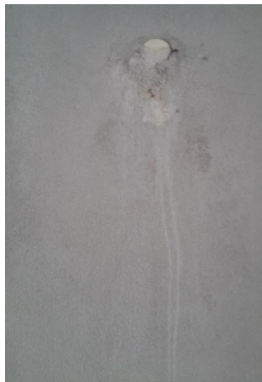
Fig.3.52 - Saponificação da tinta em sistema ETICS.
