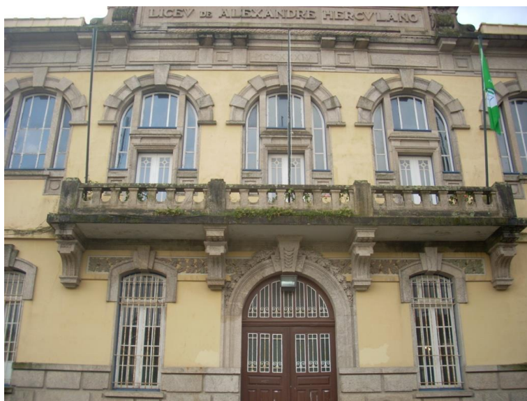
Fig.4.3 - Fachada da Escola Secundária Alexandre Herculano.
