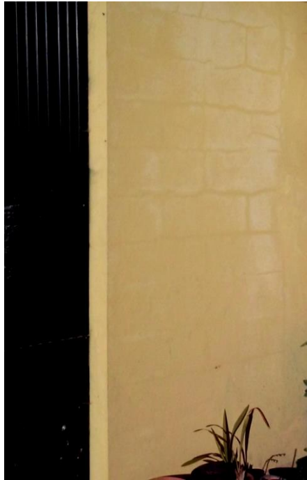
Fig.3.15 - Tinta com descoloração.
