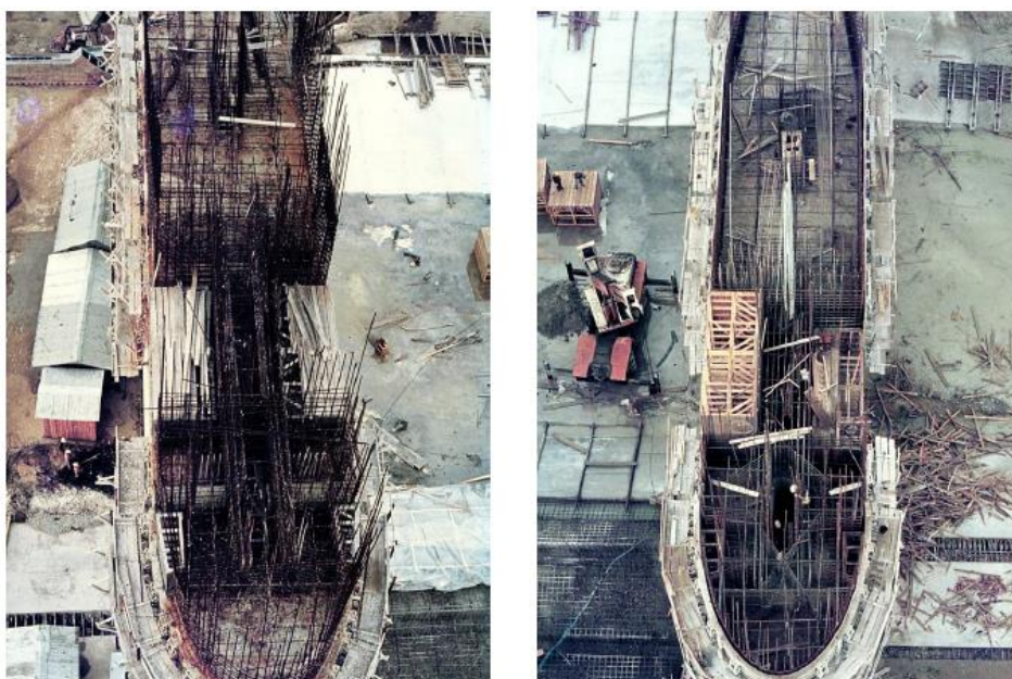
Fig. 2.13 - Pormenor da Construção dos Pilares (Armaduras + Ranhuras) [7]
