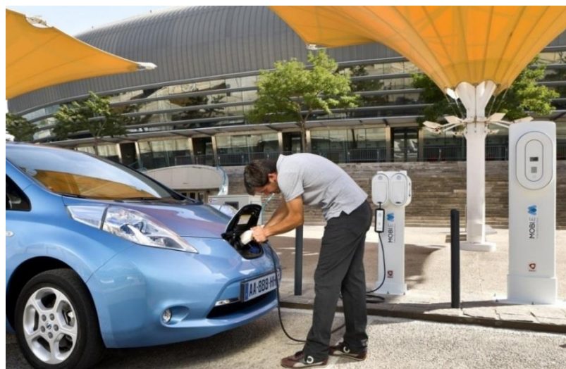
Figura 5.6 - Ponto de carregamento de veículos elétricos da rede MOBI.E [124]
