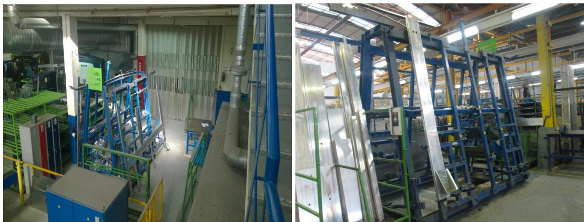
Figura 19- Antes e depois da pré-montagem dos painéis.
