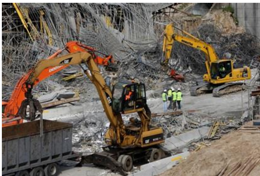
Figura 2.2 - Estaleiro de obra de construção civil [2]
