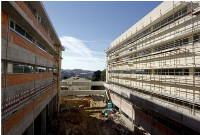
Figura 2.1 – Estaleiro de obra de construção civil [1]
