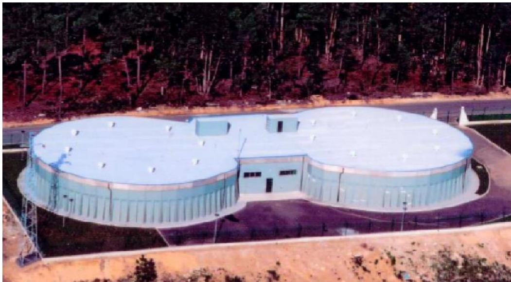
Fig.2.11 - Reservatório com duas células de seção circular com elementos pré-fabricados [17]
