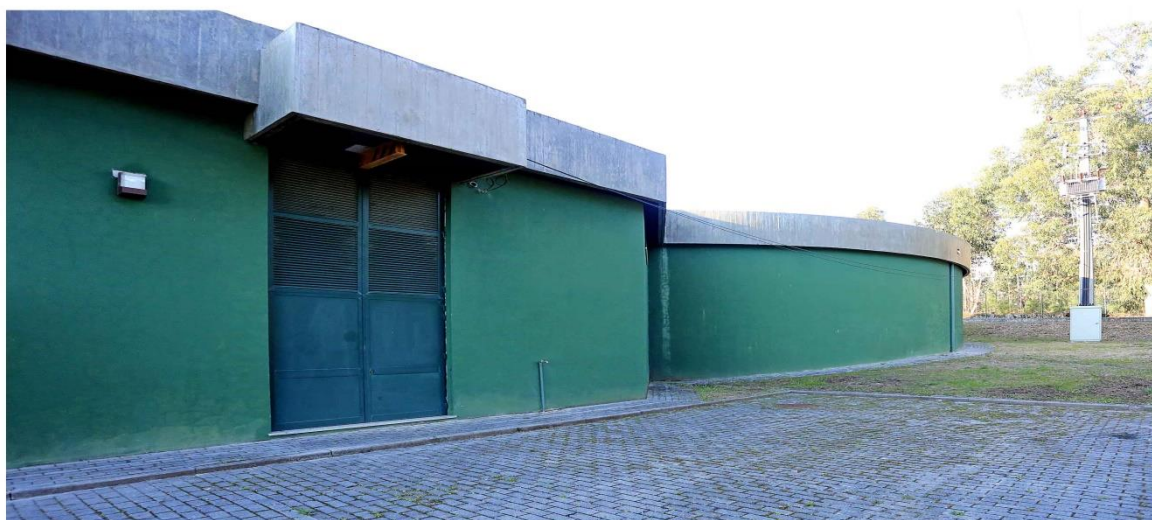
Fig.4.4 – Exterior do reservatório de Vila Chã
