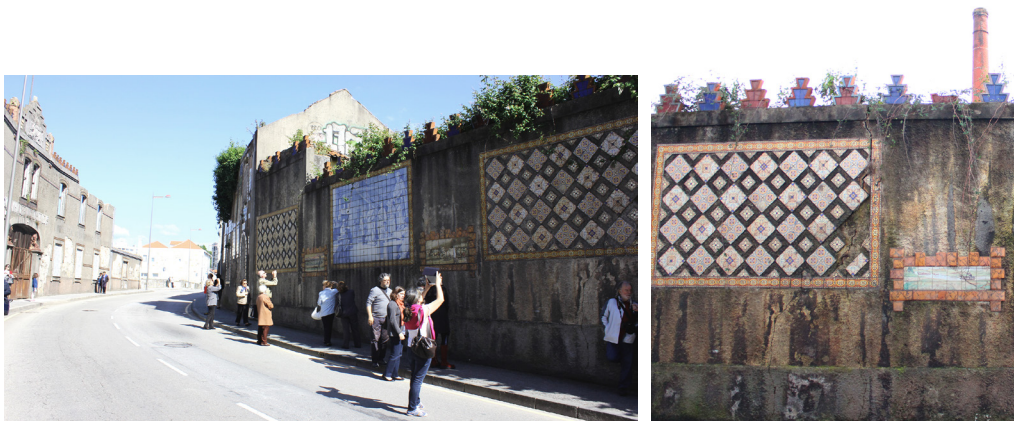
Fig. 27 - Muro-mostruário e pormenor
