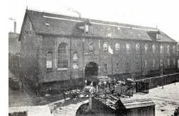
Fig. 36 - Armazém de Expedições e ramal ferroviário
