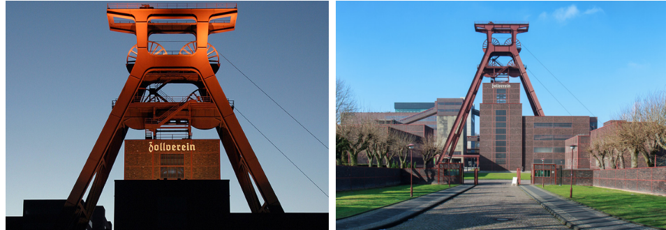
Fig. 87 - edifício da antiga mina de carvão Zeche Zollverein
