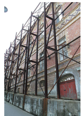
Fig. 48 - Estrutura metálica de contenção da fachada
