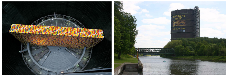
Fig. 88 - Gasómetro em Oberhausen
