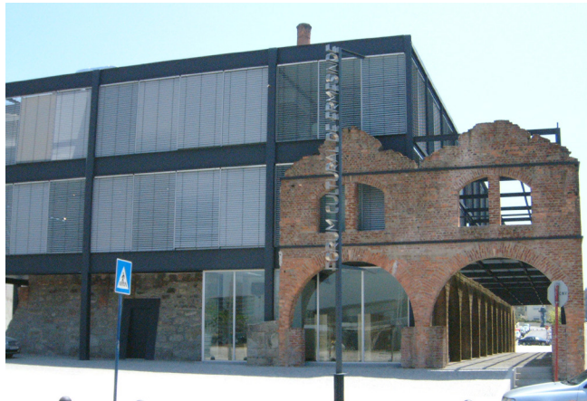
Fig. 64 - Fórum vista norte
