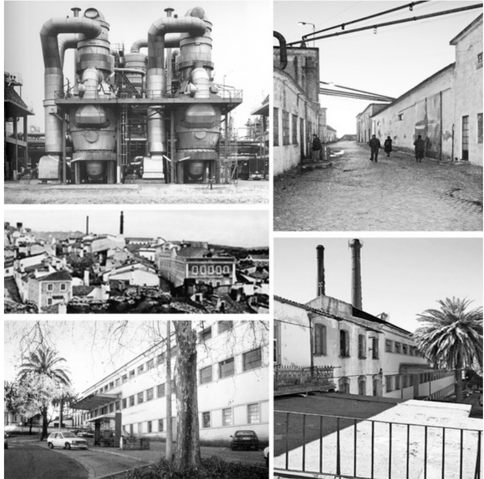
Fig. 68 - Fotografias anteriores à intervenção
