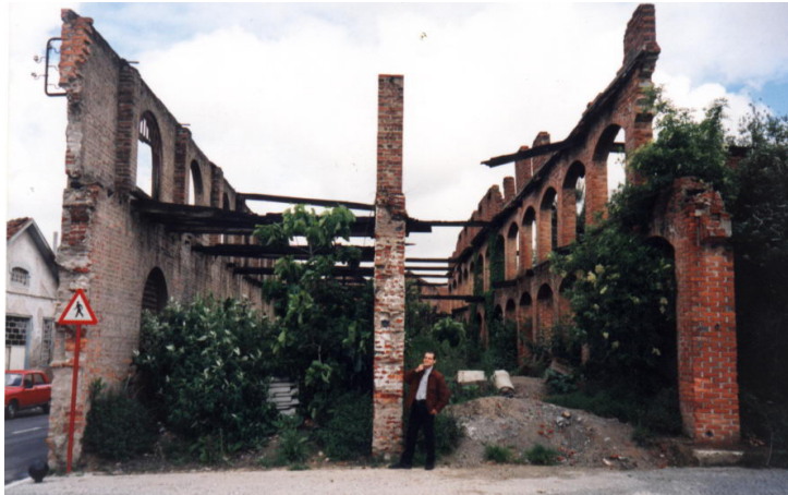
Fig. 58 - Estado de conservação da Fábrica antes da intervenção
