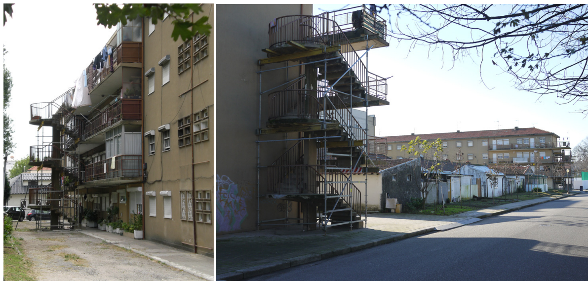
Figura 34: Bairro dos CTT - Pereiró, 1956. Vista da Rua dos Cedros: fachada exterior do Bloco A. Vista da Rua dos Plátanos: topo do Bloco A e fachada interior do Bloco B (Fonte: arquivo da autora, 2009, 2011)
