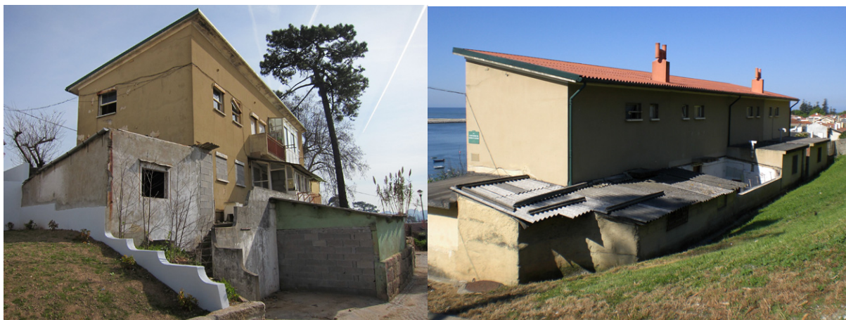
Figura 19: Anexos e acrescentos construídos pelos moradores nas casas originais. (Fonte: arquivo da autora, 2012, 2009)
