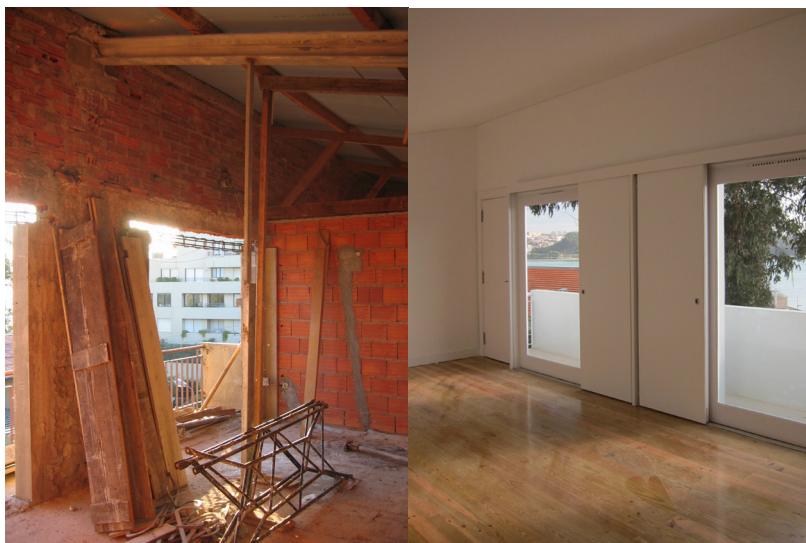
Figura 17: Sala de estar dos novos T3: obra (reforço estrutural) e resultado final. (Fonte: arquivo da autora, 2009, 2012)
