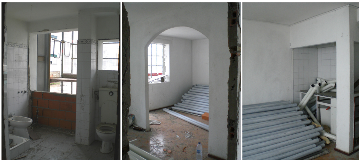
Figura 22: Obras no interior de um alojamento devoluto no Bairro de Francos, no Porto. (Fonte: arquivo da autora, 2009)
