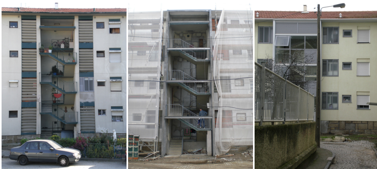
Figura 21: Reabilitação do Bairro de Francos, no Porto. Fecho das circulações comuns. (Fonte: arquivo da autora, 2009)
