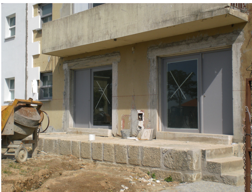
Figura 18: Obra em curso: aplicação de sistema ETICS; novo vão-tipo (junção de dois vãos existentes); plataforma de acesso ao piso térreo. (Fonte: arquivo da autora, 2009)
