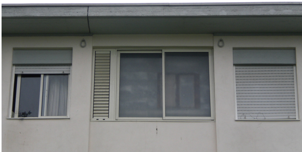
Figura 1: Reabilitação do Bairro do Regado, Porto. Solução de fecho dos secadouros, deixando a alteração que os residentes haviam realizado antes por trás da nova caixilharia (Fonte: arquivo da autora, 2009)
