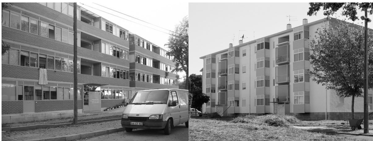
Figura 6: Reabilitação da envolvente exterior e fecho de circulações comuns nos bairros de Paranhos (galeria) e Ramalde (esquerdo/direito) (Fonte: arquivo da autora, 2009, 2006)
