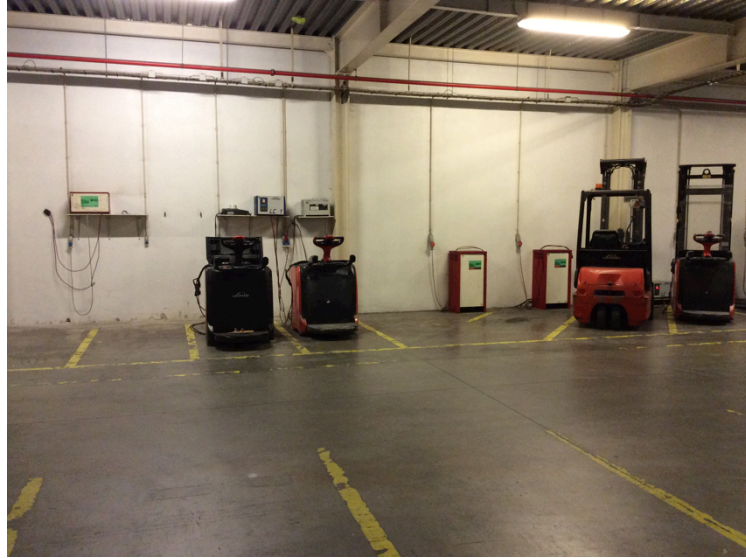
Figura 16 – Posto de recarregamento dos empilhadores.
