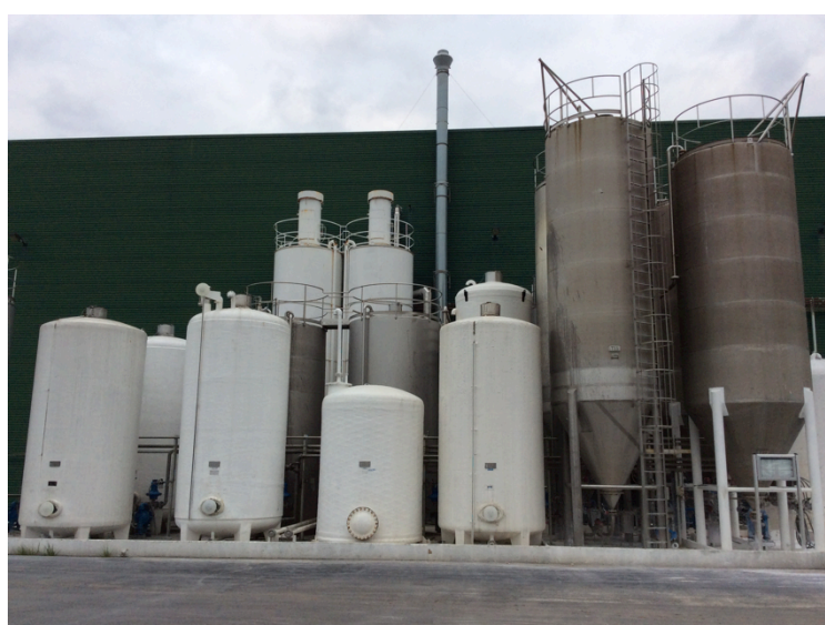
Figura 9 - Cais de descarga das resinas, slurries e água.
