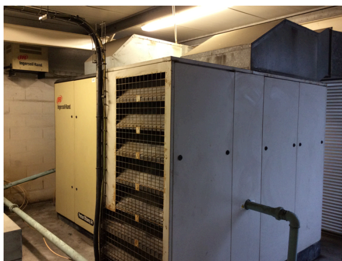
Figura 15 – Compressores principal e secundário.
