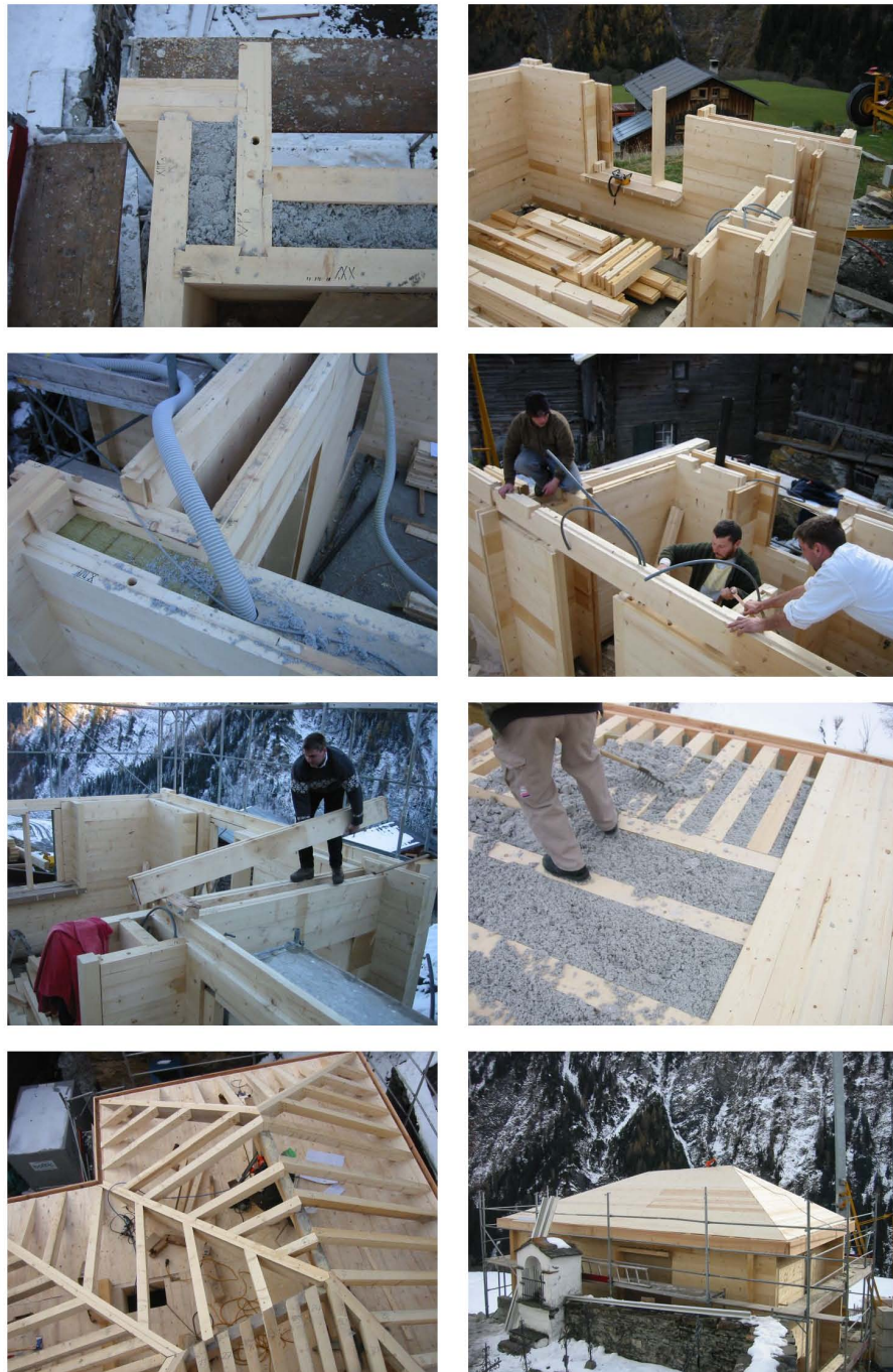
Fig.53 CONSTRUÇÃO DE STVA DA MORTS, VRIN, 2002.
