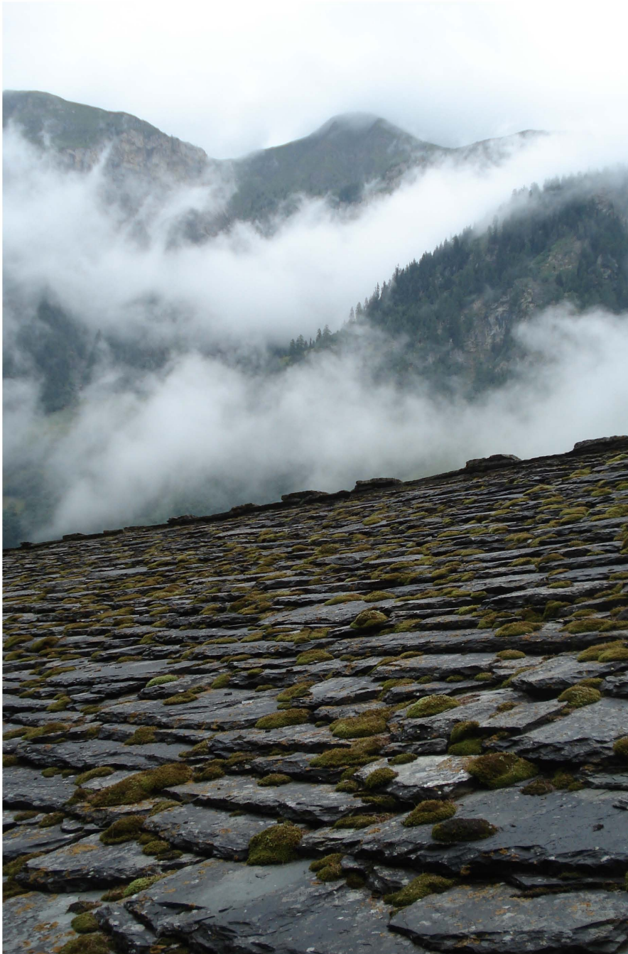
Fig.70 TELHADO EM PEDRA, VALS, 2010.
