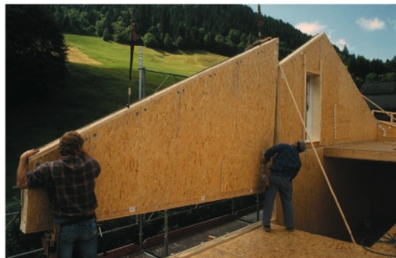
FIG.65 CASA WILLIMANN-LÖTSCHER, CONSTRUÇÃO DA ESTRUTURA EM 8 HORAS.
