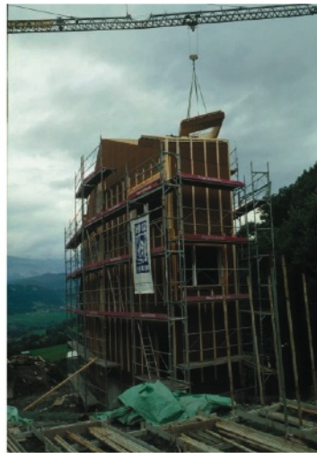
FIG.66 CASA WILLIMANN-LÖTSCHER, CONSTRUÇÃO DA ESTRUTURA EM 8 HORAS.
