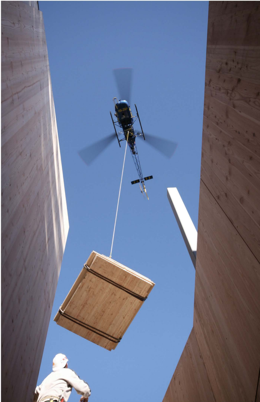
Fig.31 EDIFÍCIO EM CONSTRUÇÃO, SISTEMA MACIÇO.
