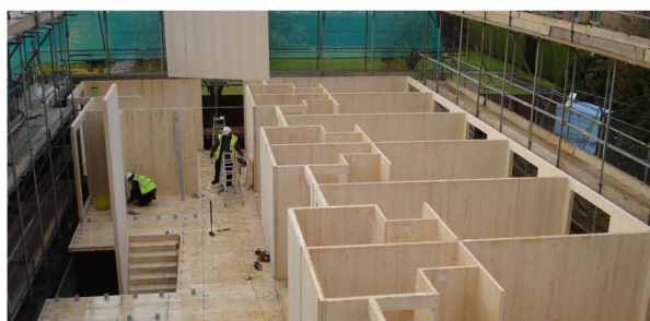
Fig.33 Construção de um edifício usando painéis maciços em madeira, K.L.H.
