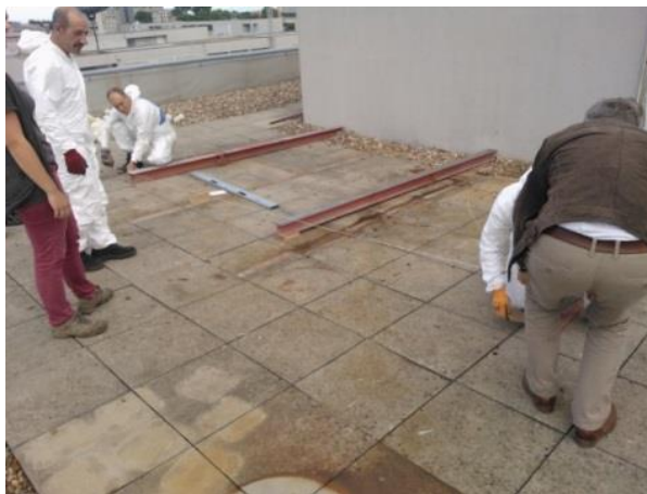
Figura 5.1 - Nivelção do chão da cobertura do edifício L da FEUP.
