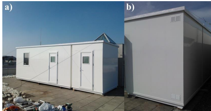
Figura 5.4 - a) TDF e casa das máquinas fixadas com cordas de aço e b) grelhas instaladas na casa de máquinas.
