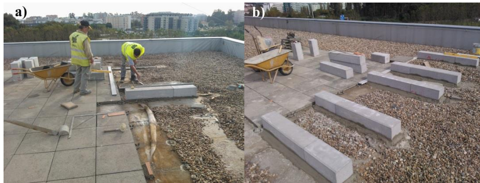
Figura 5.5 - a) Aplicação de cimento para fixação dos blocos e b) disposição dos blocos no final da colocação
