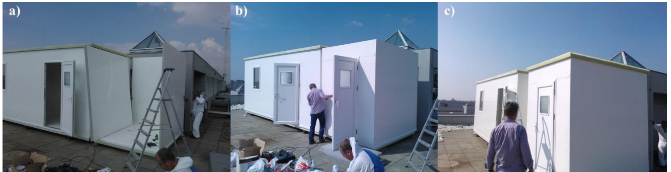
Figura 5.3 - Montagem da casa das máquinas em diferentes fases: a) colocação do chão, b) colocação das paredes e porta e c) colocação do teto.
