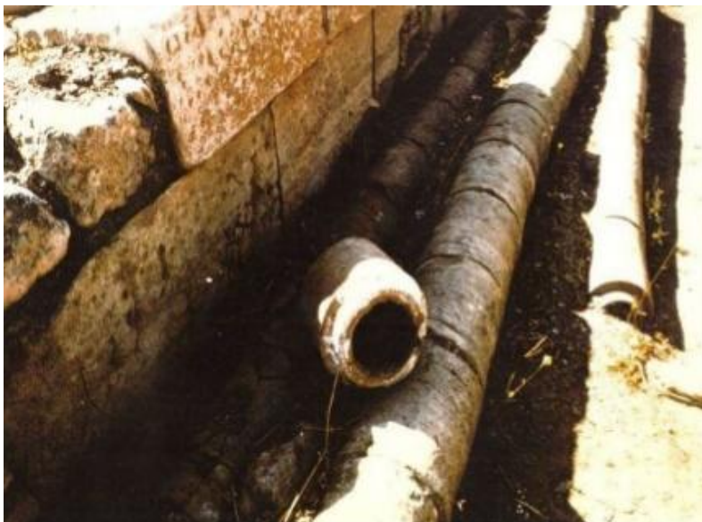
Fig. 1 - Canalização de esgoto na Babilónia [3].
