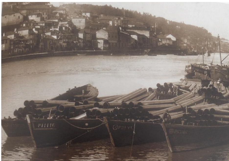
Fig. 9 - Tubagem a despacho no rio Douro em 1930 [7].
