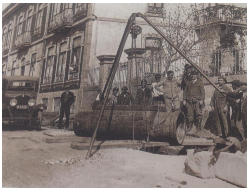
Fig. 10 - Limpeza de conduta adutora em 1930 [7].
