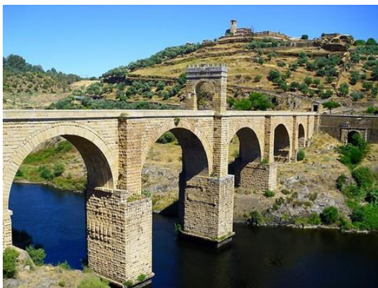
Figura 2.2: Ponte de Alcântara sobre o Tejo [7]
