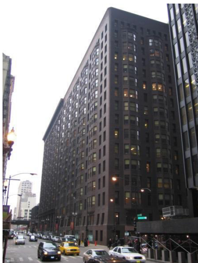
Figura 2.3: Fachada do Monadnock Building, em Chicago [8]
