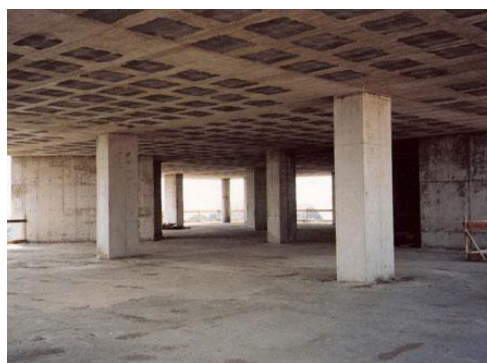
Figura 2.14: Lajes fungiformes Aligeiradas com Blocos Perdidos [18]
