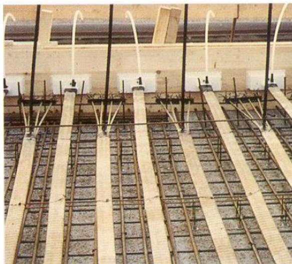
Figura 6.3: Posição das ancoragens do cabo de pré-esforço [33]
