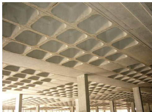
Figura 2.15: Laje Fungiforme com Moldes Recuperáveis [19]
