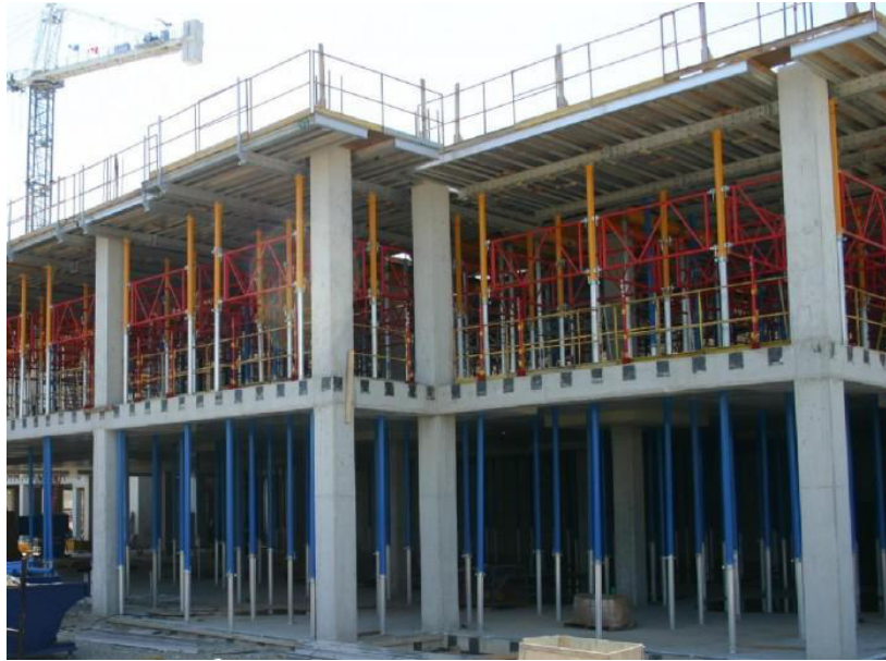
Figura 4.1: Escoramento de uma laje [26]
