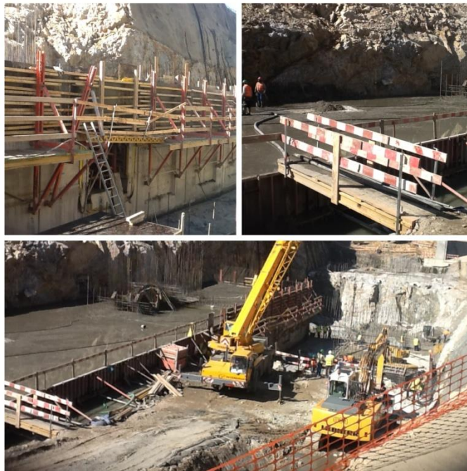
Figura 4.51 - Bloco depois de betonado (Ribeiradio).
