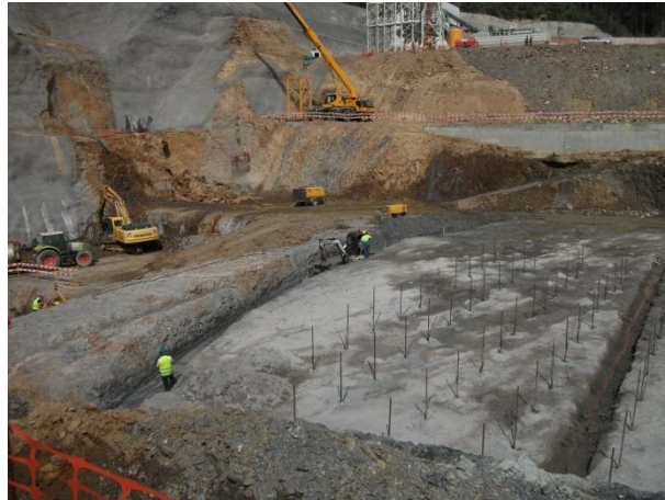
Figura 4.92 - Valas secundárias para baixar o nível freático
