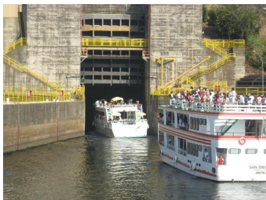
Figura 2.22 - Eclusa de navegação.
