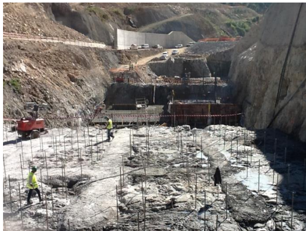
Figura 4.73 - Rede de drenagem fechada. Pregagens
