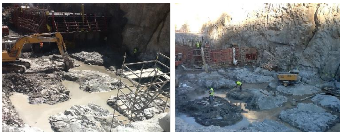
Figura 4.68 - Limpeza da fundação
