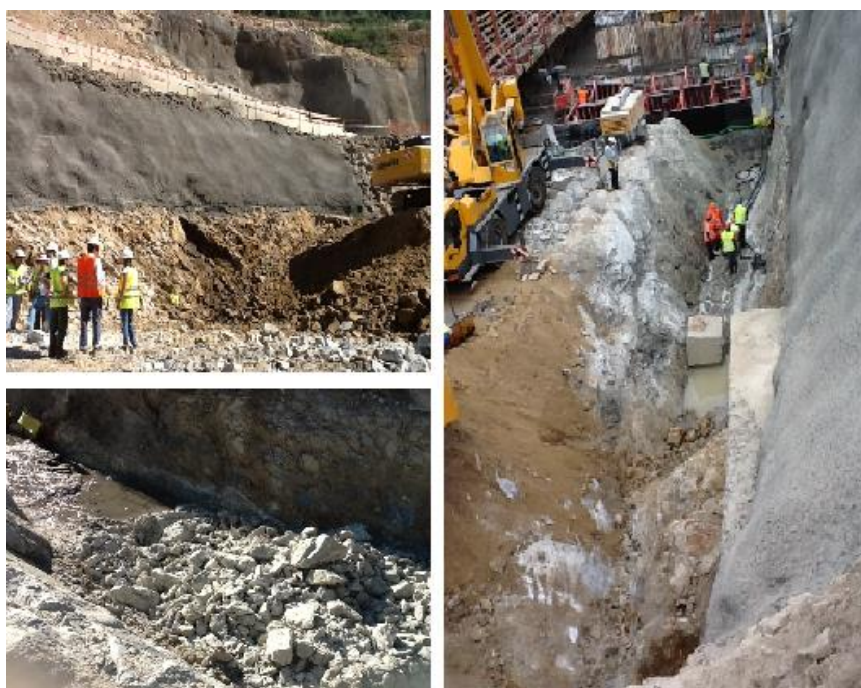
Figura 4.62 - Escavação da falha
