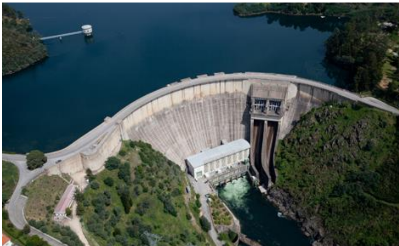
Figura 2.4 - Barragem de Castelo de Bode. [3]
