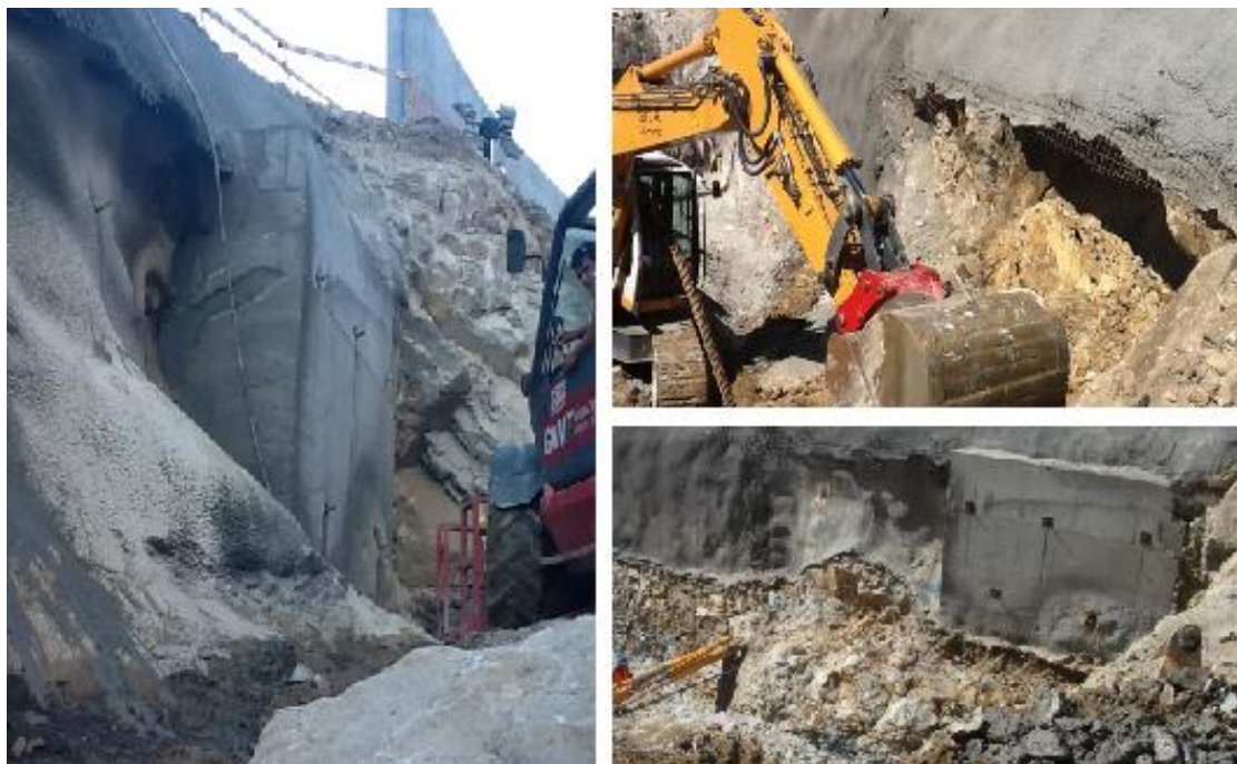
Figura 4.63 - Solução de contenção
