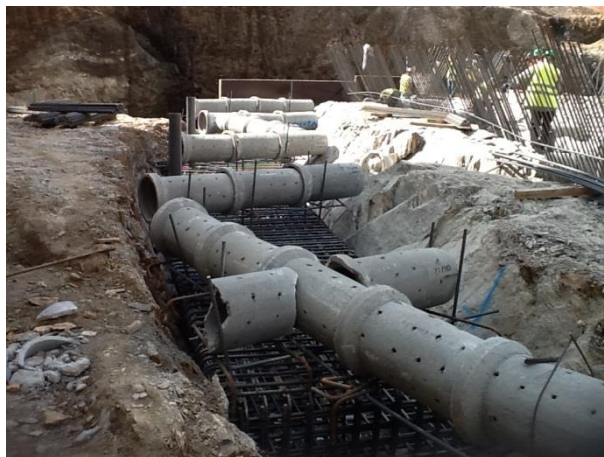
Figura 4.95 - Recrava e aplicação das manilhas de betão.
