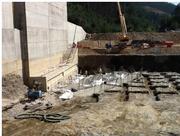
Figura 4.96 – Recravas betonadas
