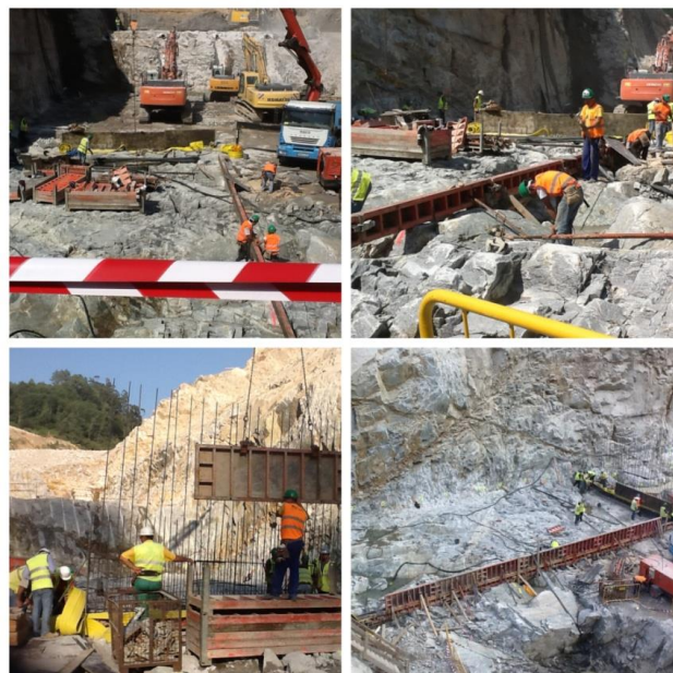
Figura 4.45 - Montagem da cofragem (Ribeiradio).
