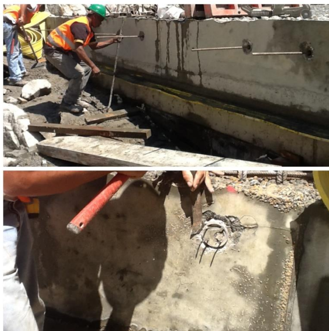
Figura 4.49 - Negativos e escoramento para a cofragem trepante (Ribeiradio).
