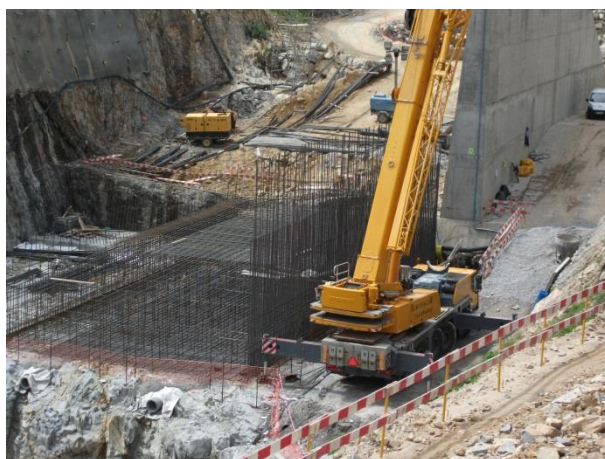
Figura 4.74 - Montagem da armadura
