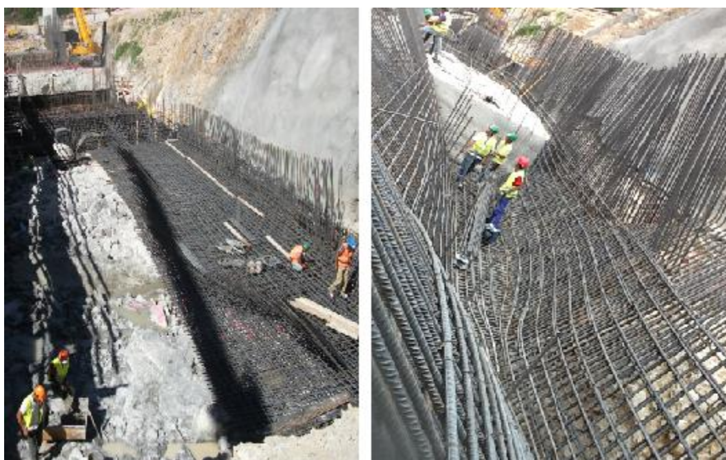
Figura 4.66 - Montagem da armadura total da recrava
