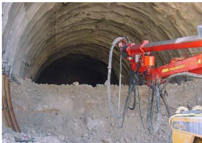
Figura 4.30 - Escavação do túnel em bancada.
