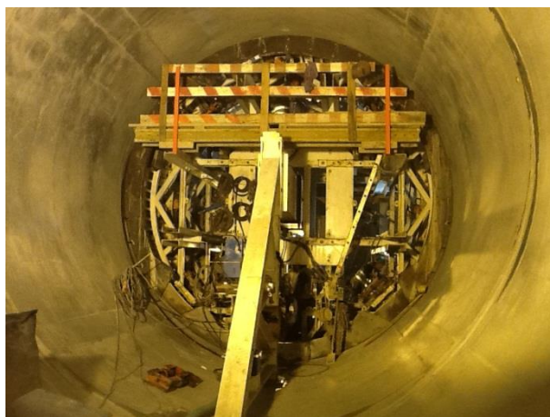
Figura 4.85 - Trabalhos de revestimento
