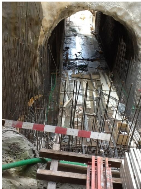
Figura 4.89 - Betonagem da Soleira da Galeria de Restituição
