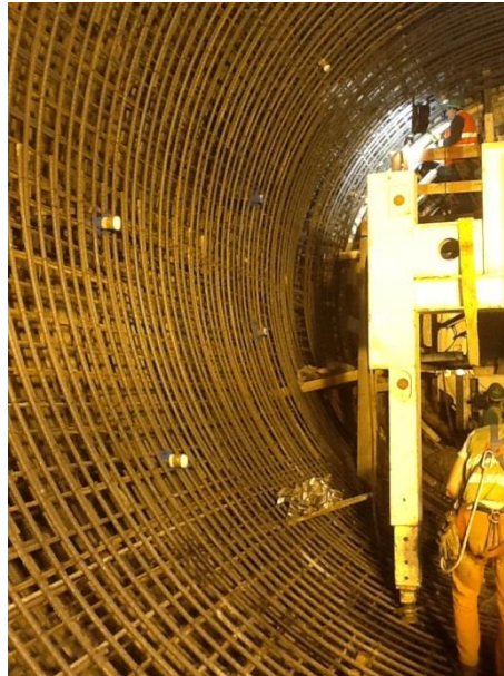
Figura 4.83 – Armaduras e negativos
