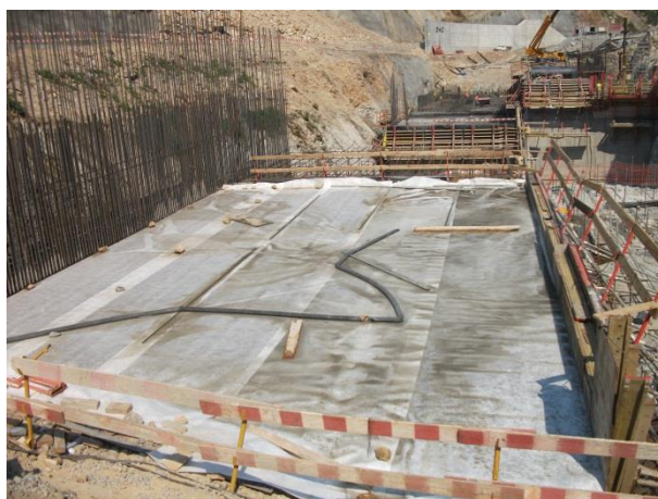
Figura 4.75 - Aplicação do geotêxtil para a cura de betão
