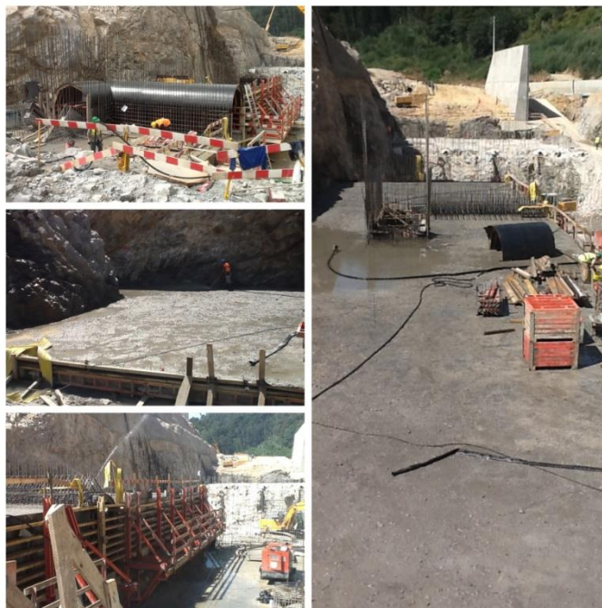
Figura 4.50 - Montagem da cofragem. Bloco depois de betonado. (Ribeiradio)
