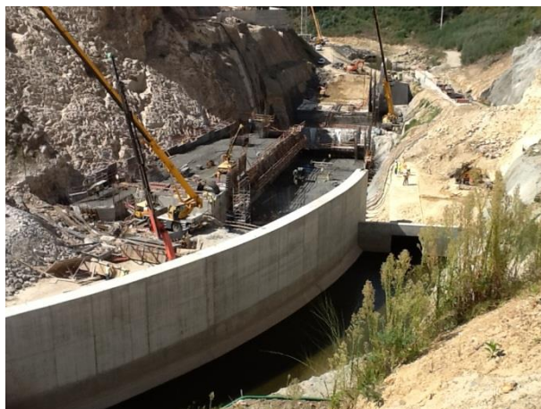
Figura 4.20 - Desvio do rio e elevação dos blocos da fundação.
