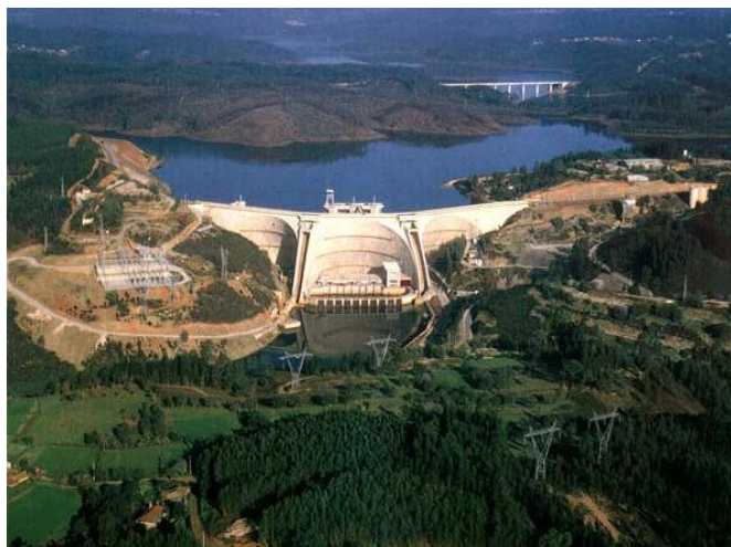
Figura 2.6 - Barragem da Aguieira. [3]
