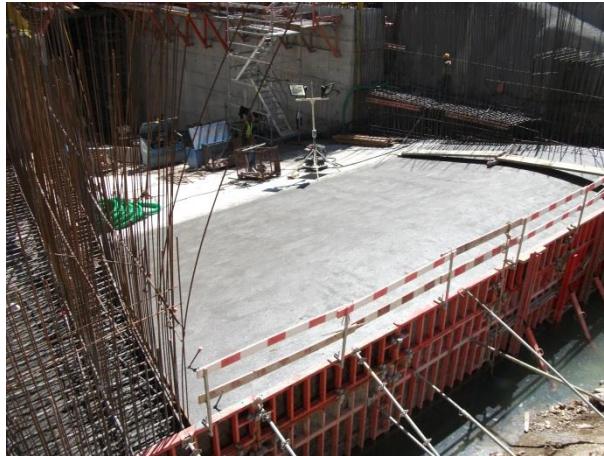
Figura 4.90 – Betonagem da saída da restituição
