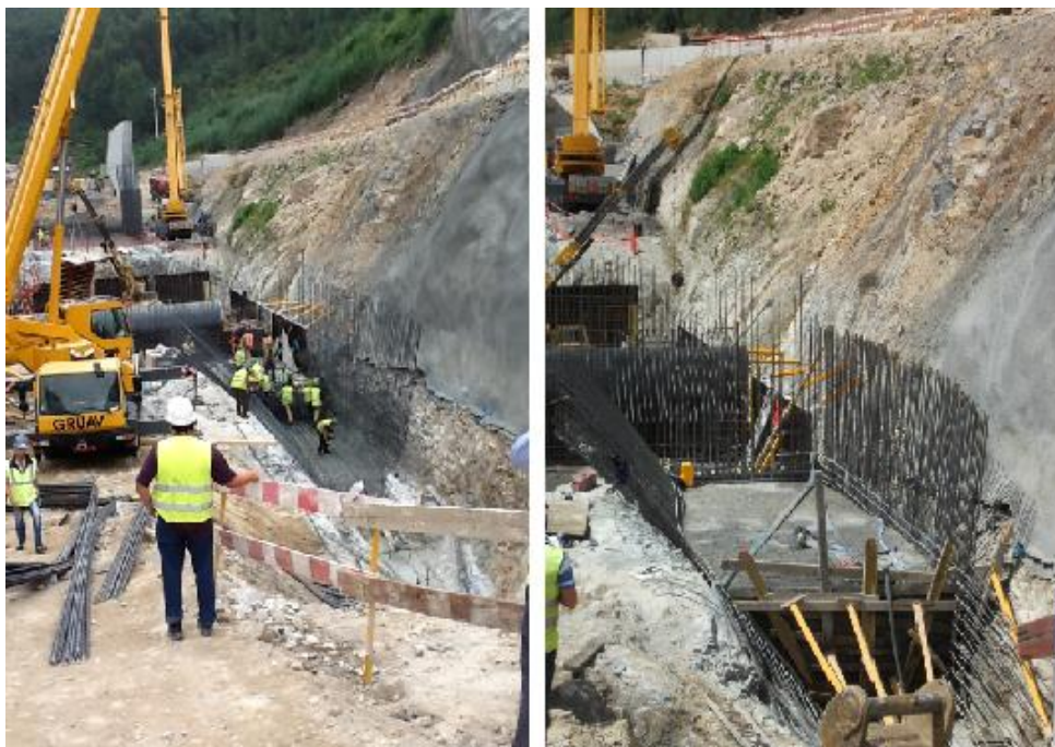
Figura 4.65 - Montagem da armadura e betonagem da primeira fase da recrava.
