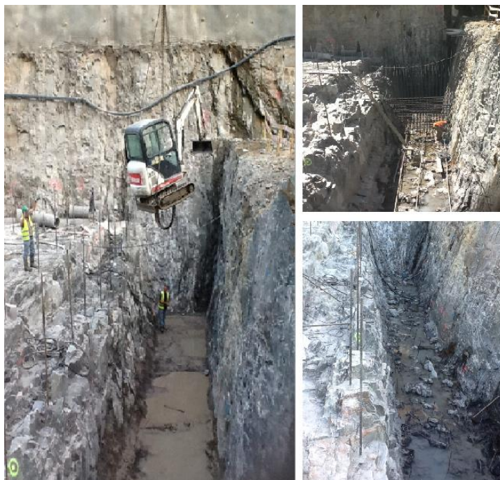
Figura 4.71 – Limpeza e montagem da armadura de encastramento do canal revestido
