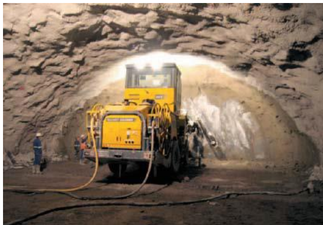
Figura 4.29 - Escavação da abóbada superior por perfuração com Jumbo.
