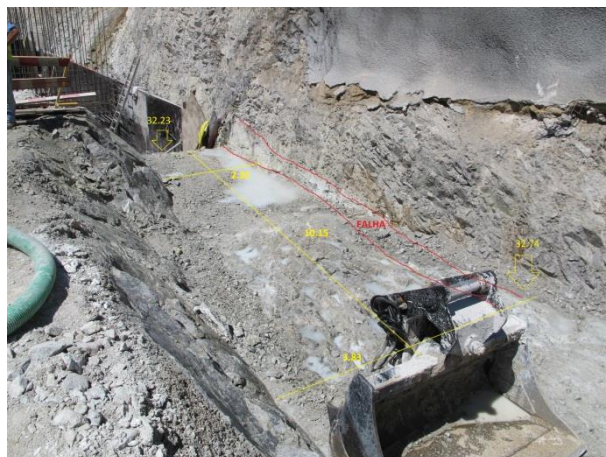
Figura 4.61 - Corqui inicial da falha
