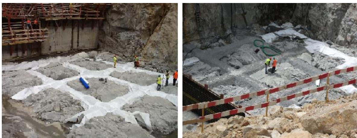
Figura 4.69 – Colocação das manilhas.
