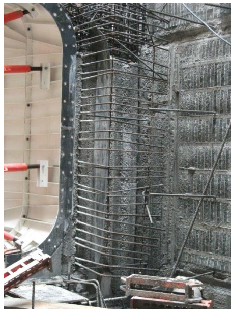
Figura 4.79 - Molde metálico
