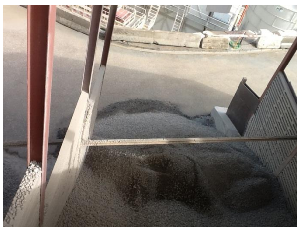
Figura 4.32 – Tolva de depósito de agregados.
