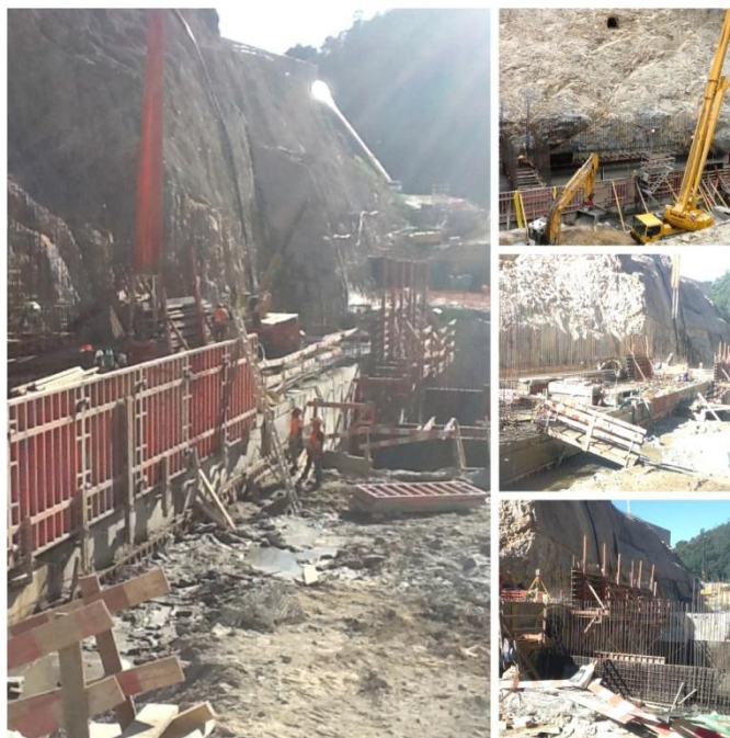
Figura 4.52 - Bloco depois de betonado (Ribeiradio).
