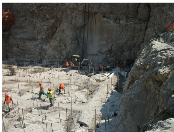
Figura 4.70 - Execução das pregagens
