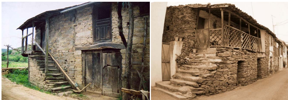
Fig.13 – Casas tradicionais transmontanas [17 e 18].
