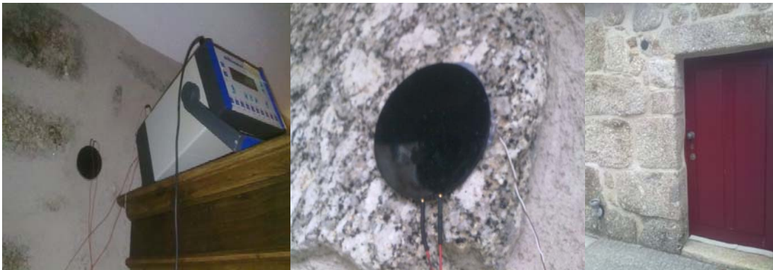
Fig.38 – Medição do fluxo de calor in situ (sistema de aquisição de dados, fluxímetros e termopares).
