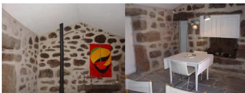
Fig.31 – Interior do Apartamento 2 (paredes sem isolamento).
