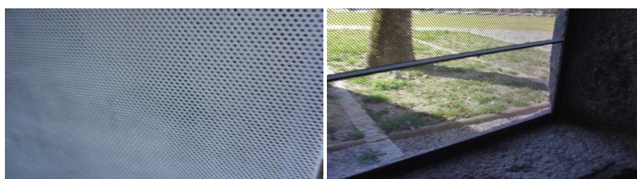
Fig.93 – Exemplo das janelas e portas dos elementos restantes.
