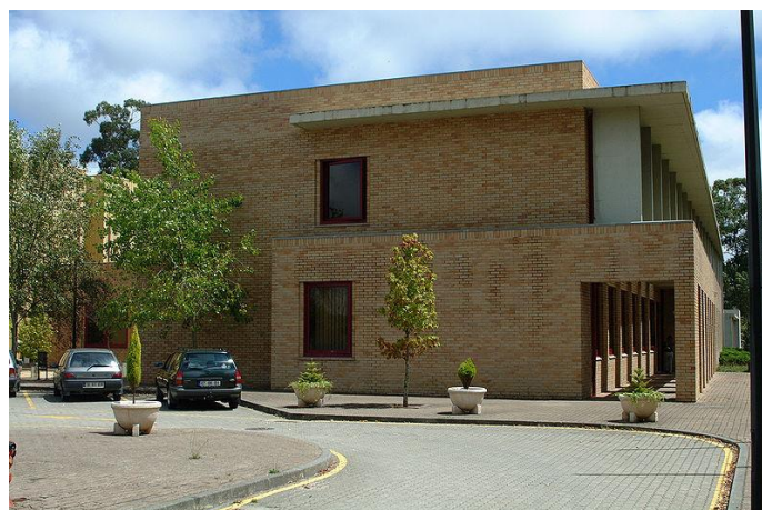
Figura 1. Fotografia do edifício do IDIT.
